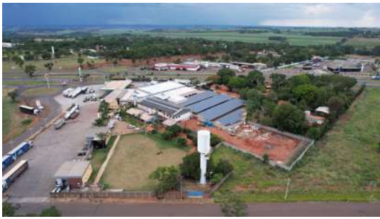
Foto 3 - Imagens captadas com auxílio de drone no dia 28/11/2022 no Reservatório Bandeirantes em Araraquara
