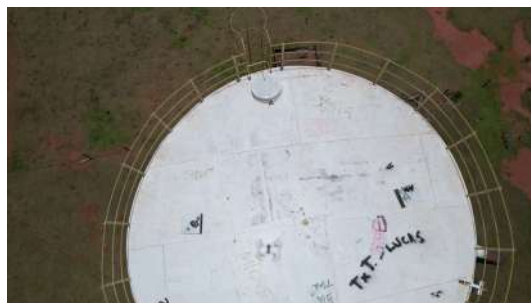
Foto 2 - Imagens captadas com auxílio de drone no dia 28/11/2022 das tampas de inspeção no Reservatório Universidade em Araraquara
