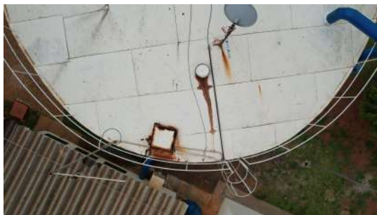
Foto 1 - Imagens captadas com auxílio de drone no dia 28/11/2022 das tampas de inspeção no Reservatório Flora em Araraquara
