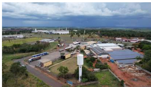
Foto 2 - Imagens captadas com auxílio de drone no dia 28/11/2022 no Reservatório Bandeirantes em Araraquara
