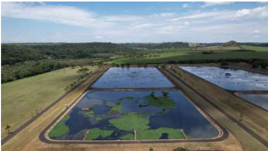
Foto 4 - Imagens captadas com auxílio de drone no dia 28/11/2022 da ETE Araraquara
