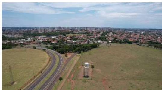
Foto 1 - Imagens captadas com auxílio de drone no dia 28/11/2022 no Reservatório Universidade em Araraquara
