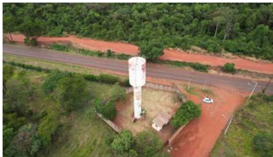
Foto 2 - Imagens captadas com auxílio de drone no dia 28/11/2022 do Reservatório Portal das Laranjeiras em Araraquara
