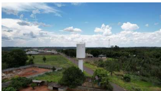
Foto 1 - Imagens captadas com auxílio de drone no dia 28/11/2022 no Reservatório Bandeirantes em Araraquara
