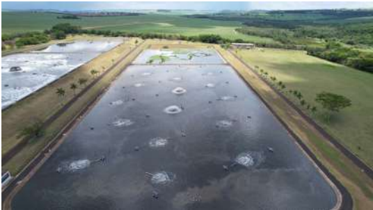
Foto 2 - Imagens captadas com auxílio de drone no dia 28/11/2022 da ETE Araraquara
