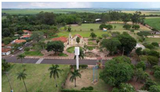
Foto 4 - Imagens captadas com auxílio de drone no dia 28/11/2022 do Reservatório Bueno de Andrade em Araraquara
