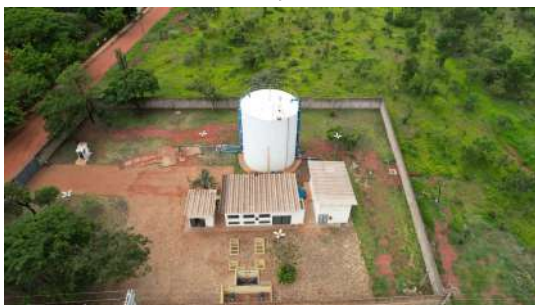
Foto 5 - Imagens captadas com auxílio de drone no dia 28/11/2022 no Reservatório Flora em Araraquara
