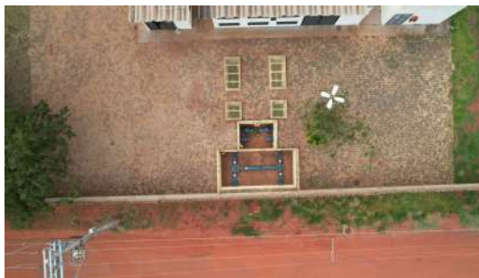
Foto 4 - Imagens captadas com auxílio de drone no dia 28/11/2022 no Reservatório Flora em Araraquara
