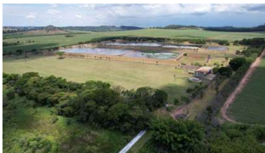
Foto 8 - Imagens captadas com auxílio de drone no dia 28/11/2022 da ETE Araraquara
