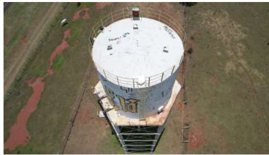
Foto 2 - Imagens captadas com auxílio de drone no dia 28/11/2022 da tubulação de ventilação no Reservatório Universidade em Araraquara
