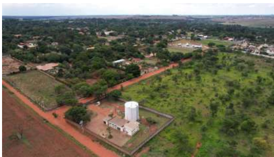
Foto 3 - Imagens captadas com auxílio de drone no dia 28/11/2022 no Reservatório Flora em Araraquara
