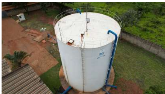
Foto 2 - Imagens captadas com auxílio de drone no dia 28/11/2022 do guarda-corpo no Reservatório Flora em Araraquara
