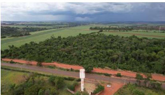
Foto 3 - Imagens captadas com auxílio de drone no dia 28/11/2022 do Reservatório Portal das Laranjeiras em Araraquara
