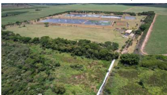
Foto 11 - Imagens captadas com auxílio de drone no dia 28/11/2022 da ETE Araraquara
