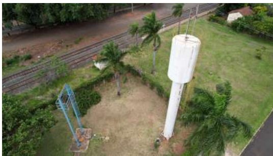
Foto 3 - Imagens captadas com auxílio de drone no dia 28/11/2022 do Reservatório Bueno de Andrade em Araraquara
