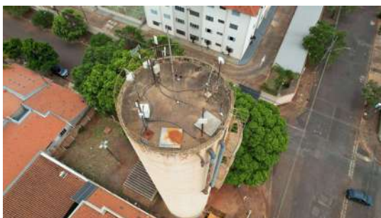
Foto 1 - Imagens captadas com auxílio de drone no dia 28/11/2022 da tubulação de ventilação no Reservatório R28 de Araraquara
