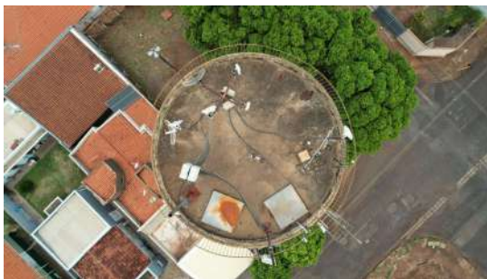
Foto 1 - Imagens captadas com auxílio de drone no dia 28/11/2022 das tampas de inspeção no Reservatório R28 de Araraquara
