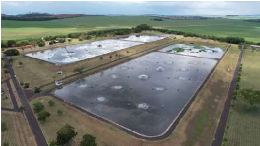
Foto 1 - Imagens captadas com auxílio de drone no dia 28/11/2022 da ETE Araraquara
