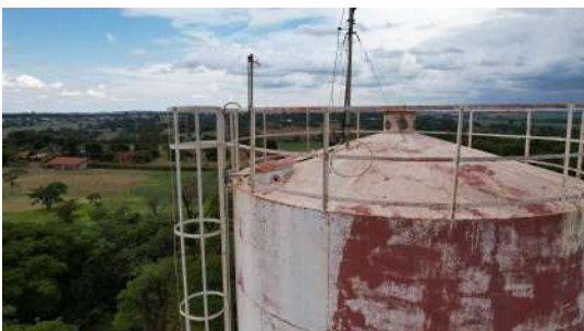
Foto 1 - Imagens captadas com auxílio de drone no dia 28/11/2022 da tubulação de ventilação do Reservatório Portal das Laranjeiras em Araraquara
