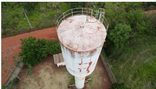
Foto 1 - Imagens captadas com auxílio de drone no dia 28/11/2022 do para-raios do Reservatório Portal das Laranjeiras em Araraquara
