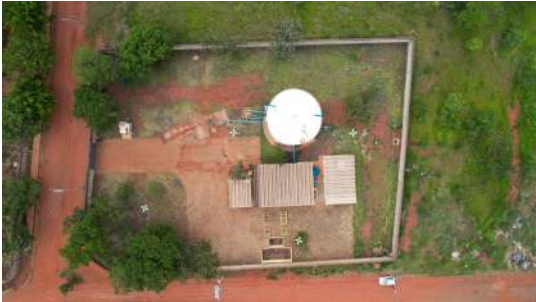
Foto 2 - Imagens captadas com auxílio de drone no dia 28/11/2022 no Reservatório Flora em Araraquara
