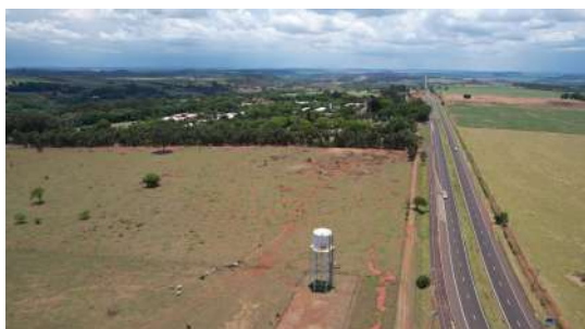
Foto 3 - Imagens captadas com auxílio de drone no dia 28/11/2022 no Reservatório Universidade em Araraquara
