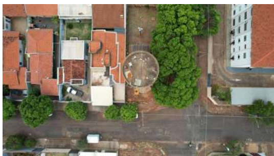
Foto 1 - Imagens captadas com auxílio de drone no dia 28/11/2022 no Reservatório R28 de Araraquara
