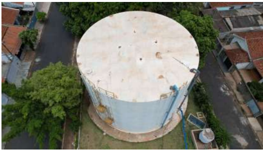
Foto 1 - Imagens captadas com auxílio de drone no dia 28/11/2022 do guarda-corpos no R25 em Araraquara
