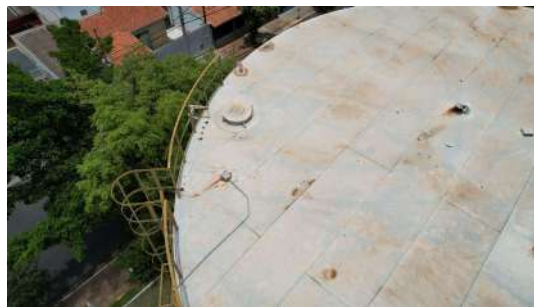
Foto 2 - Imagens captadas com auxílio de drone no dia 28/11/2022 da tampa de inspeção no R25 em Araraquara
