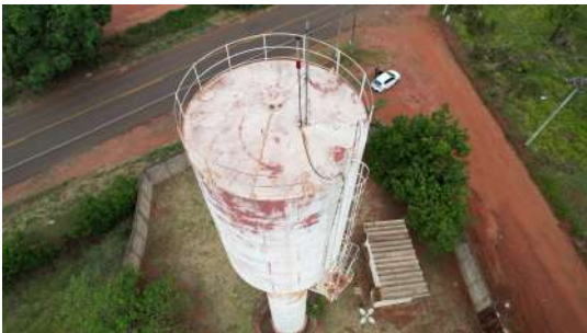
Foto 1 - Imagens captadas com auxílio de drone no dia 28/11/2022 do guarda-corpos do Reservatório Portal das Laranjeiras em Araraquara
