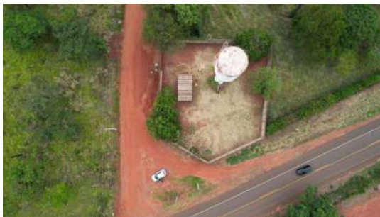
Foto 1 - Imagens captadas com auxílio de drone no dia 28/11/2022 do Reservatório Portal das Laranjeiras em Araraquara
