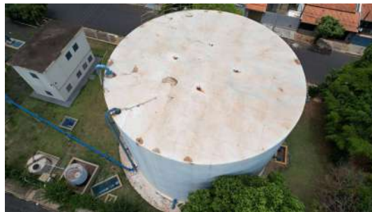
Foto 2 - Imagens captadas com auxílio de drone no dia 28/11/2022 da tubulação de ventilação no R25 em Araraquara
