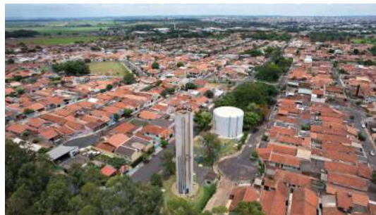
Foto 2 - Imagens captadas com auxílio de drone no dia 28/11/2022 no Reservatório R11 em Araraquara
