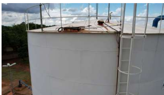
Foto 2 - Imagens captadas com auxílio de drone no dia 28/11/2022 da tubulação de ventilação no Reservatório Flora em Araraquara
