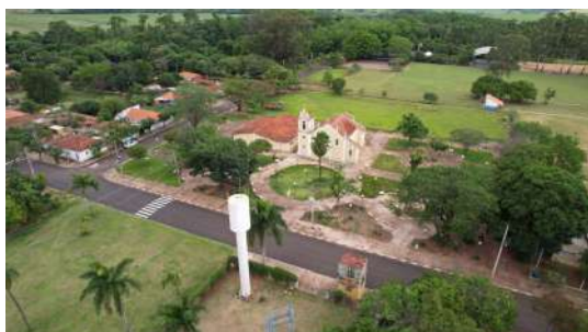
Foto 1 - Imagens captadas com auxílio de drone no dia 28/11/2022 do Reservatório Bueno de Andrade em Araraquara
