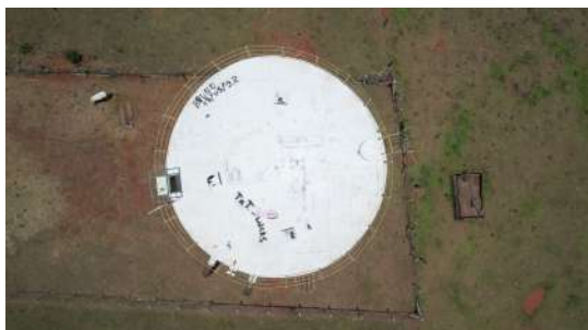
Foto 1 - Imagens captadas com auxílio de drone no dia 28/11/2022 das tampas de inspeção no Reservatório Universidade em Araraquara
