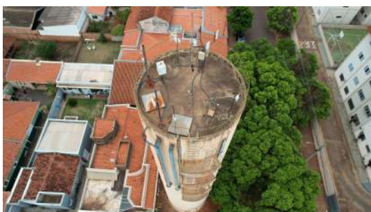
Foto 1 - Imagens captadas com auxílio de drone no dia 28/11/2022 do guarda-corpo no Reservatório R28 de Araraquara
