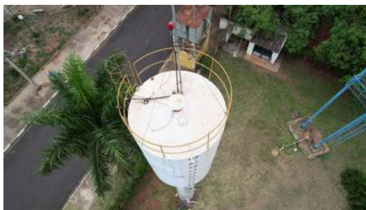
Foto 2 - Imagens captadas com auxílio de drone no dia 28/11/2022 da tubulação de ventilação do Reservatório Bueno de Andrade em Araraquara
