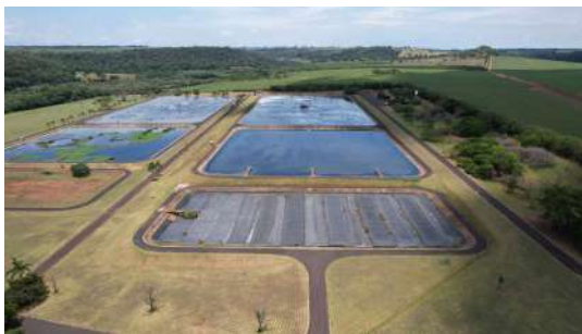
Foto 5 - Imagens captadas com auxílio de drone no dia 28/11/2022 da ETE Araraquara
