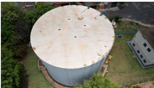
Foto 1 - Imagens captadas com auxílio de drone no dia 28/11/2022 da tampa de inspeção no R25 em Araraquara
