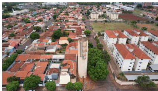
Foto 2 - Imagens captadas com auxílio de drone no dia 28/11/2022 no Reservatório R28 de Araraquara
