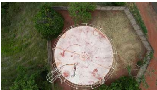
Foto 1 - Imagens captadas com auxílio de drone no dia 28/11/2022 da tampa de inspeção do Reservatório Portal das Laranjeiras em Araraquara
