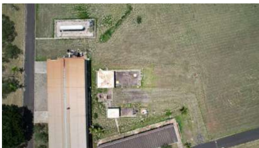
Foto 7 - Imagens captadas com auxílio de drone no dia 28/11/2022 da ETE Araraquara
