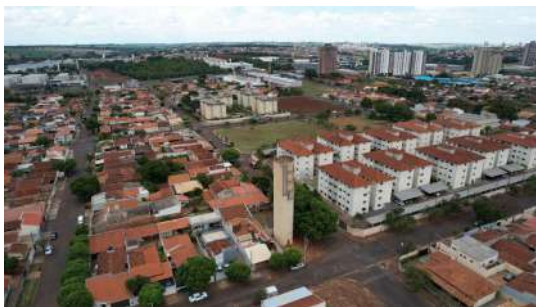
Foto 3 - Imagens captadas com auxílio de drone no dia 28/11/2022 no Reservatório R28 de Araraquara
