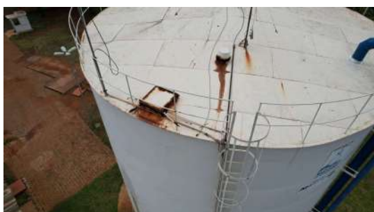
Foto 1 - Imagens captadas com auxílio de drone no dia 28/11/2022 da tubulação de ventilação no Reservatório Flora em Araraquara
