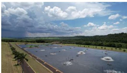
Foto 10 - Imagens captadas com auxílio de drone no dia 28/11/2022 da ETE Araraquara
