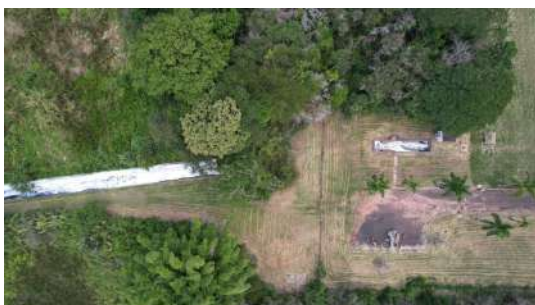
Foto 9 - Imagens captadas com auxílio de drone no dia 28/11/2022 da ETE Araraquara
