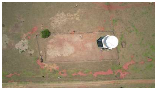
Foto 2 - Imagens captadas com auxílio de drone no dia 28/11/2022 no Reservatório Universidade em Araraquara
