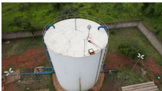
Foto 3 - Imagens captadas com auxílio de drone no dia 28/11/2022 da tubulação de ventilação no Reservatório Flora em Araraquara
