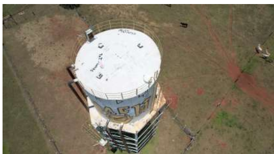
Foto 1 - Imagens captadas com auxílio de drone no dia 28/11/2022 no Reservatório Universidade em Araraquara
