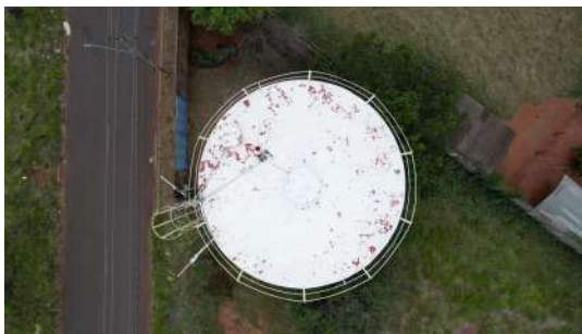
Foto 1 - Imagens captadas com auxílio de drone no dia 28/11/2022 da tampa de inspeção no Reservatório Bandeirantes em Araraquara
