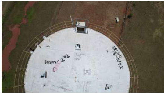
Foto 1 - Imagens captadas com auxílio de drone no dia 28/11/2022 da tubulação de ventilação no Reservatório Universidade em Araraquara
