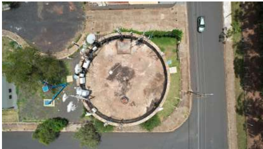
Foto 1 - Imagens captadas com auxílio de drone no dia 28/11/2022 no Reservatório R11 em Araraquara
