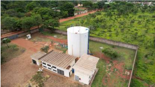
Foto 1 - Imagens captadas com auxílio de drone no dia 28/11/2022 no Reservatório Flora em Araraquara
