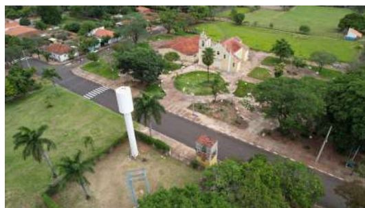
Foto 2 - Imagens captadas com auxílio de drone no dia 28/11/2022 do Reservatório Bueno de Andrade em Araraquara
