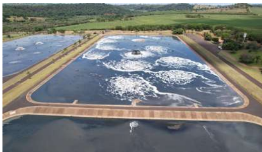
Foto 6 - Imagens captadas com auxílio de drone no dia 28/11/2022 da ETE Araraquara
