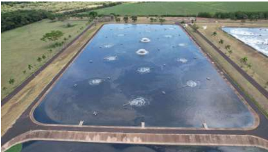
Foto 3 - Imagens captadas com auxílio de drone no dia 28/11/2022 da ETE Araraquara
