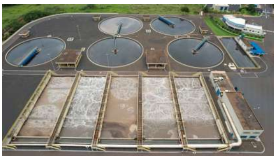
Foto 3 - Vista superior do lodos ativados
