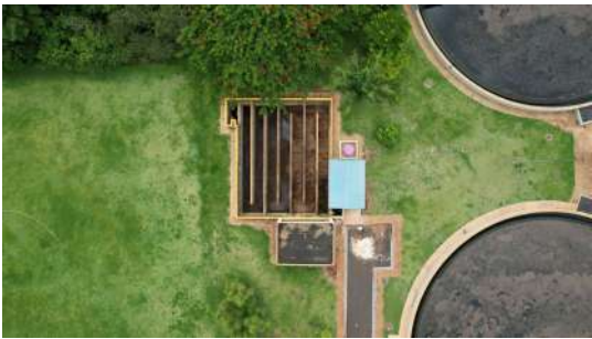
Foto 4 - Vista superior da desinfecção
