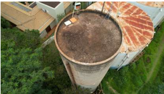
Foto 2 - Vista superior do reservatório City Ribeirão elevado
