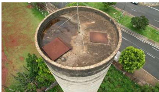
Foto 2 - Vista superior do reservatório Maria Casagrande
