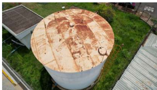
Foto 2 - Vista superior do reservatório São José
