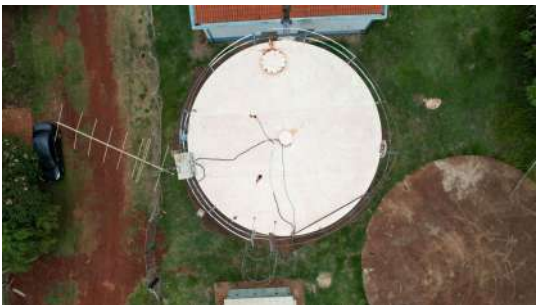
Foto 3 - Vista superior da cobertura do reservatório Jardim Recreio
