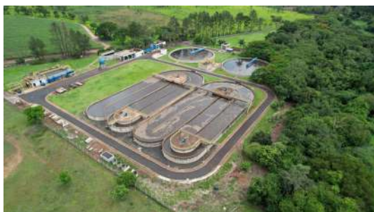
Foto 1 - Vista superior da ETE Caiçara
