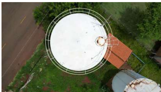
Foto 1 - Vista superior do Reservatório Santa Cecília (elevado)
