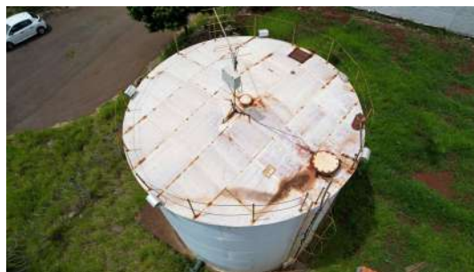
Foto 2 - Vista superior do reservatório Santa Cecília (apoiado)
