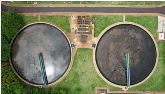
Foto 3 - Vista superior do sistema de lodos ativados
