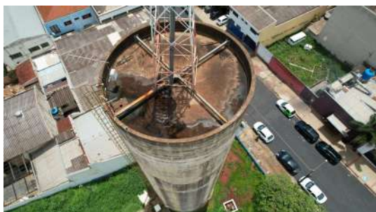
Foto 1 - Tampa de inspeção
