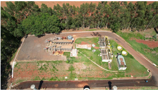
Foto 2 - Vista superior lateral da ETE Laranja Azeda
