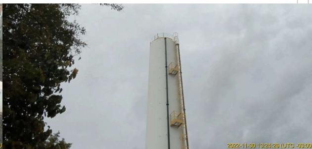
Foto 4 - Vista da parte superior do reservatório.
