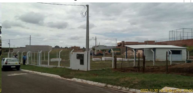
Foto 6 - Vista geral externa da EEEB.
