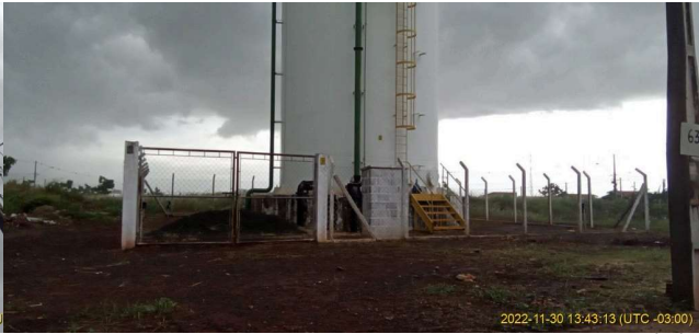
Foto 2 - Vista geral externa do reservatório.
