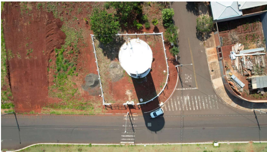
Foto 1 - Vista superior do local
