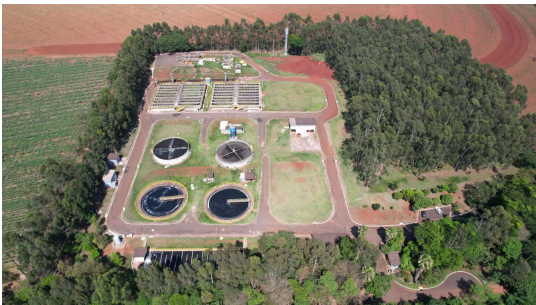
Foto 1 - Vista superior do local
