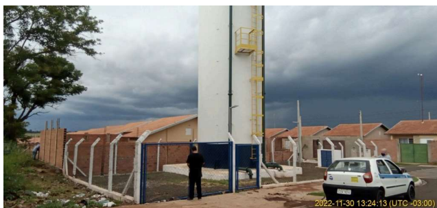
Foto 5 - Vista geral externa do reservatório.
