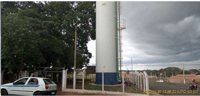
Foto 5 - Vista geral externa do reservatório.
