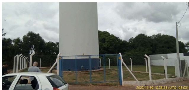
Foto 5 - Vista externa do reservatório.
