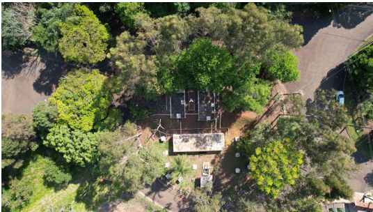
Foto 1 - Vista superior do local
