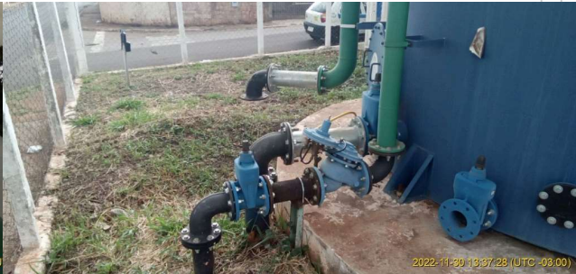
Foto 2 - Vista do tubo extravasor
