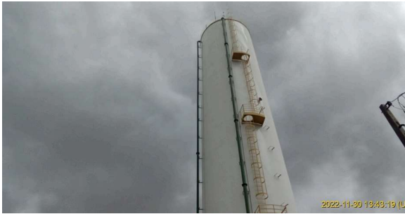
Foto 1 - Vista da parte superior do reservatório.
