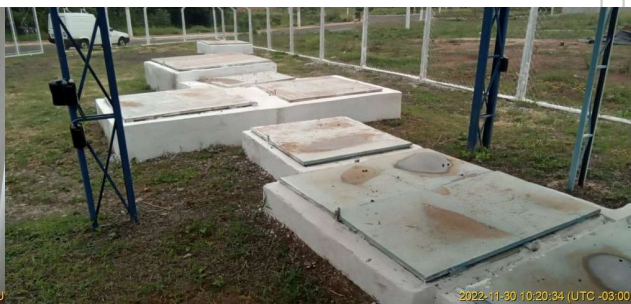
Foto 4 - Vista geral interna da EEEB.
