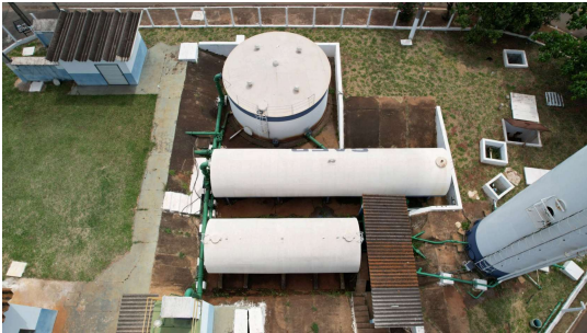
Foto 4 - Vista superior da cobertura do reseqvatórios ETA Santa Fé (apoiados)
