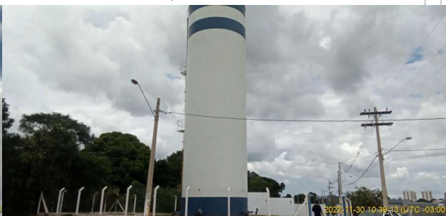
Foto 4 - Vista externa do reservatório.
