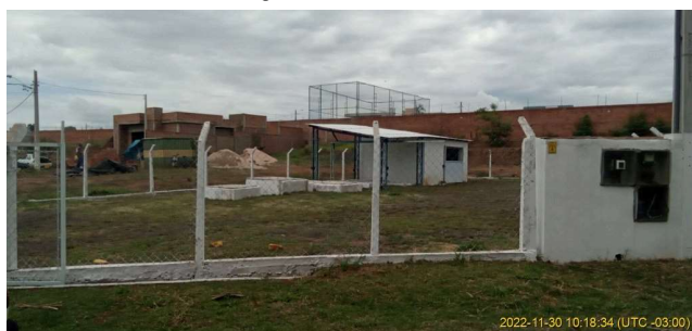
Foto 7 - Vista geral externa da EEEB.
