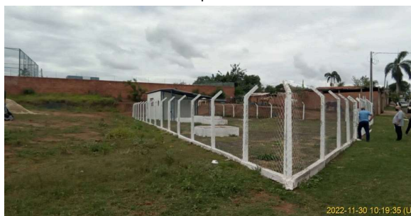
Foto 5 - Vista geral externa da EEEB.
