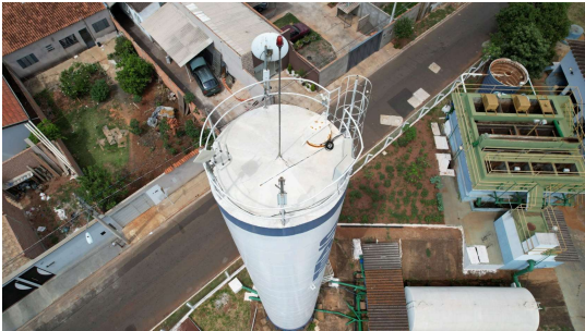
Foto 3 - Vista superior do reservatório ETA Santa Fé (elevado)
