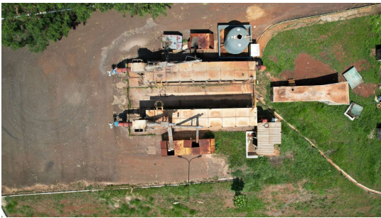
Foto 3 - Vista superior do tratamento preliminar
