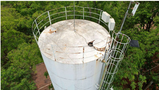
Foto 2 - Vista superior do reservatório elevado Cachoeira
