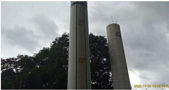
Foto 4 - Vista superior do reservatório.
