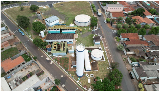
Foto 1 - Vista superior do local
