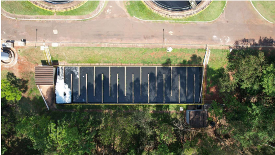
Foto 6 - Vista superior do tanque de desinfecção
