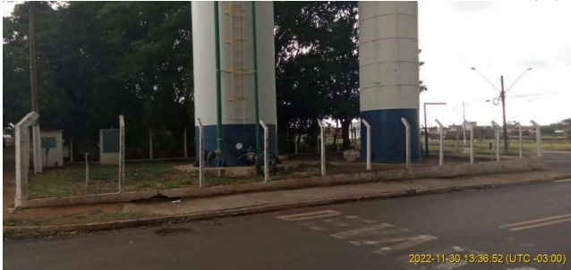
Foto 3 - Vista geral externa do reservatório.
