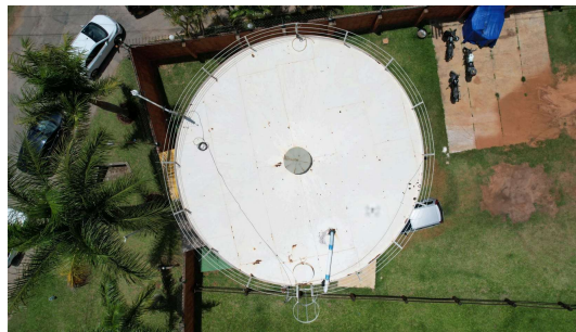
Foto 2 - Vista superior do reservatório.
