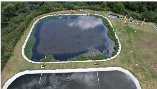
Foto 4 - Detalhe da lagoa anaeróbia.
