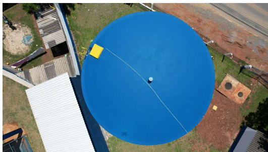
Foto 2 - Vista superior do reservatório.
