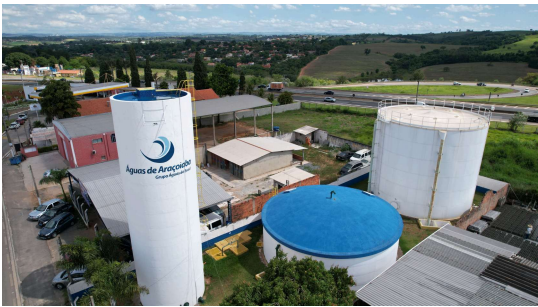
Foto 1 - Vista geral dos reservatórios Tonelli.
