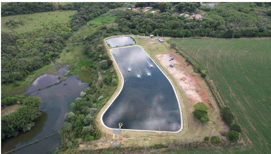
Foto 2 - Vista Geral 2 da ETE Vacariú.
