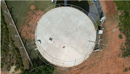
Foto 3 - Vista superior do reservatório 1.
