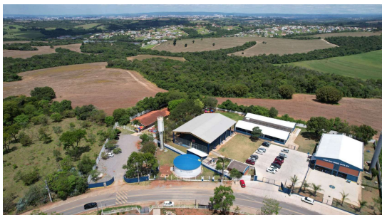
Foto 1 - Vista geral do reservatório Araçoiabinha.
