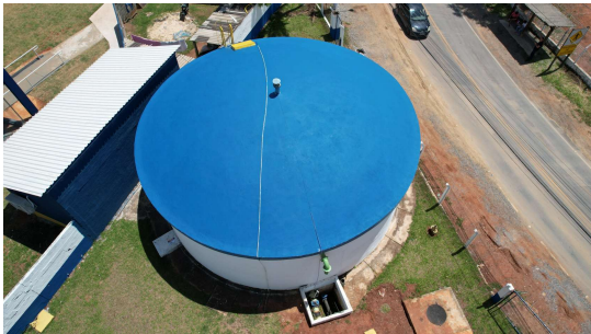
Foto 1 - Detalhe do extravasor.
