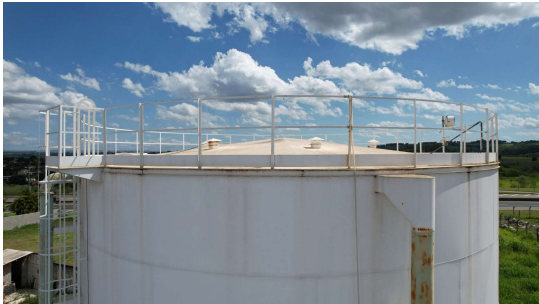
Foto 1 - Ventilação do reservatório.
