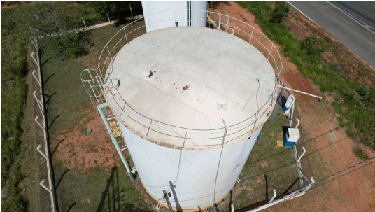
Foto 4 - Vista lateral do reservatório 1.
