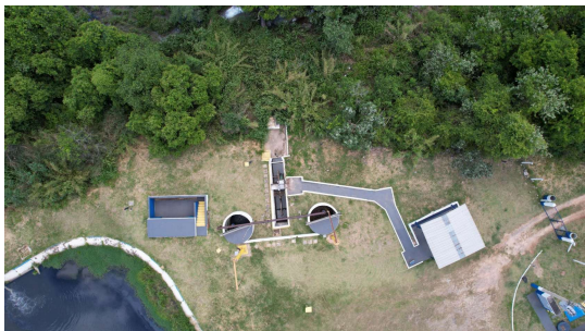
Foto 3 - Chegada do esgoto bruto e gradeamento na ETE.
