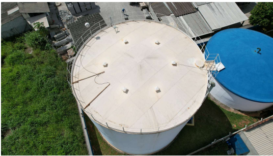
Foto 4 - Detalhe do topo do reservatório.
