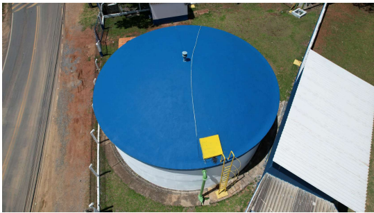
Foto 1 - Tampa de inspeção em boas condições.
