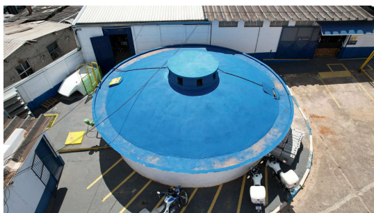
Foto 3 - Vista lateral do reservatório.
