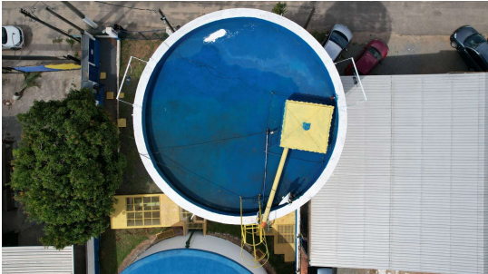
Foto 1 - Tampa de inspeção em boas condições.
