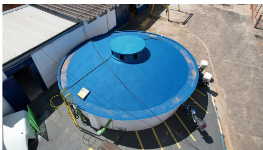
Foto 1 - Detalhe da escada e tampa de inspeção em bom estado.
