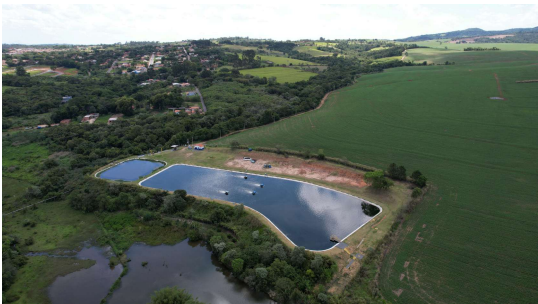
Foto 1 - Vista geral 1 da ETE Vacariú.
