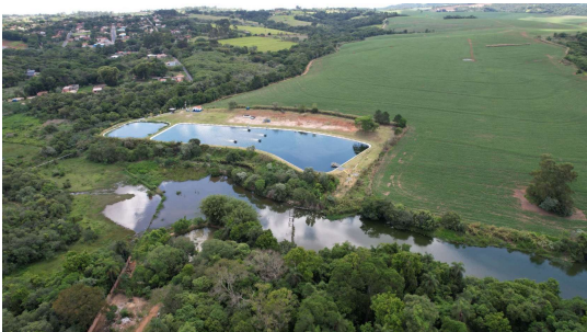
Foto 8 - Vista do corpo hídrico e da ETE Vacariú.
