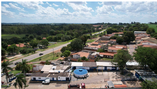
Foto 1 - Vista geral do Reservatório SEDE.
