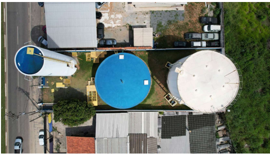
Foto 2 - Vista superior dos reservatórios.
