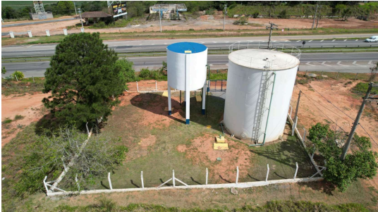
Foto 1 - Vista geral dos Reservatórios Alvorada.
