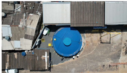
Foto 2 - Vista superior do reservatório.
