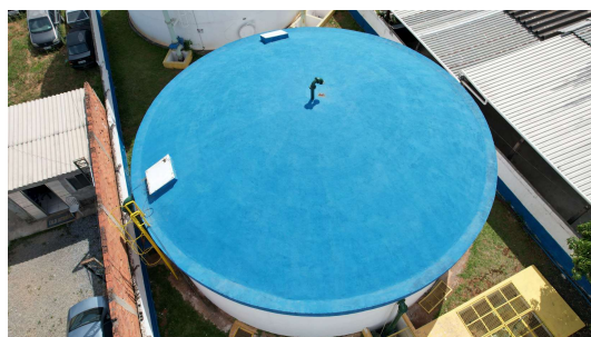
Foto 2 - Vista lateral do reservatório.
