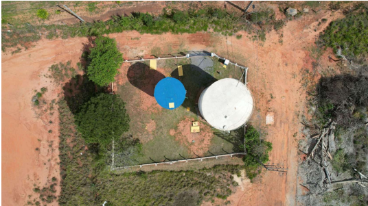
Foto 2 - Vista superior dos reservatórios Alvorada.
