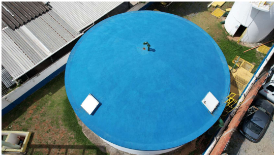
Foto 1 - Detalhe das tampas de inspeção em boa condição e ventilação no topo do reservatório.
