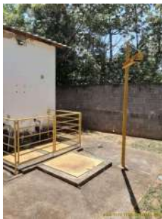
Foto 1 - Estrutura disponível para manutenção no gradeamento.
