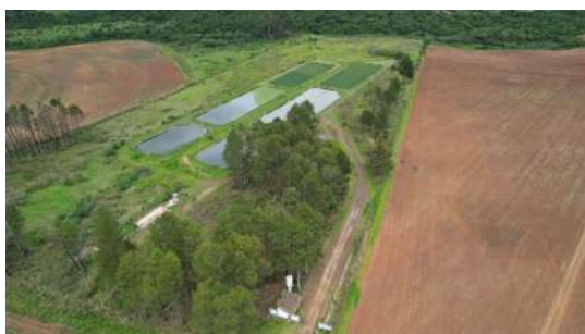
Foto 1 - Vista geral 1 da ETE Ajapi.
