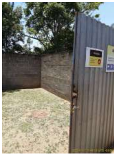
Foto 1 - Detalhe do cercamento.
