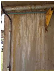
Foto 17 - Detalhe dos reparos pontuais feitos ao longo de parte das estruturas da ETE.
