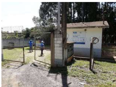
Foto 1 - Vista geral da EEE Boa vista.
