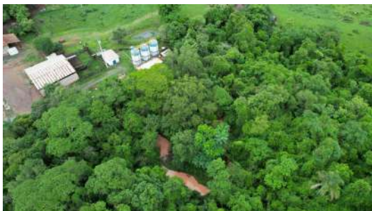
Foto 1 - Vista geral 1 da ETE Assistência.
