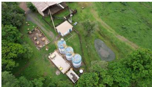
Foto 2 - Vista geral 2 da ETE.
