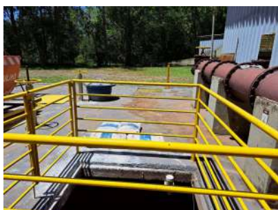
Foto 7 - Poço da EEE ETE Conduta
