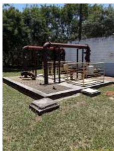
Foto 1 - De acordo com o Prestador, a manutenção no local também é feita com o auxílio de Munck.
