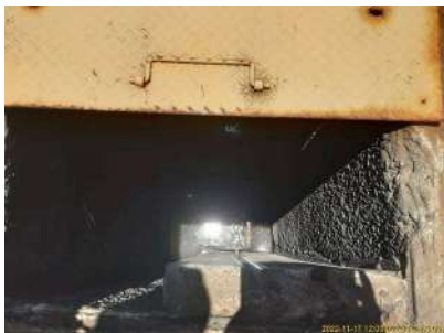
Foto 1 - Detalhe do poço da EEE.
