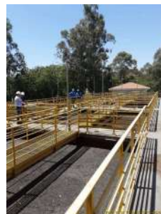
Foto 22 - Vista dos decantadores.
