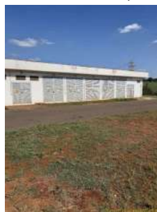
Foto 20 - Casa de geradores.
