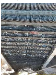
Foto 13 - Gradeamento fino em operação na chegada do esgoto bruto na ETE.
