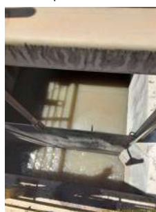
Foto 12 - Detalhe do tanque de chegada junto aos gradeamentos.
