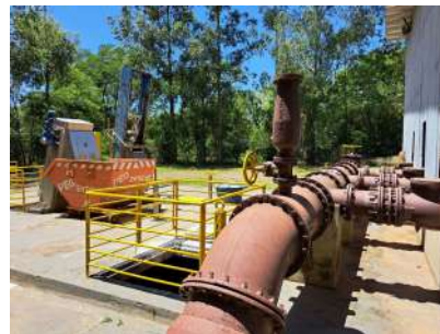
Foto 2 - Vista geral 2 da EEE ETE Conduta
