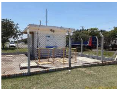
Foto 1 - Vista geral 1 da EEE.
