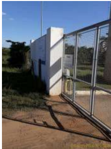
Foto 1 - Cercamento adequado em torno de todo o perímetro.
