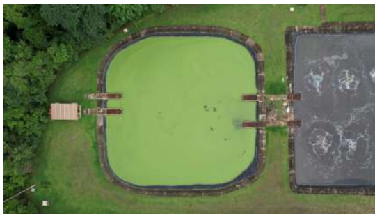
Foto 3 - Detalhe da lagoa anaeróbica.
