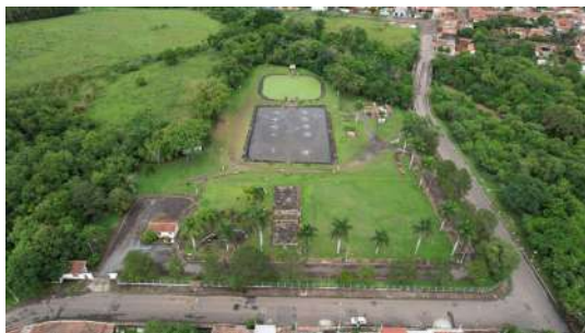
Foto 1 - Vista geral da ETE Jardim Palmeiras.
