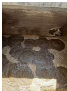
Foto 28 - Tanque para acúmulo de efluente junto à centrifugação.
