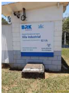
Foto 1 - Identificação do local.
