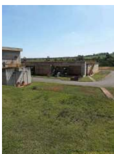
Foto 4 - Vista geral das instalações do sistema NEREDA.
