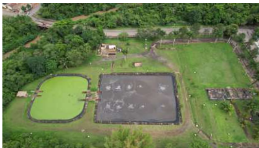
Foto 2 - Vista das lagoas da ETE.
