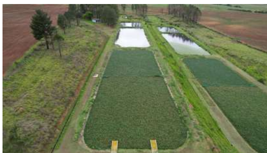
Foto 4 - Detalhe 2 das lagoas da ETE.
