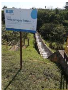
Foto 19 - Escada hidráulica na saída da ETE para aeração do efluente tratado.
