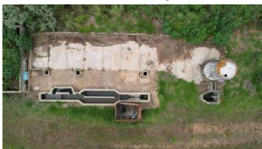
Foto 5 - Calha Parshall na chegada do esgoto bruto.
