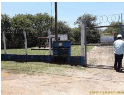
Foto 1 - Vista geral das instalações.
