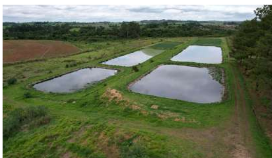
Foto 2 - Vista geral 2 da ETE Ajapi.
