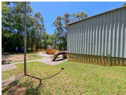
Foto 1 - Vista geral 1 da EEE ETE Conduta
