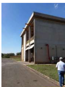
Foto 22 - Edificação das centrífugas para secagem do lodo.
