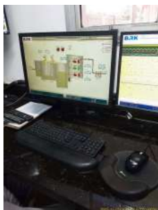
Foto 7 - Monitor 1 para controle e acompanhamento dos subsistemas em operação.
