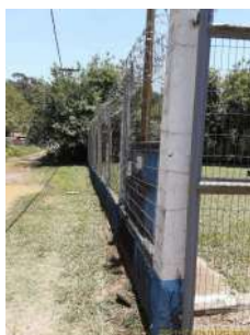
Foto 1 - Detalhe do cercamento local.
