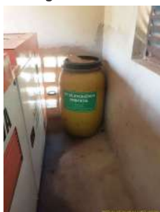
Foto 3 - Kit de emergência ambiental junto ao gerador.
