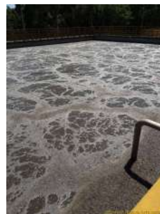
Foto 19 - Tanque de aerção.
