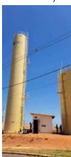
Foto 3 - Reservatórios Jd Santa Maria - apoiado (direita), casa de bombas da estação elevatória (centro, não está operando) e elevado (esquerda, inativo)
