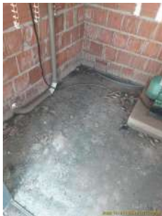
Foto 1 - Detalhe da situação do interior da EEAT 1
