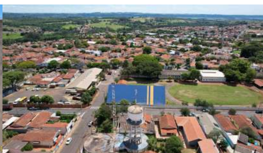
Foto 4 - Vista geral - Reservatórios apoiados e elevado Polícia Militar
