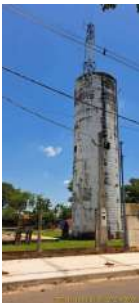
Foto 2 - Vista frontal do Reservatório elevado Campos Elísios I
