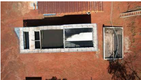
Foto 6 - Uma das duas unidades de tratamento biológico (esquerda) e leito de secagem de lodo (direita) - ETE Patrimônio
