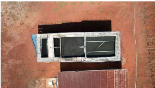
Foto 5 - Uma das duas unidades de tratamento biológico - ETE Patrimônio
