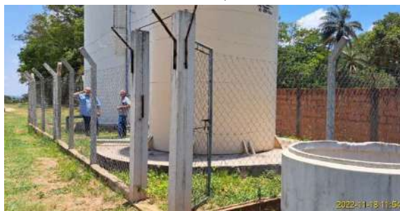
Foto 3 - Vista geral do Sistema de Reservação Campos Elísios II
