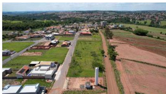
Foto 5 - Vista geral - Reservatório Santa Amélia
