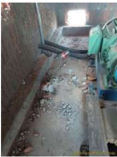
Foto 1 - Detalhe da situação do interior da EEAT 2
