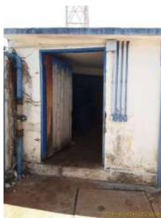
Foto 1 - Vista da entrada da estação elevatória
