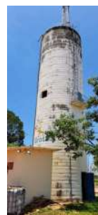
Foto 4 - Vista lateral do Reservatório elevado Campos Elísios I
