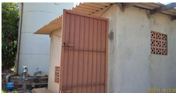
Foto 4 - Vista da entrada da estação elevatória
