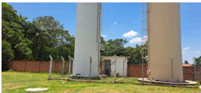
Foto 2 - Vista geral do Sistema de Reservação Campos Elísios II - antigo (cor branca) e novo (cor amarela)
