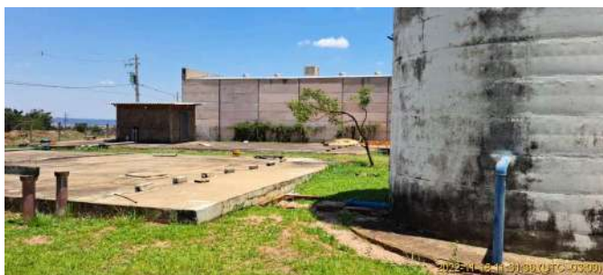
Foto 3 - Vista geral dos Reservatórios elevado e enterrados Campos Elísios I
