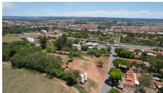
Foto 2 - Vista geral - Reservatórios Boa Vista
