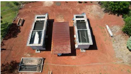
Foto 3 - Vista geral - ETE Patrimônio
