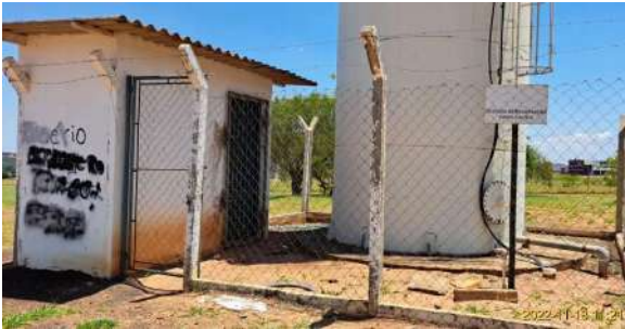
Foto 1 - Vista frontal do Reservatório elevado Santa Cecília
