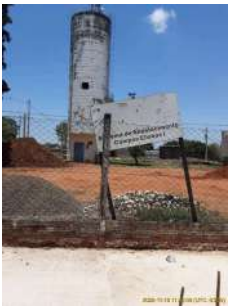
Foto 1 - Placa do Sistema de Abastecimento Campos Elísios I.
