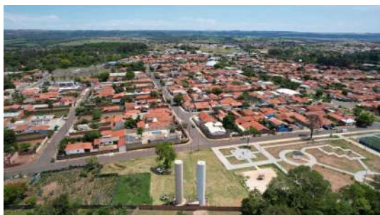
Foto 5 - Vista geral - Reservatórios elevados Campos Elísios II - antigo à direita e novo à esquerda
