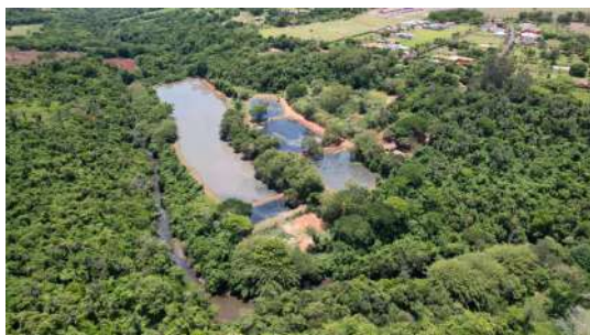
Foto 1 - Vista Geral - ETE Cidade
