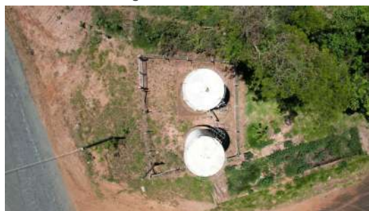
Foto 4 - Vista geral - Reservatórios Boa Vista
