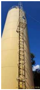
Foto 1 - Guarda-corpos e escada do Reservatório
