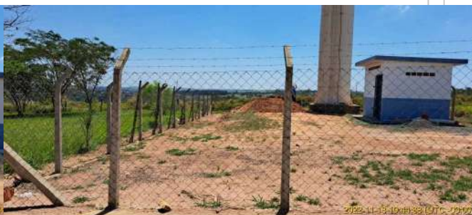
Foto 2 - Vista geral do Reservatório elevado Santa Amélia
