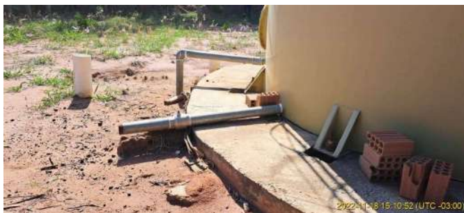
Foto 5 - Vista geral da base do Reservatório elevado Broa novo
