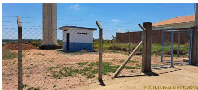
Foto 3 - Vista geral do Reservatório elevado Santa Amélia
