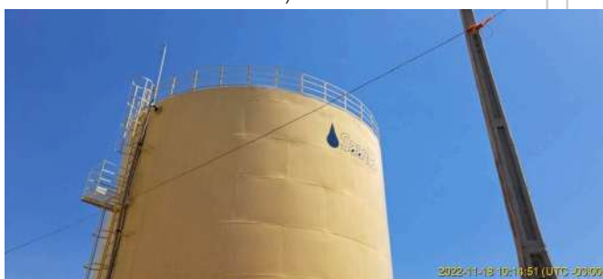
Foto 4 - Reservatório apoiado Jd Santa Maria
