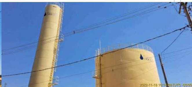
Foto 2 - Reservatórios Jd Santa Maria - apoiado (direita), casa de bombas da estação elevatória (centro, não está operando) e elevado (esquerda, inativo)
