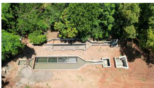
Foto 3 - Chegada de esgoto bruto e tratamento preliminar - ETE Cidade
