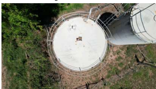
Foto 5 - Vista da cobertura de um dos reservatórios Boa Vista
