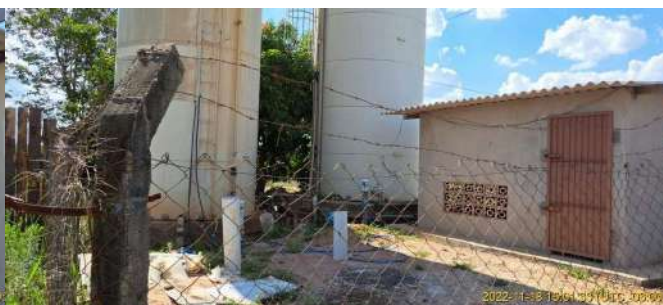
Foto 5 - Vista geral da estação elevatória e reservatórios elevados do Broa
