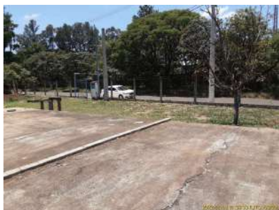
Foto 1 - Vista de dentro para fora do Sistema de Abastecimento Campos Elísios I
