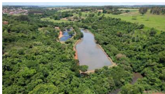
Foto 2 - Vista Geral - ETE Cidade
