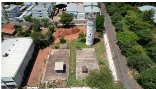
Foto 5 - Vista geral - Reservatórios enterrados e elevado Campos Elísios I
