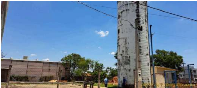
Foto 1 - Vista frontal do Reservatório elevado Campos Elísios I
