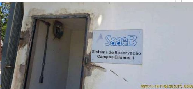
Foto 4 - Placa de identificação do Sistema de Reservação Campos Elísios II
