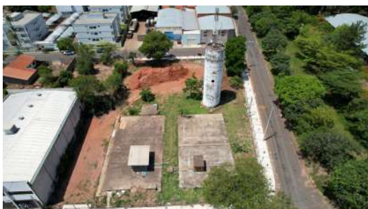
Foto 3 - Vista superior dos Reservatórios enterrados e das estações elevatórias respectivas, bem como do Reservatório elevado Campos Elísios I ao fundo
