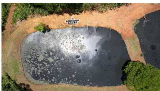
Foto 5 - Vista da última lagoa anaeróbia com nova estrutura de distribuição de entrada do esgoto - ETE Cidade
