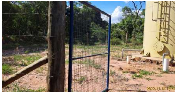
Foto 3 - Vista da entrada do Reservatório elevado Broa novo
