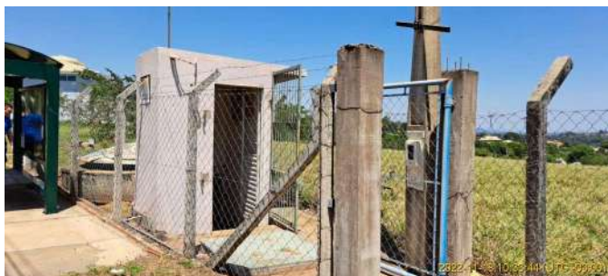
Foto 1 - Vista geral da estação elevatória
