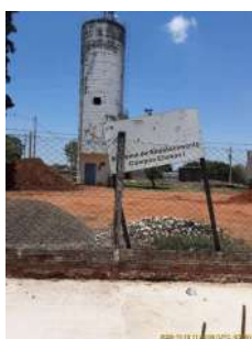
Foto 1 - Placa de identificação da área
