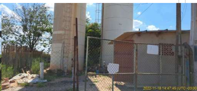
Foto 2 - Vista geral dos reservatórios elevados e da estação elevatória do Broa
