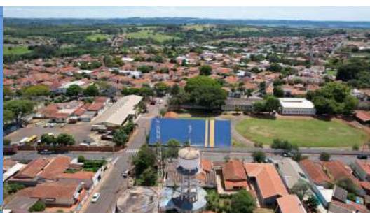
Foto 2 - Vista geral - Reservatórios apoiados e elevado Polícia Militar
