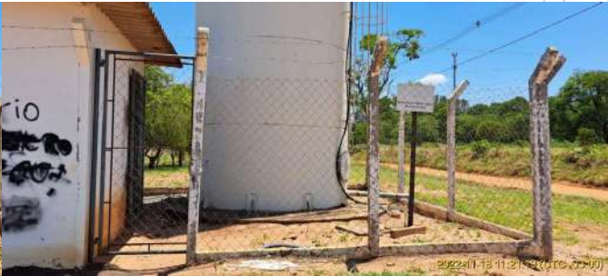
Foto 2 - Vista frontal do Reservatório elevado Santa Cecília
