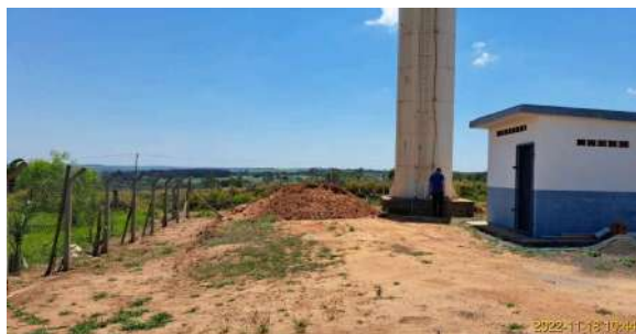
Foto 1 - Vista geral do Reservatório elevado Santa Amélia
