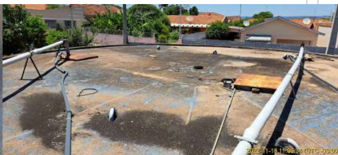
Foto 2 - Tampa de inspeção do segundo reservatório semienterrado
