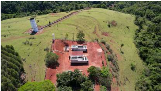
Foto 2 - Vista geral - ETE Patrimônio
