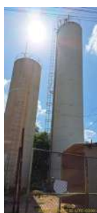
Foto 3 - Vista geral dos dois reservatórios elevados do Broa
