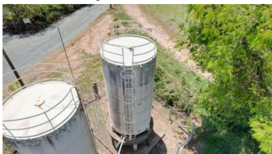
Foto 3 - Vista geral - Reservatórios Boa Vista
