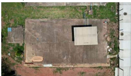
Foto 5 - Vista superior de um dos reservatórios enterrados, com a estação elevatória que recalca para o Reservatório elevado Campos Elísios I e Campos Elísios II
