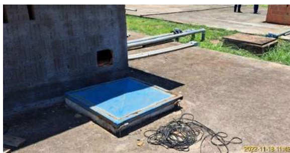
Foto 1 - Tapa de inspeção do reservatório enterrado
