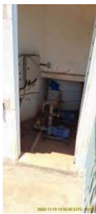
Foto 1 - Vista da entrada para o abrigo dos conjuntos motobomba.
