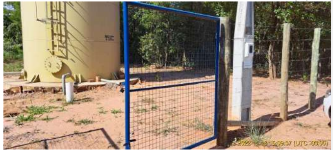
Foto 2 - Vista da entrada do Reservatório elevado Broa novo
