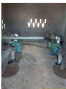
Foto 3 - Conjuntos motobomba da EEAT 2 - um conjunto recalca para o reservatório elevado Campos Elísios I e o outro, para os reservatórios elevados Campos Elísios II
