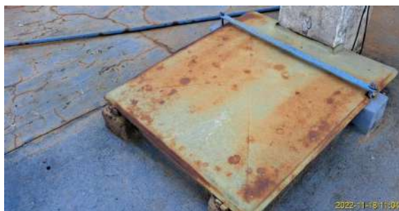
Foto 1 - Tampa de inspeção de um dos reservatórios semienterrados
