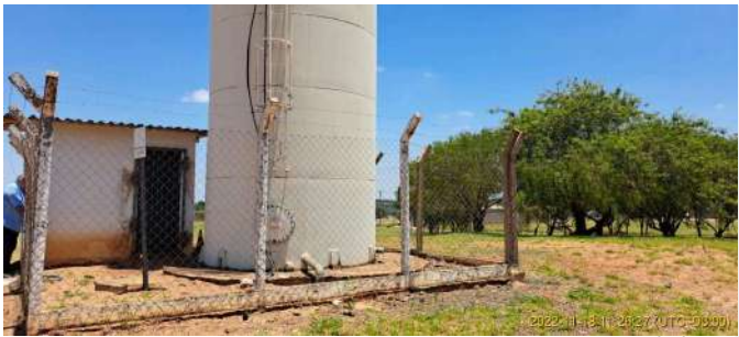
Foto 4 - Vista frontal do Reservatório elevado Santa Cecília
