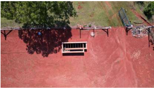
Foto 7 - Tanque de contato (desinfecção) - ETE Patrimônio
