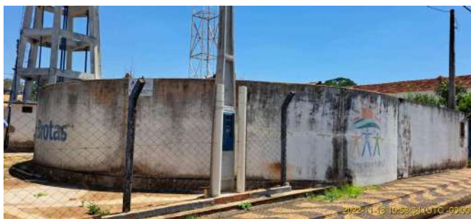
Foto 2 - Vista do Sistema Polícia Militar, com dois reservatórios semienterrados, um reservatório elevado e a estação elevatória
