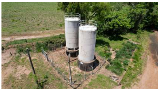
Foto 1 - Vista geral - Reservatórios Boa Vista
