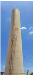
Foto 3 - Vista do Reservatório elevado Santa Cecília
