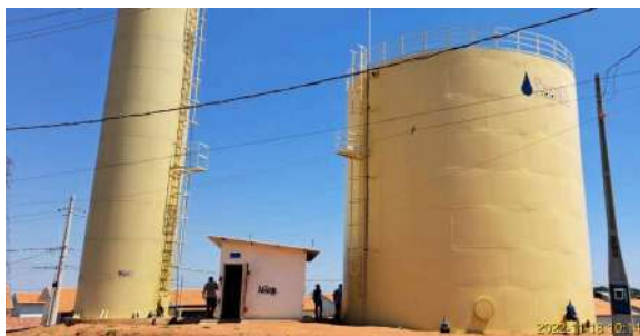
Foto 1 - Reservatórios Jd Santa Maria - apoiado (direita), casa de bombas da estação elevatória (centro, não está operando) e elevado (esquerda, inativo)
