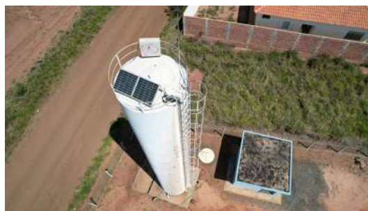
Foto 6 - Vista geral - Reservatório Santa Amélia
