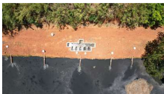
Foto 4 - Vista da lagoa anaeróbia central com nova estrutura de distribuição de entrada do esgoto - ETE Cidade
