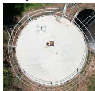
Foto 6 - Detalhe da vista da cobertura de um dos reservatórios Boa Vista
