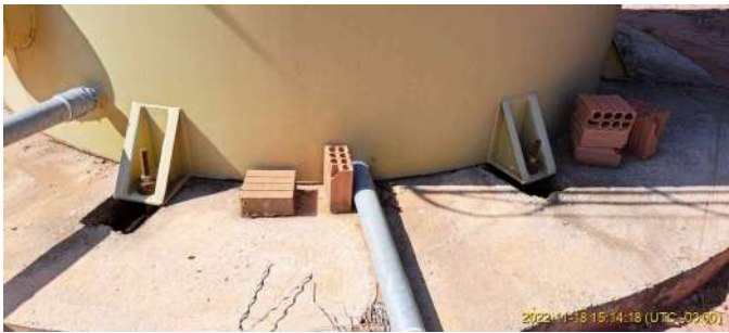
Foto 1 - Detalhe dos nichos da base do reservatório.
