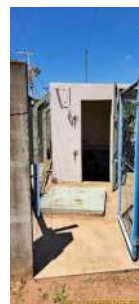
Foto 2 - Vista da entrada da estação elevatória
