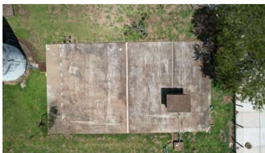
Foto 4 - Vista superior de um dos reservatórios enterrados, com a estação elevatória que recalca para o Reservatório Santa Cecília
