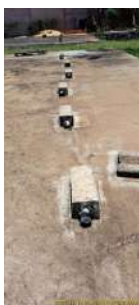
Foto 3 - Maioria das tubulações com telas de proteção.
