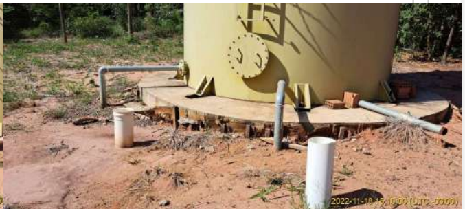
Foto 4 - Vista geral da base do Reservatório elevado Broa novo
