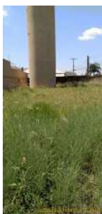
Foto 3 - Vista do Reservatório São Marcos de dentro do terreno, vegetação alta no momento da inspeção.
