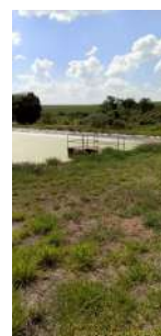
Foto 6 - Segunda lagoa de estabilização da ETE Lusitânia
