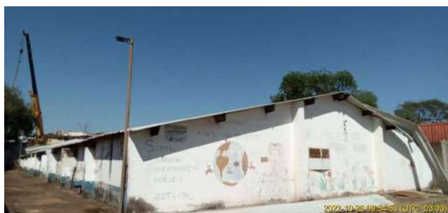
Foto 1 - Reservatório semienterrado bairro alto
