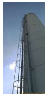
Foto 3 - Escada de acesso, com guarda-corpo
