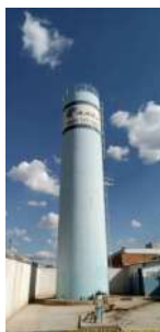
Foto 1 - Visão geral Reservatório Romana
