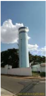
Foto 1 - Reservatório Morada Nova
