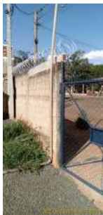
Foto 1 - Portão e muro da área do Poço Bom Jesus
