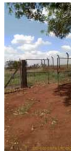
Foto 2 - Cercamento da área do do Reservatório Lusitânia
