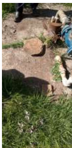
Foto 1 - Laje de proteção do Poço 3 Estiva
