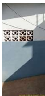
Foto 5 - Sala de dosagem de produtos químicos
