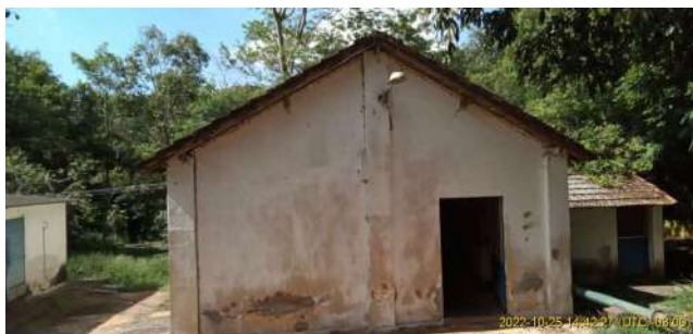
Foto 1 - Casa de bombas EEAT Estiva
