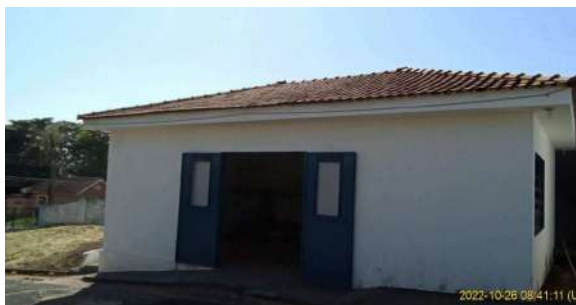
Foto 1 - Casa de bombas EEAT Bairro Alto
