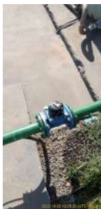
Foto 1 - Macromedidor e ponto de tomada de água bruta
