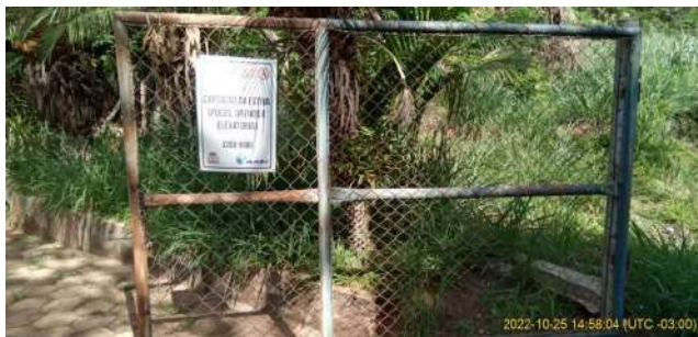
Foto 5 - Portão de acesso, a estação elevatória (EEAT Estiva)
