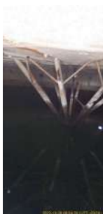
Foto 3 - Estrutura interna reservatório semi-enterrado circular bairro alto (2)
