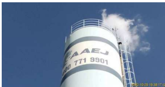
Foto 3 - Vista da parte superior do reservatório - guarda-corpo e escada de acesso
