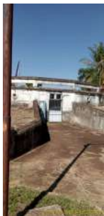
Foto 1 - Reservatório semi-enterrado circular bairro alto
