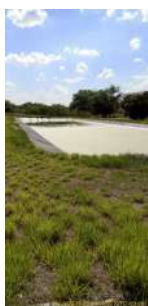
Foto 5 - Segunda lagoa de estabilização da ETE Lusitânia
