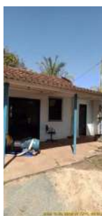
Foto 1 - Parte externa da casa de bombas
