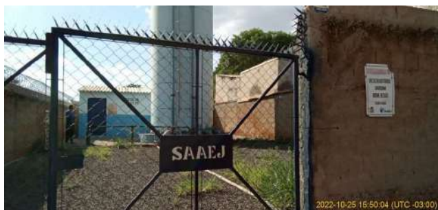
Foto 1 - Portão de acesso ao reservatório e poço Jardim Bom Jesus
