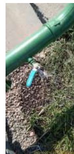
Foto 3 - Ponto de tomada de água bruta
