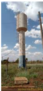
Foto 1 - Visão geral do Reservatório Lusitânia
