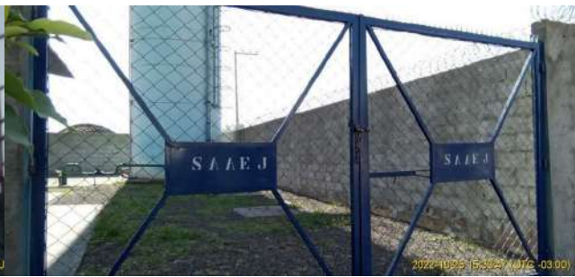
Foto 4 - Portão de acesso, ao poço e reservatório São José
