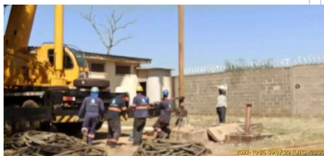
Foto 2 - Poço Bairro Alto em manutenção
