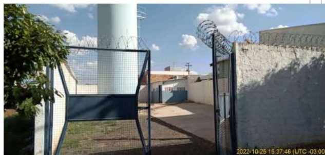
Foto 2 - Portão de acesso ao Reservatório e poço Romana
