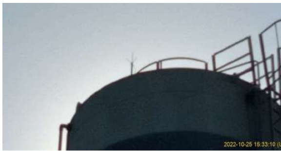
Foto 3 - Guarda-corpo e escada de acesso ao reservatório
