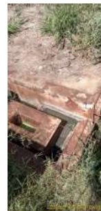
Foto 2 - gradeamento da ETE Lusitânia
