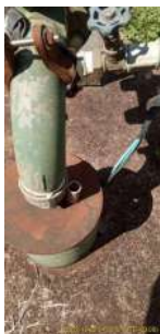
Foto 1 - Detalhe com tubo de medição de nível
