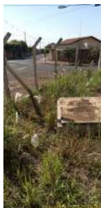
Foto 1 - Cercamento da área do Booster da Residencial Jaboticabal
