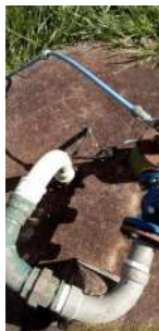
Foto 1 - Laje de proteção do Poço 1 Estiva
