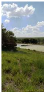
Foto 1 - Lagoa de estabilização da ETE Lusitânia
