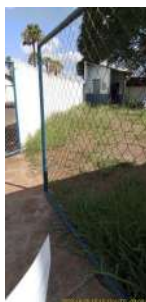
Foto 1 - Muro e portão de entrada do Poço Morada Nova
