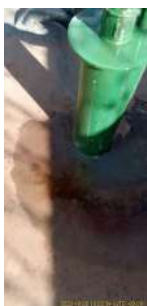
Foto 1 - Vazamento aparente no Poço Bom Jesus
