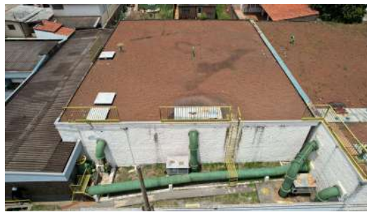
Foto 2 - Vista superior do reservatório Mercedes 1000m3
