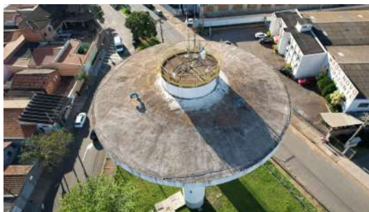
Foto 2 - Vista superior do reservatório Jardim do Lago
