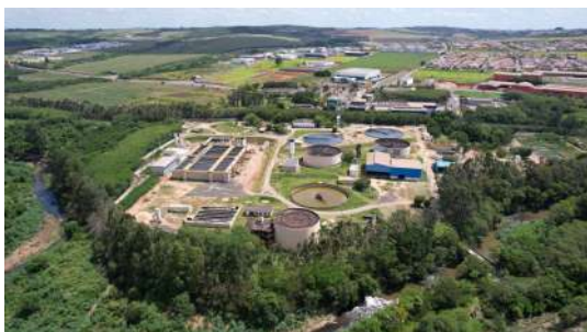
Foto 1 - Vista geral da ETE TATU
