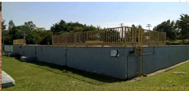
Foto 4 - Vista lateral do reservatório ETA II
