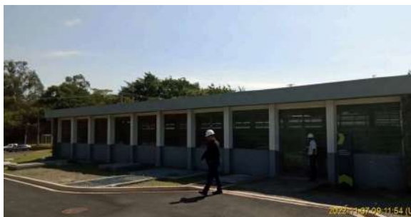
Foto 1 - Vista externa da EEAT ETA
