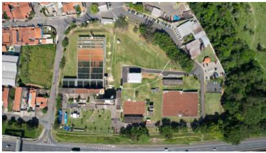
Foto 5 - Vista superior do local
