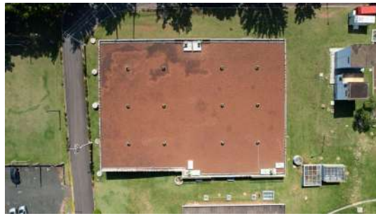
Foto 6 - Vista superior do reservatório ETA I
