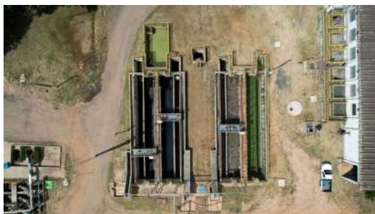
Foto 4 - Vista do desarenador
