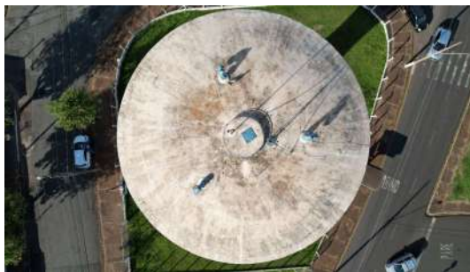
Foto 2 - Vista superior do reservatório Jardim São Paulo
