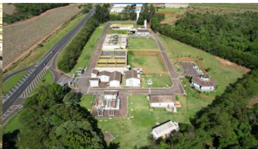
Foto 14 - Vista superior do local da ETE Água da Serra
