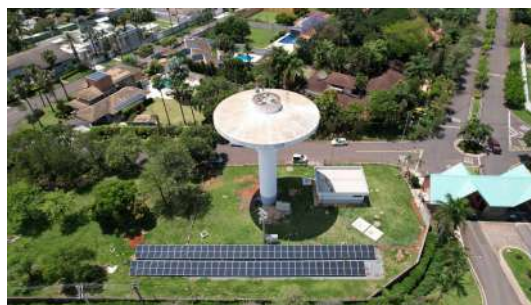
Foto 6 - Vista superior do local
