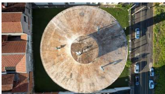
Foto 1 - Vista superior do reservatório Jardim Alvorada
