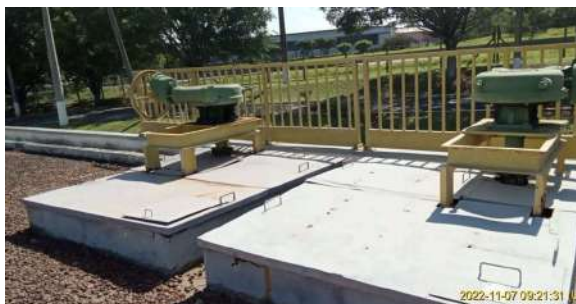
Foto 1 - Tampas de inspeção
