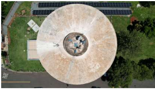
Foto 7 - Vista superior do reservatório Portal das Rosas
