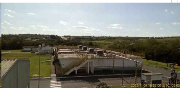
Foto 2 - Vista do UASB
