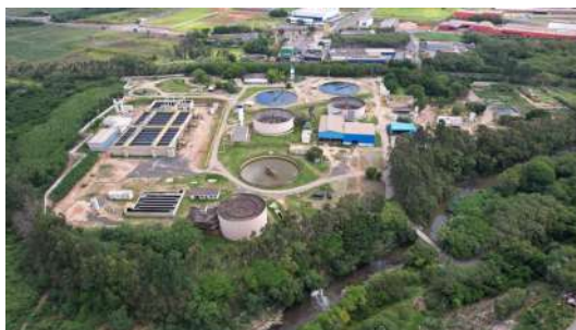
Foto 2 - Vista geral da ETE TATU
