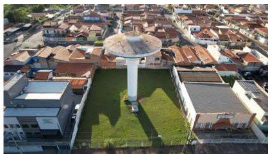
Foto 2 - Vista superior do local
