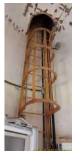
Foto 4 - Escada interna com guarda-corpo
