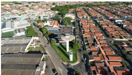
Foto 1 - Vista superior do local
