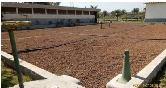
Foto 1 - Vista lateral do reservatório ETA I
