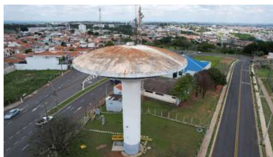
Foto 2 - Vista lateral do reservatório Egisto Ragazzo
