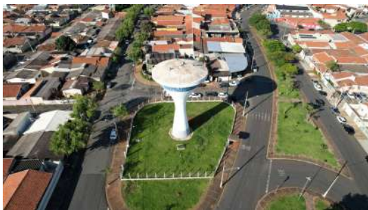
Foto 1 - Vista superior do local
