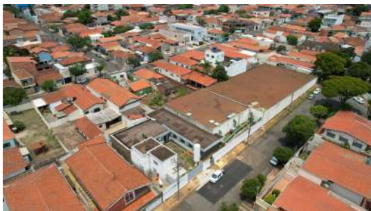
Foto 1 - Vista superior do local
