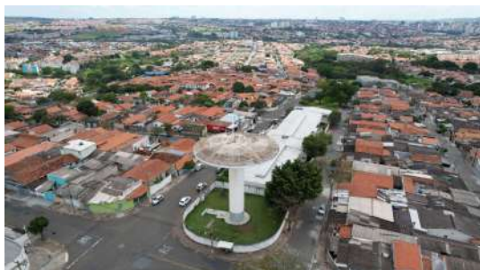
Foto 1 - Vista superior do local
