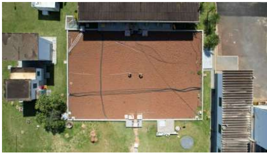
Foto 5 - Vista superior do reservatório ETA II
