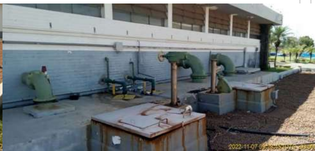
Foto 2 - Tampas de inspeção
