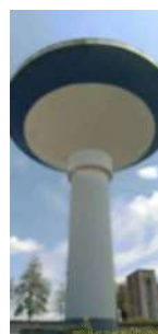
Foto 2 - Reservatório Portal das Rosas
