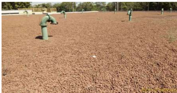
Foto 3 - Cobertura do reservatório ETA II
