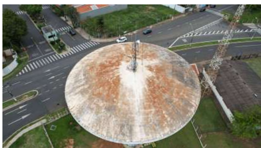
Foto 3 - Vista superior do reservatório Egisto Ragazzo
