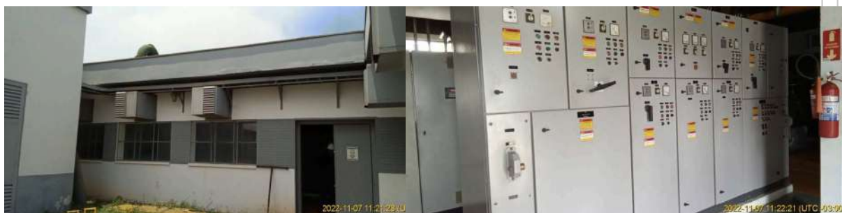
Foto 1 - Vista externa da EEAT Mercedes
