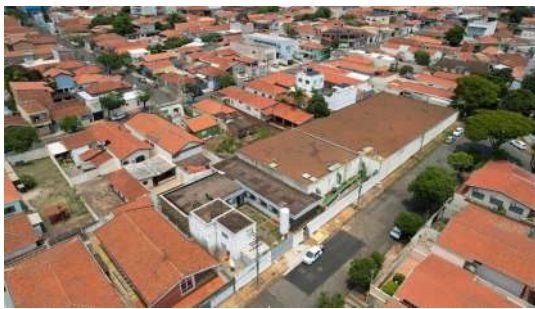
Foto 1 - Vista superior do local
