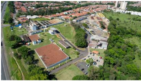
Foto 5 - Vista superior do local
