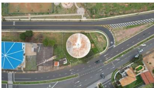
Foto 1 - Vista superior do local
