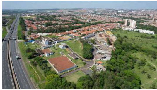
Foto 6 - Vista superior do local
