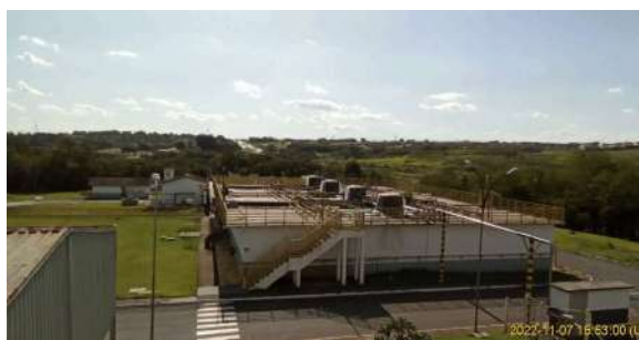
Foto 1 - Vista do UASB
