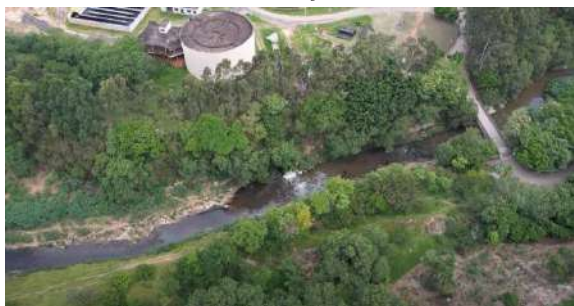
Foto 10 - Vista do lançamento do efluente tratado no corpo hídrico.
