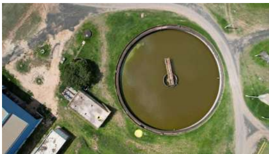
Foto 6 - Vista do decantador primário
