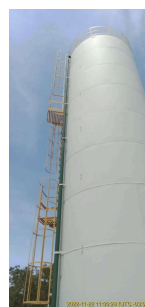
Foto 2 - Escada de acesso e guarda-corpo.
