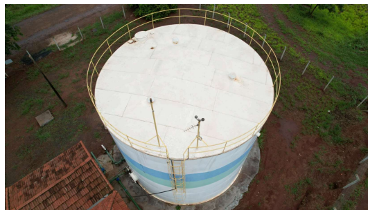
Foto 2 - Vista superior do reservatório Bela Vista/Lagoinha
