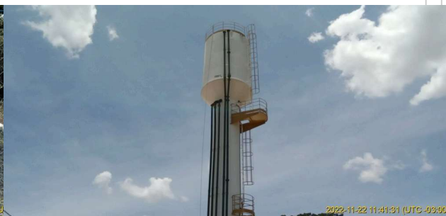
Foto 5 - Vista da parte superior do reservatório.
