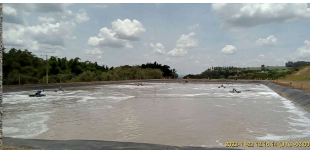
Foto 7 - Vista da lagoa com aeração mecânica.
