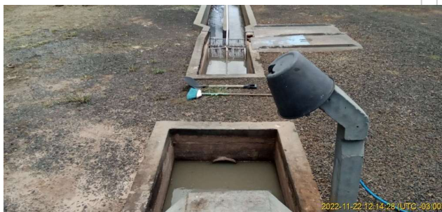
Foto 5 - Vista da caixa de areia.
