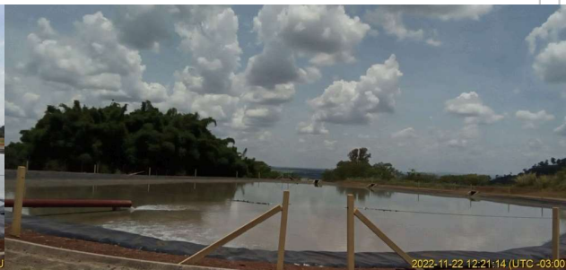
Foto 9 - Vista da segunda lagoa de decantação.
