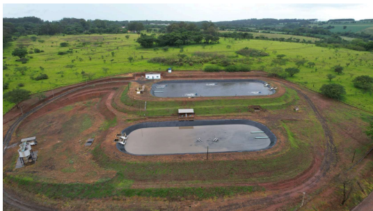
Foto 3 - Vista superior das lagoas (aerada e decantação)
