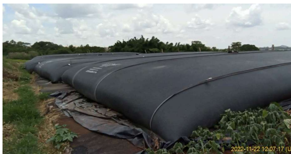
Foto 1 - Vista da linha 1 de geobags para desidratação do lodo.
