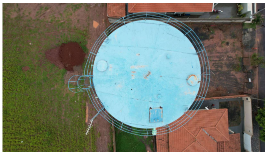
Foto 2 - Vista superior do reservatório Jequitiba Rosa
