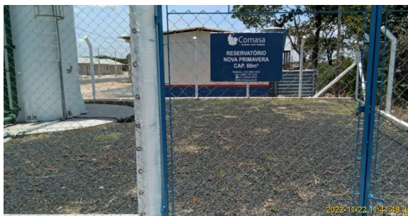
Foto 4 - Placa de identificação do reservatório.
