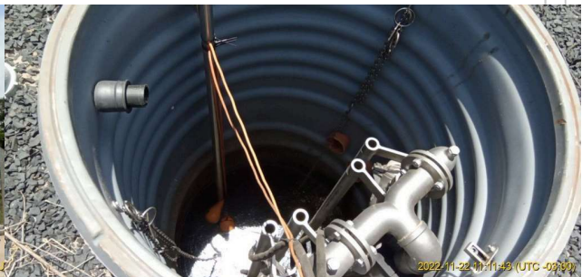
Foto 2 - Vista superior do poço de sucção.
