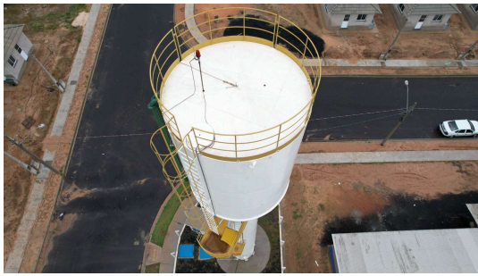
Foto 8 - Vista superior do reservatório Nova Primavera
