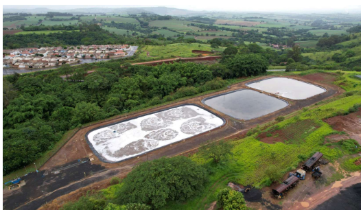
Foto 20 - Vista superior das lagoas (aerada e decantação)
