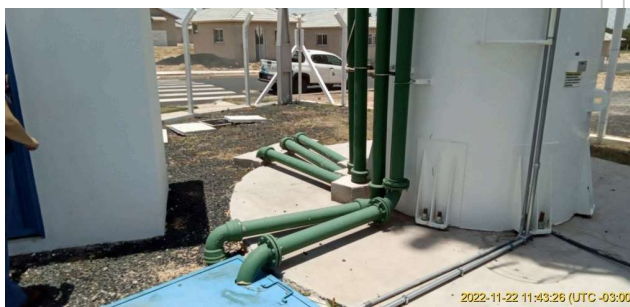
Foto 3 - Vista geral do interior do reservatório.
