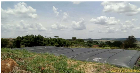
Foto 3 - Vista geral dos geobags para desidratação do lodo.
