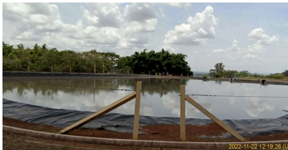
Foto 8 - Vista da primeira lagoa de decantação.
