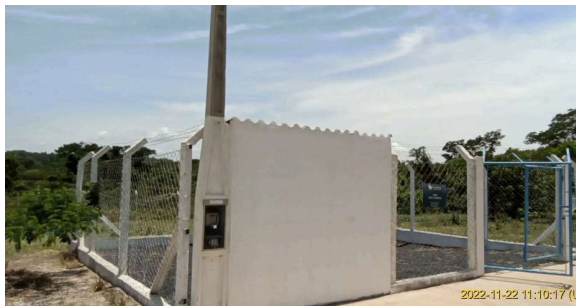
Foto 1 - Vista geral da EEEB.
