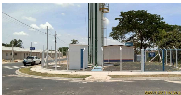
Foto 6 - Vista geral do reservatório.
