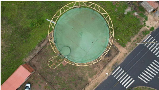
Foto 2 - Vista superior do reservatório Figueira Branca
