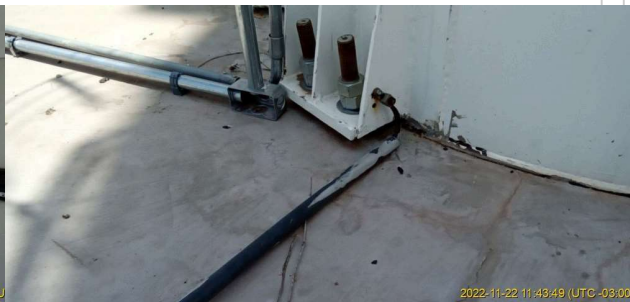
Foto 2 - Vista do aterramento do reservatório.
