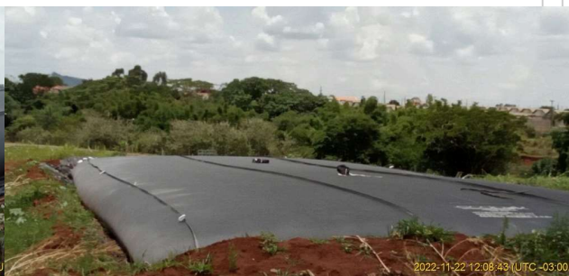
Foto 2 - Vista da linha 2 de geobags para desidratação do lodo.
