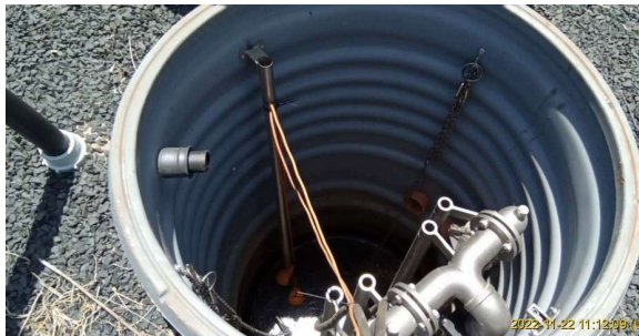
Foto 3 - Vista superior do poço de sucção.
