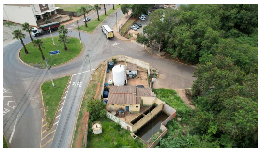
Foto 3 - Vista superior da ETA III
