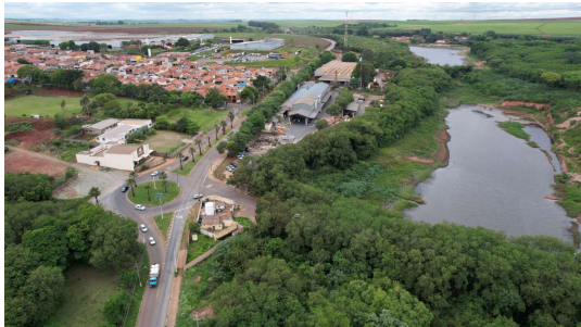
Foto 1 - Vista geral da ETA III e captação superficial Bom Jesus II (direita)
