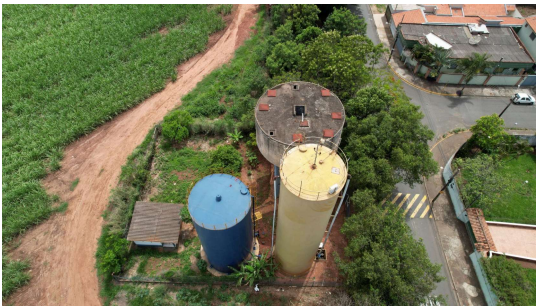
Foto 2 - Vista geral dos Reservatórios São Cristóvão (elevado de concreto desativado)
