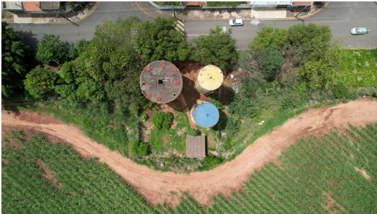
Foto 3 - Vista superior dos Reservatórios São Cristóvão (elevado de concreto à esquerda desativado)
