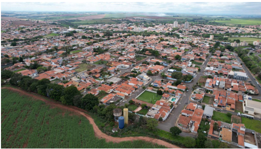
Foto 1 - Vista geral dos Reservatórios São Cristóvão
