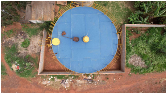
Foto 5 - Vista superior do novo reservatório metálico - Bom Jardim
