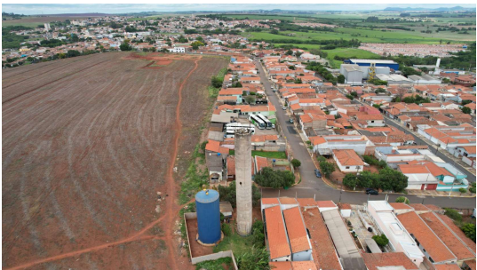
Foto 2 - Vista geral dos Reservatórios elevados Bom Jardim
