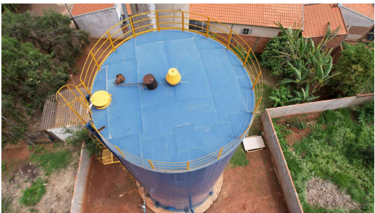
Foto 4 - Vista do novo reservatório metálico - Bom Jardim
