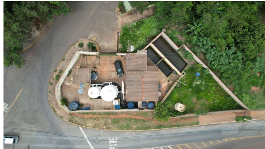
Foto 2 - Vista superior da ETA III
