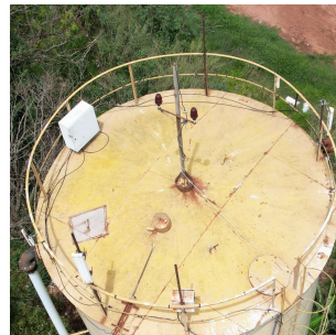
Foto 2 - Tapa de inspeção do Reservatório metálico antigo
