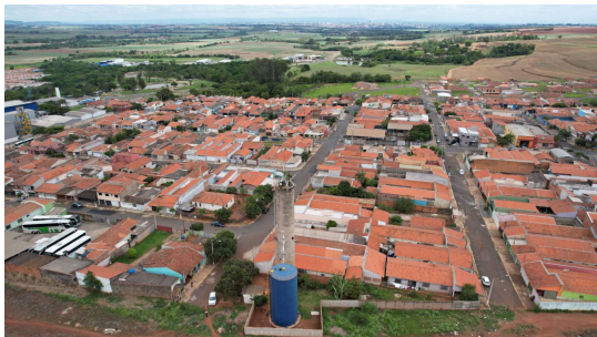
Foto 1 - Vista geral dos Reservatórios elevados Bom Jardim
