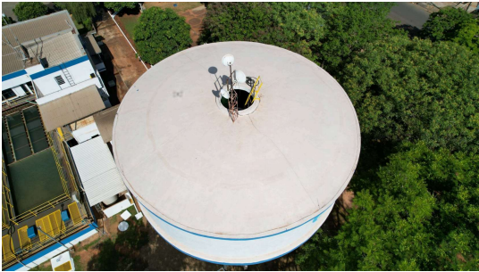
Foto 4 - Vista superior do reservatório Castelo
