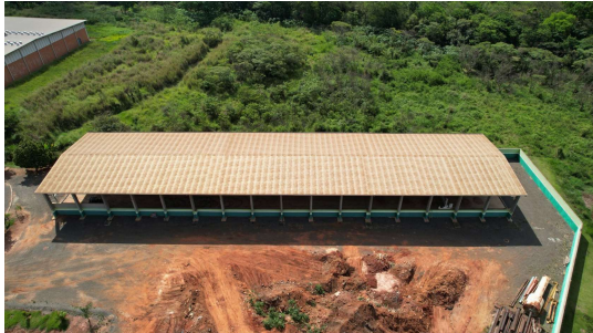
Foto 5 - Vista do galpão de compostagem dos resíduos
