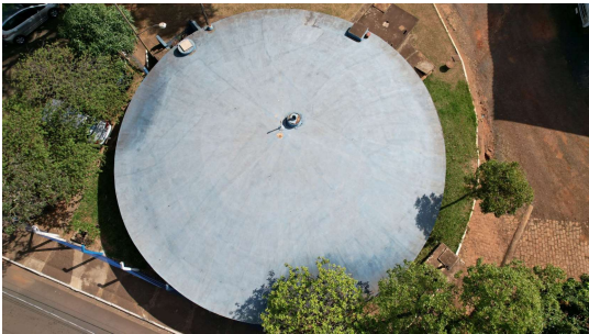
Foto 1 - Vista superior do reservatório semi enterrado ETA
