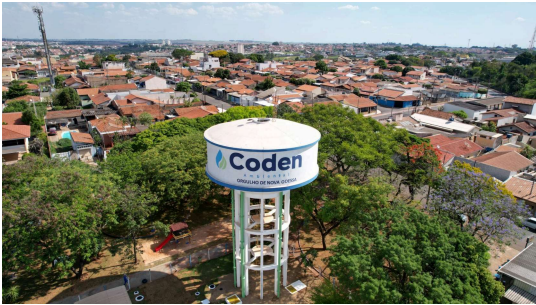
Foto 3 - Vista superior do reservatório Castelo
