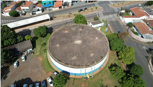
Foto 2 - Vista superior do local
