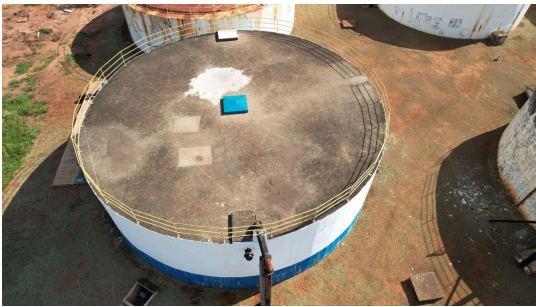
Foto 3 - Vista superior do reservatório Klavin 2
