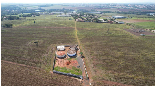
Foto 1 - Vista superior do local
