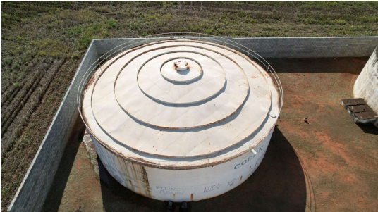
Foto 5 - Vista superior do reservatório Klavin 4
