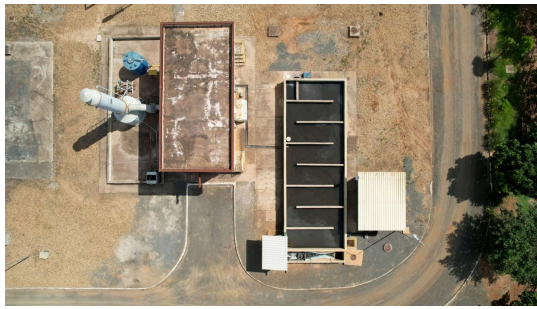
Foto 4 - Vista superior da desinfecção
