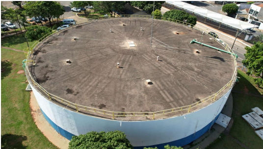
Foto 1 - Vista superior do reservatório 5000
