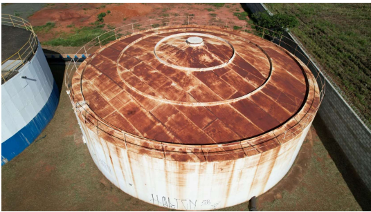
Foto 4 - Vista superior do Reservatório Klavin 3
