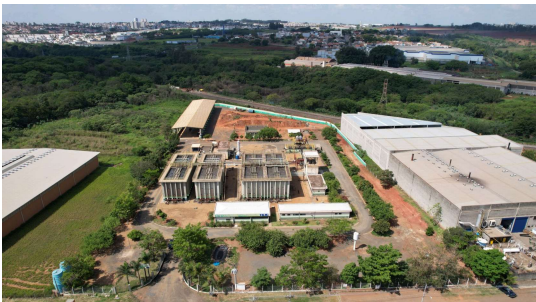
Foto 1 - Vista superior da ETE Quilombo
