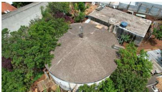
Foto 3 - Vista geral do reservatório (imagem obtida com auxílio de drone).
