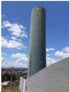
Foto 1 - Vista geral do reservatório Santa Martha.
