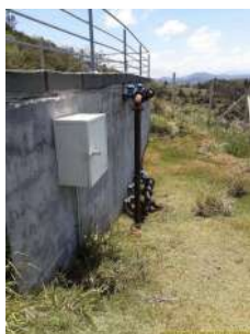
Foto 1 - Vista lateral do reservatório semienterrado.
