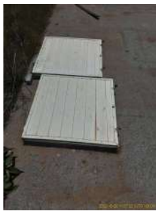
Foto 1 - Tampas de inspeção em bom estado.
