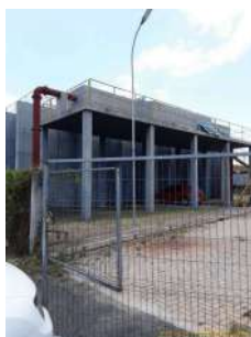
Foto 1 - Vista geral da ETE.
