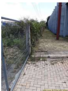
Foto 1 - Detalhe do cercamento do local.
