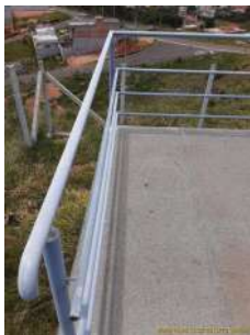
Foto 1 - Guarda-corpos em bom estado.
