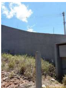
Foto 1 - Muro em torno do reservatório.
