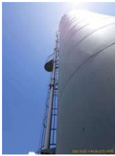
Foto 1 - Detalhe do tubo extravasor.
