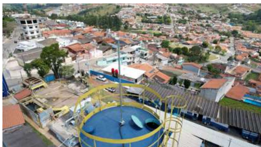
Foto 1 - Detalhe da haste instalada no topo do reservatório (imagem obtida com auxílio de drone).
