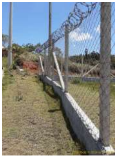
Foto 1 - Detalhe do cercamento no local.
