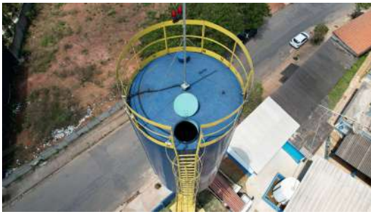
Foto 1 - Detalhe da tampa de inspeção aberta (imagem obtida com auxílio de drone).
