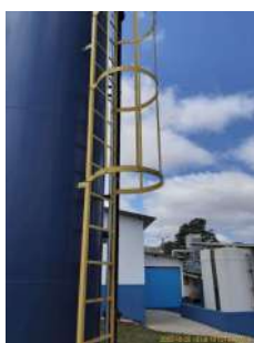
Foto 1 - Guarda-corpos em bom estado.
