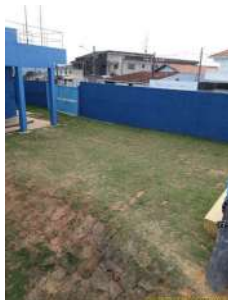
Foto 1 - Detalhe do muro que cerca o local.
