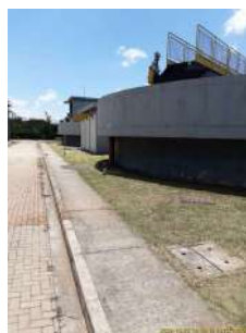
Foto 2 - Detalhe dos decantadores secundários.
