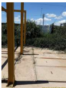
Foto 1 - Vista geral das instalações.
