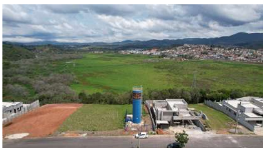
Foto 1 - Vista geral do reservatório (imagem obtida com auxílio de drone).
