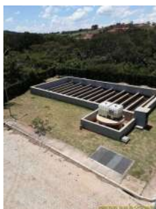
Foto 11 - Detalhe do trajeto final do efluente tratado.
