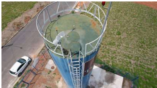
Foto 1 - Detalhe da tampa de inspeção em bom estado (imagem obtida com auxílio de drone).
