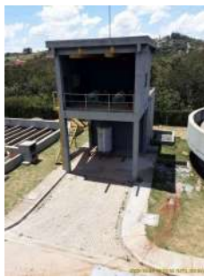
Foto 1 - Instalações para tratamento de lodo. No piso superior, centrífuga fora de operação.
