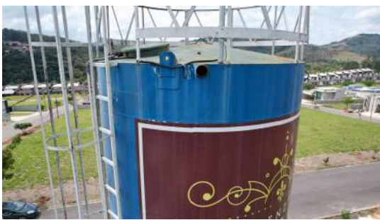
Foto 1 - Detalhe do extravasor na lateral do reservatório (imagem obtida com auxílio de drone).
