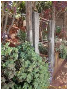
Foto 1 - Detalhe do cercamento do local.
