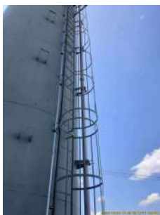
Foto 1 - Guarda-corpos em bom estado.
