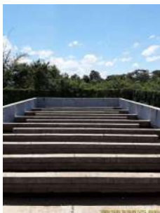
Foto 17 - Vista geral da saída do efluente tratado.
