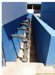
Foto 5 - Saída da casa de bombas.
