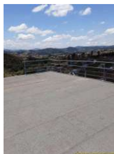
Foto 2 - Vista superior do reservatório.
