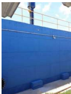
Foto 1 - Detalhe dos extravasores nas laterais do reservatório.
