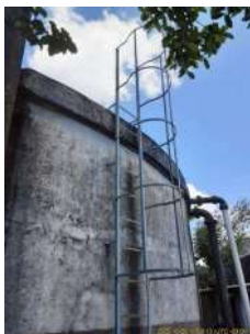
Foto 1 - Detalhe da escada com guarda-corpos.
