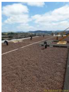
Foto 1 - Vista dos guarda-corpos em torno do reservatório.
