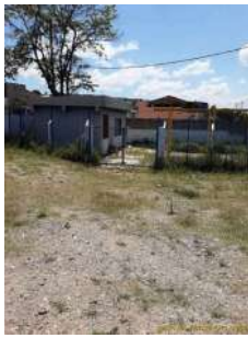
Foto 1 - Cercamento da EEE Dom Pedro.
