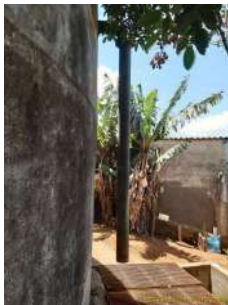
Foto 1 - Detalhe do extravasor.
