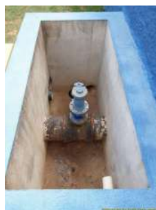
Foto 8 - Chegada da água bruta nas instalações, antes do direcionamento às ETAs 2 e 3.
