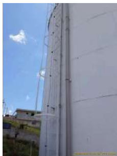
Foto 1 - Detalhe do guarda-corpo em bom estado.
