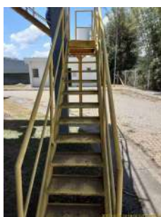
Foto 1 - Escada para acesso ao piso superior da ETE.
