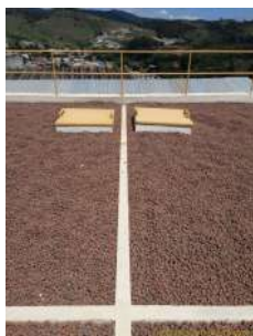
Foto 1 - Tampas de inspeção.
