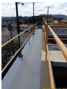
Foto 1 - Guarda-corpos instalados junto à ETA 03.
