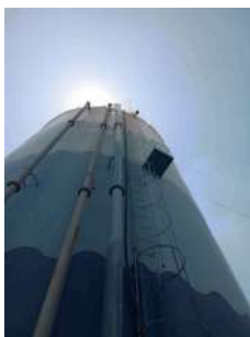
Foto 1 - Escada, guarda-corpo e plataforma de descanso do reservatório de maior volume.
