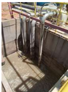
Foto 7 - Sucção de efluente bruto no tratamento preliminar.
