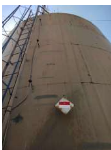
Foto 1 - Escada com guarda-corpo.
