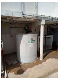
Foto 3 - Armazenamento de barrilha, alcalinizante.
