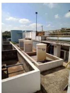
Foto 1 - Tanques de armazenamento de produtos químicos com diques de contenção.
