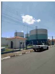
Foto 1 - Cercamento da área.
