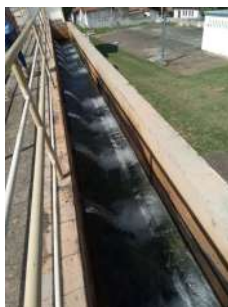
Foto 4 - Saída dos vertedores
