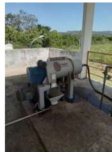
Foto 2 - Centrífuga para desidratação.
