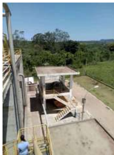
Foto 1 - Unidade de tratamento do lodo visto a partir dos reatores
