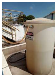
Foto 6 - Tanque para armazenamento de flúor
