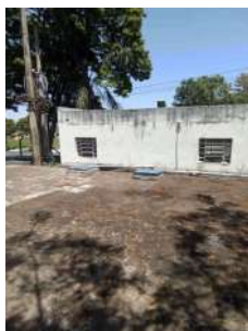
Foto 3 - Tampas de inspeção.
