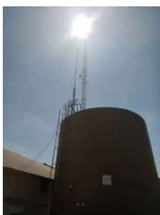
Foto 1 - Para-raios no reservatório.
