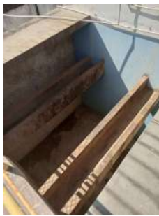
Foto 8 - Filtro em manutenção: será realizada impermeabilização
