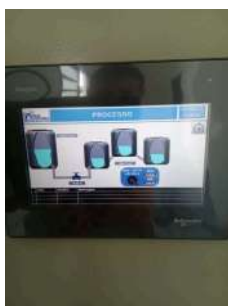
Foto 1 - Sistema de telemetria para monitoramento dos níveis
