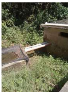
Foto 1 - Abertura para ventilação do reservatório de água bruta deve ter tela de proteção.
