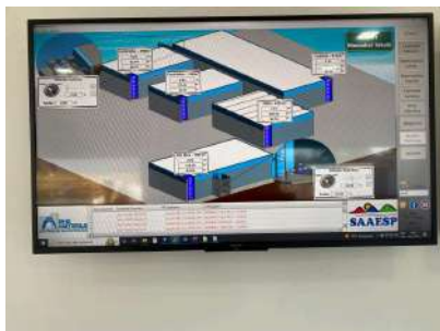
Foto 11 - Sistema de telemetria existente na ETA.
