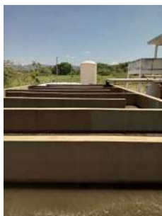
Foto 32 - Câmara de contato para mistura lenta, após aplicação de hipoclorito de sódio.
