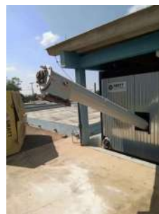
Foto 2 - Skid para desidratação do lodo, sem operação.
