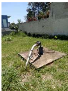
Foto 1 - Laje de concreto.
