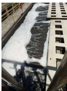
Foto 28 - Observa-se bastante espuma no reator.
