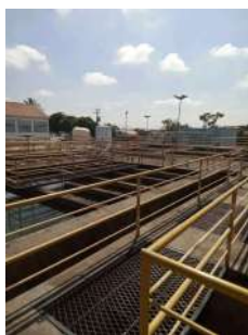
Foto 1 - Guarda-corpos na ETA
