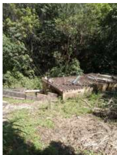
Foto 1 - Vista da captação.
