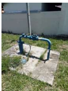
Foto 1 - Laje de concreto.
