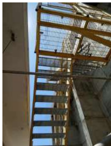
Foto 1 - Escadas de acesso ao topo dos reatores.
