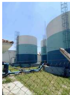
Foto 3 - Reservatórios com escada e guarda-corpo.
