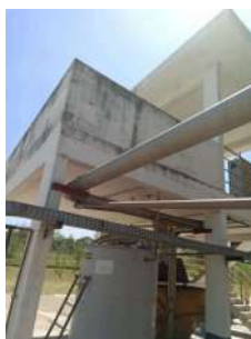
Foto 4 - Caçamba para remoção do lodo tratado.
