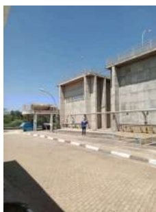
Foto 3 - Dois reatores aeróbios e anaeróbios.
