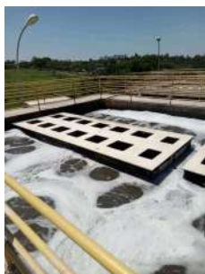
Foto 24 - Vista dos reatores de cima.
