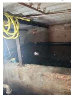
Foto 4 - Reservatório de água bruta.
