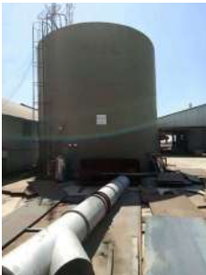
Foto 1 - Reservatório Santa Rosa
