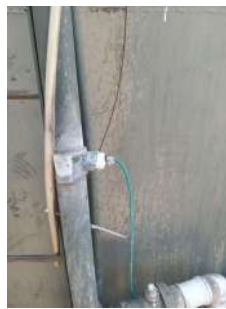
Foto 4 - Aplicação de flúor no reservatório
