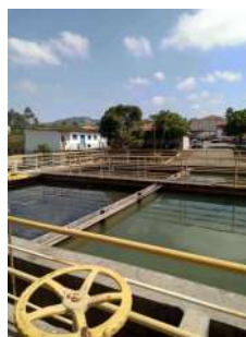
Foto 2 - Guarda-corpos na ETA
