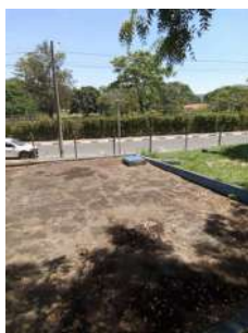
Foto 1 - Tampa de inspeção.
