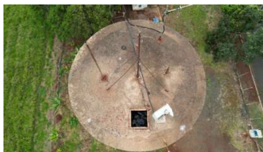
Foto 2 - Reservatório Elevado Vila Boteon em Cordeirópolis
