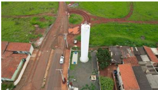
Foto 1 - Reservatório Elevado Jardim Eldorado em Cordeirópolis
