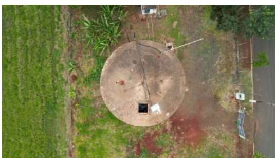
Foto 1 - Reservatório Elevado Vila Boteon em Cordeirópolis
