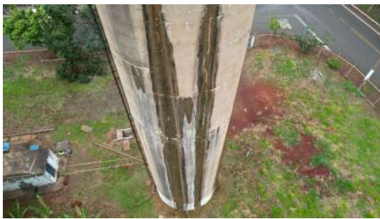
Foto 1 - Reservatório Elevado Vila Boteon em Cordeirópolis
