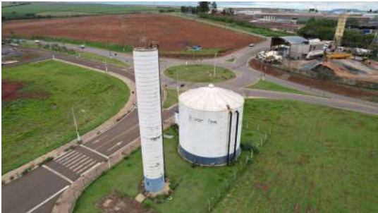
Foto 1 - Reservatório Apoiado Jardim Paraty em Cordeirópolis
