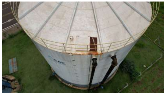
Foto 2 - Reservatório Apoiado Jardim Paraty em Cordeirópolis
