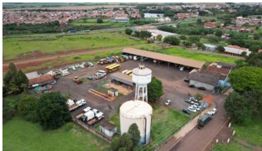
Foto 2 - Reservatório Elevado Centro de distribuição de água em Cordeirópolis
