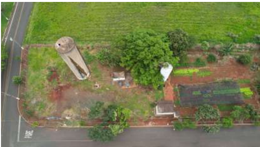
Foto 1 - Reservatório Elevado Vila Boteon em Cordeirópolis
