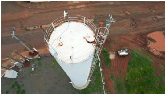
Foto 2 - Reservatório Elevado Jardim Eldorado em Cordeirópolis
