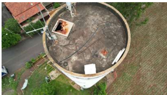
Foto 2 - Reservatório Elevado Jardim Juventude em Cordeirópolis
