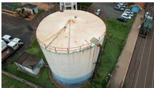
Foto 1 - Reservatório Apoiado Centro de distribuição de água em Cordeirópolis
