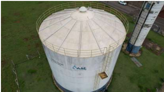
Foto 1 - Reservatório Apoiado Jardim Paraty em Cordeirópolis
