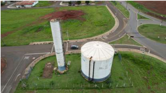
Foto 2 - Reservatório Apoiado Jardim Paraty em Cordeirópolis
