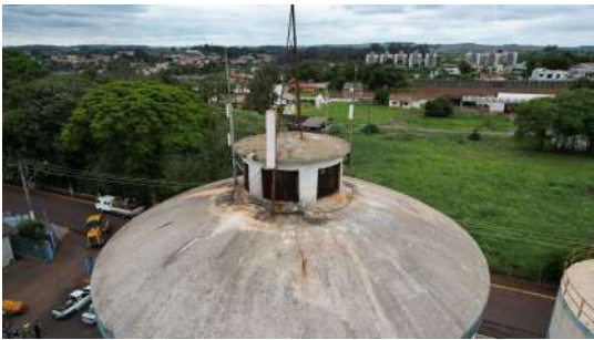
Foto 3 - Reservatório Elevado Centro de distribuição de água em Cordeirópolis
