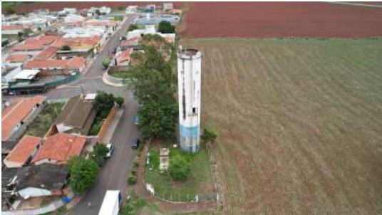
Foto 1 - Reservatório Elevado Jardim Juventude em Cordeirópolis
