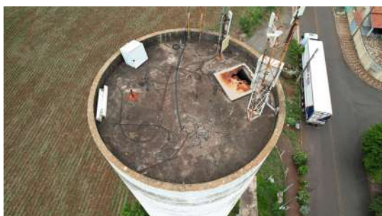
Foto 1 - Reservatório Elevado Jardim Juventude em Cordeirópolis
