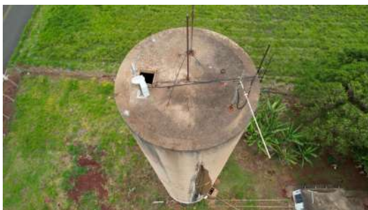
Foto 1 - Reservatório Elevado Vila Boteon em Cordeirópolis
