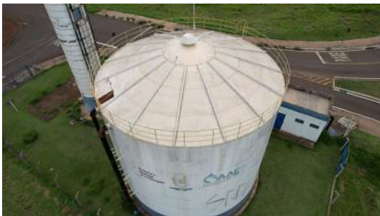
Foto 1 - Reservatório Apoiado Jardim Paraty em Cordeirópolis
