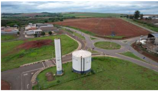
Foto 3 - Reservatório Apoiado Jardim Paraty em Cordeirópolis
