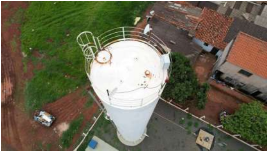
Foto 1 - Reservatório Elevado Jardim Eldorado em Cordeirópolis
