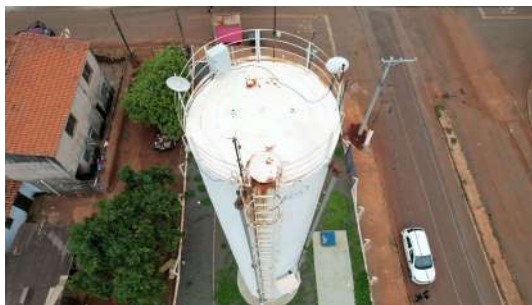
Foto 2 - Reservatório Elevado Jardim Eldorado em Cordeirópolis
