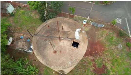
Foto 1 - Reservatório Elevado Vila Boteon em Cordeirópolis
