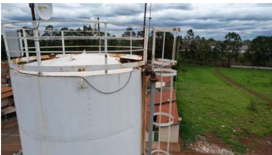
Foto 1 - Reservatório Elevado Jardim Eldorado em Cordeirópolis
