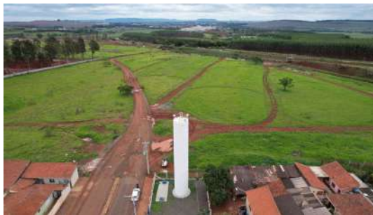
Foto 2 - Reservatório Elevado Jardim Eldorado em Cordeirópolis
