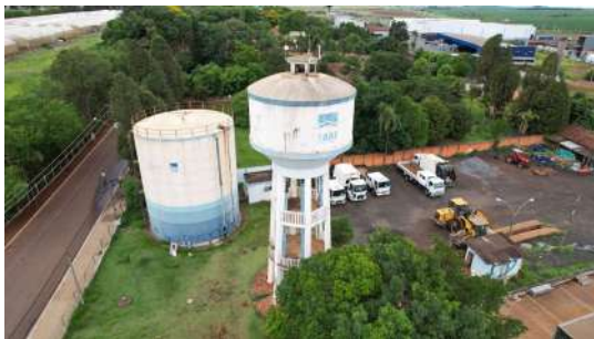
Foto 1 - Reservatório Elevado Centro de distribuição de água em Cordeirópolis
