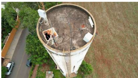
Foto 1 - Reservatório Elevado Jardim Juventude em Cordeirópolis
