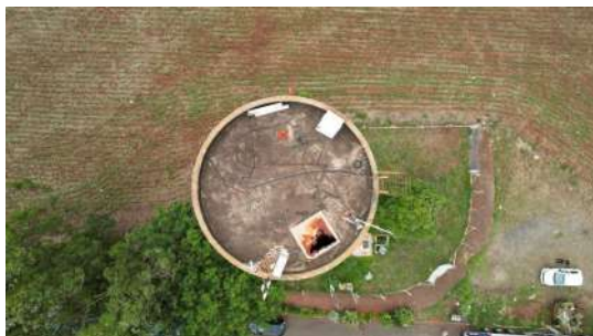
Foto 1 - Reservatório Elevado Jardim Juventude em Cordeirópolis
