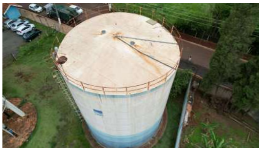
Foto 2 - Reservatório Apoiado Centro de distribuição de água em Cordeirópolis
