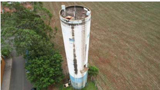
Foto 2 - Reservatório Elevado Jardim Juventude em Cordeirópolis
