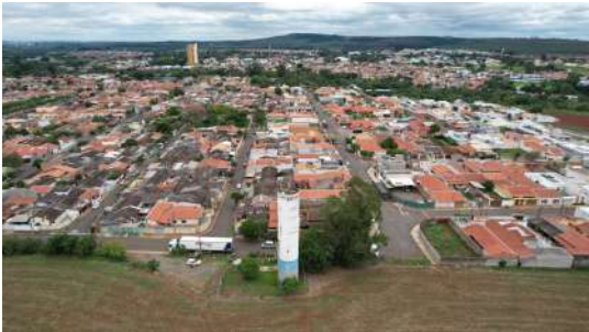
Foto 2 - Reservatório Elevado Jardim Juventude em Cordeirópolis
