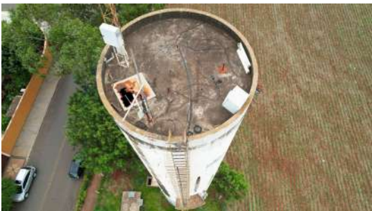
Foto 1 - Reservatório Elevado Jardim Juventude em Cordeirópolis
