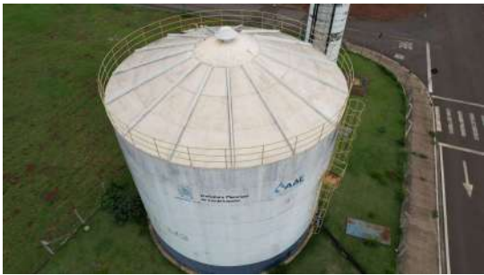
Foto 1 - Reservatório Apoiado Jardim Paraty em Cordeirópolis
