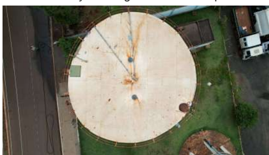
Foto 4 - Reservatório Apoiado Centro de distribuição de água em Cordeirópolis
