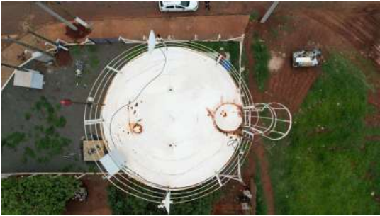
Foto 1 - Reservatório Elevado Jardim Eldorado em Cordeirópolis
