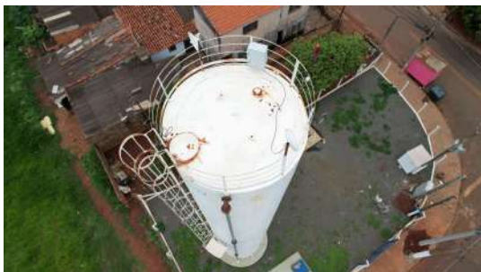
Foto 1 - Reservatório Elevado Jardim Eldorado em Cordeirópolis
