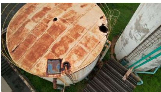
Foto 3 - Foto com auxílio de drone do dia 31/10/2022 no Reservatório Apoiado Ometto Pavan em Iracemápolis
