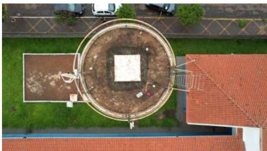
Foto 1 - Foto com auxílio de drone no dia 31/10/2022 no Reservatório Cidade Nova I em Iracemápolis
