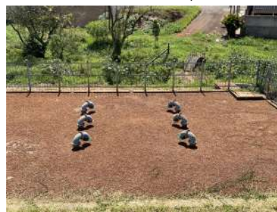
Foto 6 - Visita em campo no dia 26/10/2022 na ETA em Iracemápolis
