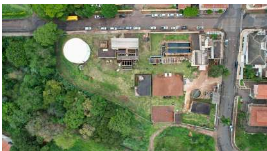
Foto 1 - Foto com auxílio de drone na ETA em Iracemápolis
