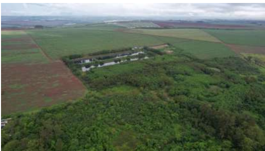
Foto 7 - Foto com auxílio de drone no dia 31/10/2022 na ETE em Iracemápolis
