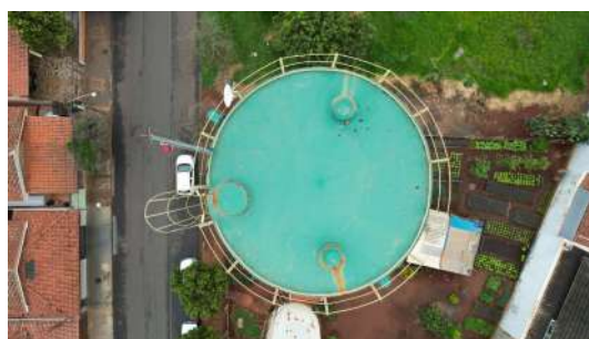
Foto 2 - Foto com auxílio de drone do dia 31/10/2022 no Reservatório Cidade Nova II em Iracemápolis
