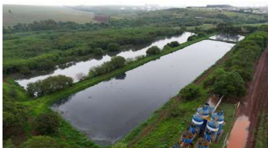
Foto 1 - Foto com auxílio de drone no dia 31/10/2022 na ETE em Iracemápolis
