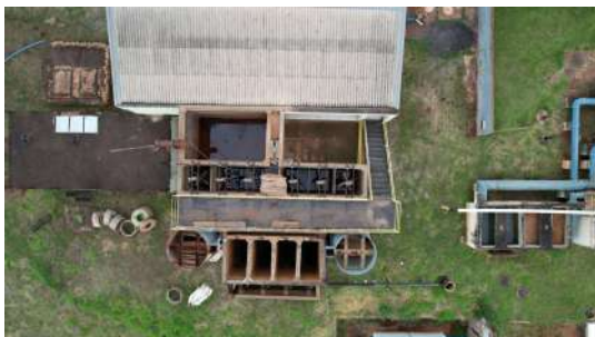
Foto 13 - Foto com auxílio de drone na ETA em Iracemápolis no dia 31/10/2022
