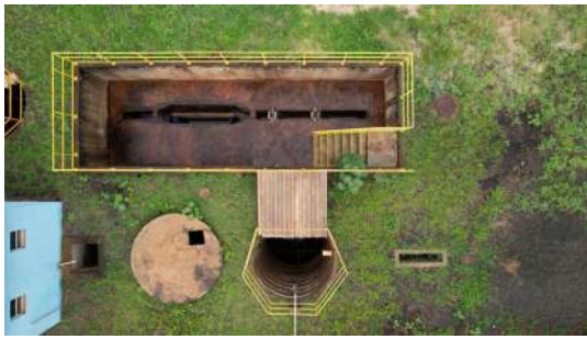
Foto 13 - Foto com auxílio de drone no dia 31/10/2022 na ETE em Iracemápolis
