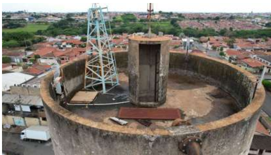
Foto 1 - Reservatório elevado Iracema em Iracemápolis
