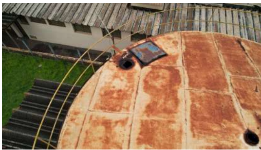
Foto 1 - Foto com auxílio de drone do dia 31/10/2022 no Reservatório Apoiado Ometto Pavan em Iracemápolis
