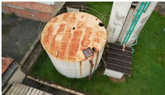
Foto 2 - Foto com auxílio de drone do dia 31/10/2022 no Reservatório Apoiado Ometto Pavan em Iracemápolis
