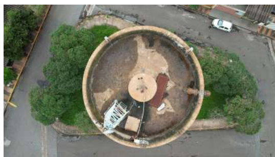
Foto 1 - Reservatório elevado Iracema em Iracemápolis
