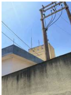
Foto 1 - Visita em campo no dia 26/10/2022 na ETA em Iracemápolis
