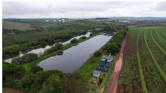
Foto 2 - Foto com auxílio de drone no dia 31/10/2022 na ETE em Iracemápolis
