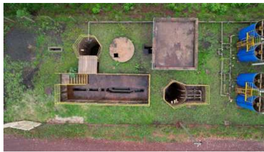
Foto 4 - Foto com auxílio de drone no dia 31/10/2022 na ETE em Iracemápolis
