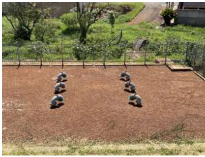
Foto 1 - Visita em campo no dia 26/10/2022 no Reservatório Semi Enterrado na ETA de Iracemápolis
