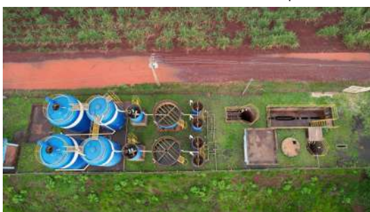
Foto 9 - Foto com auxílio de drone no dia 31/10/2022 na ETE em Iracemápolis
