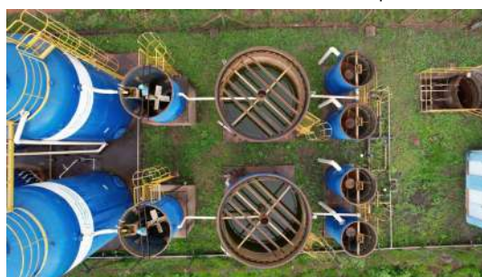
Foto 10 - Foto com auxílio de drone no dia 31/10/2022 na ETE em Iracemápolis
