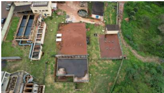
Foto 1 - Foto com auxílio de Drone no dia 31/10/2022 no Reservatório 1 milhão em Iracemápolis
