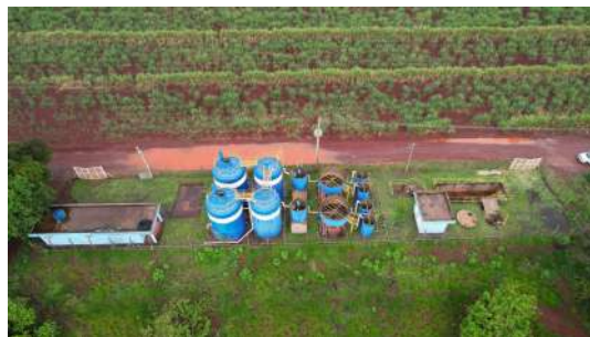
Foto 8 - Foto com auxílio de drone no dia 31/10/2022 na ETE em Iracemápolis
