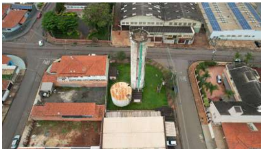
Foto 1 - Foto com auxílio de drone no dia 31/10/2022 no Reservatório Elevado Ometto Pavan II em Iracemápolis
