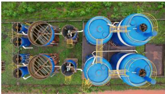
Foto 5 - Foto com auxílio de drone no dia 31/10/2022 na ETE em Iracemápolis
