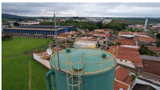
Foto 3 - Foto com auxílio de drone do dia 31/10/2022 no Reservatório Cidade Nova II em Iracemápolis
