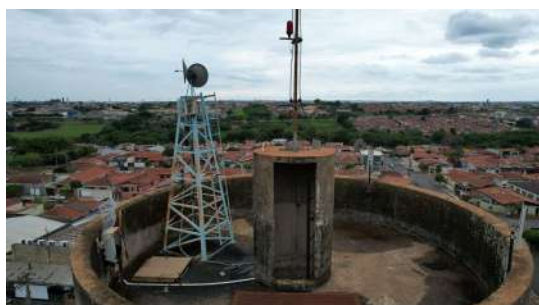
Foto 1 - Reservatório elevado Iracema em Iracemápolis
