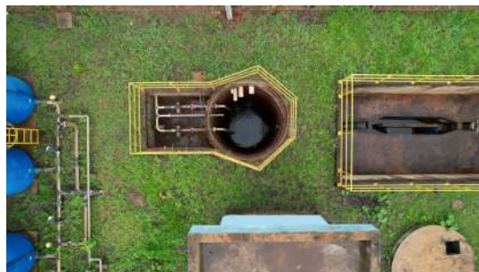
Foto 12 - Foto com auxílio de drone no dia 31/10/2022 na ETE em Iracemápolis
