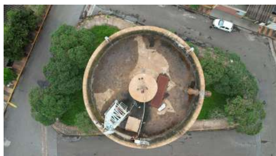
Foto 1 - Reservatório elevado Iracema em Iracemápolis
