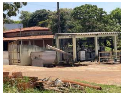
Foto 10 - Visita em campo no dia 26/10/2022 na ETA em Iracemápolis
