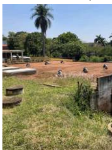
Foto 5 - Visita em campo no dia 26/10/2022 na ETA em Iracemápolis
