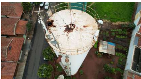
Foto 1 - Foto com auxílio de drone do dia 31/10/2022 no Reservatório Cidade Nova II em Iracemápolis
