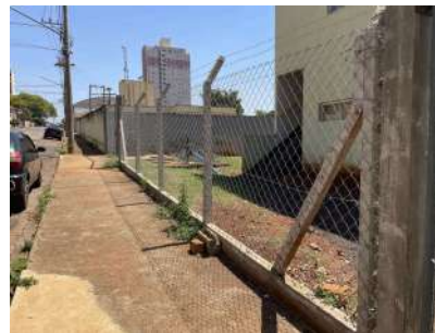
Foto 2 - Visita em campo no dia 26/10/2022 na ETA em Iracemápolis
