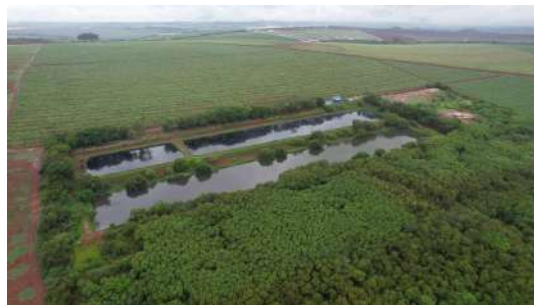
Foto 6 - Foto com auxílio de drone no dia 31/10/2022 na ETE em Iracemápolis
