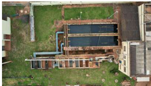
Foto 12 - Foto com auxílio de drone na ETA em Iracemápolis no dia 31/10/2022
