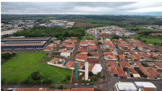
Foto 3 - Foto com auxílio de drone do dia 31/10/2022 no Reservatório Cidade Nova II em Iracemápolis
