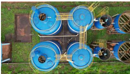
Foto 11 - Foto com auxílio de drone no dia 31/10/2022 na ETE em Iracemápolis
