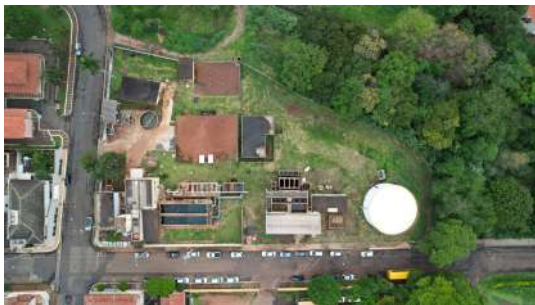
Foto 11 - Foto com auxílio de drone na ETA em Iracemápolis no dia 31/10/2022
