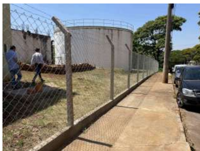
Foto 3 - Visita em campo no dia 26/10/2022 na ETA em Iracemápolis
