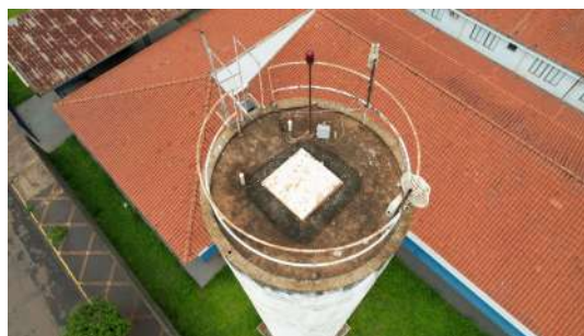
Foto 2 - Foto com auxílio de drone no dia 31/10/2022 no Reservatório Cidade Nova I em Iracemápolis
