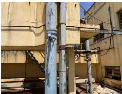
Foto 9 - Visita em campo no dia 26/10/2022 na ETA em Iracemápolis
