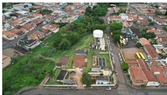
Foto 2 - Foto com auxílio de drone na ETA em Iracemápolis
