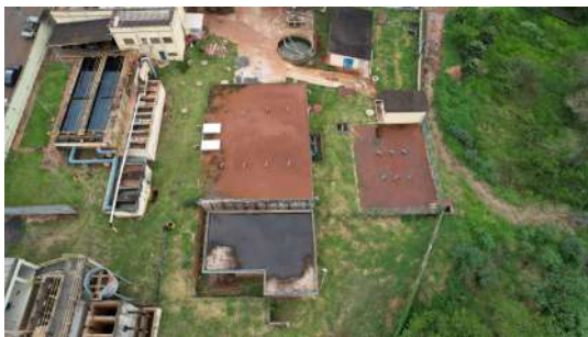
Foto 1 - Foto com auxílio de drone no dia 31/10/2022 no Reservatório Semi Enterrado ETA em Iracemápolis
