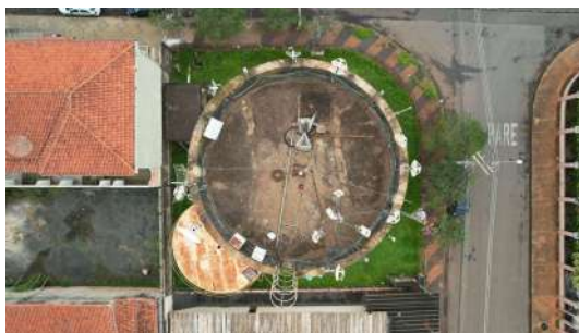
Foto 2 - Foto com auxílio de drone no dia 31/10/2022 no Reservatório Elevado Ometto Pavan II em Iracemápolis
