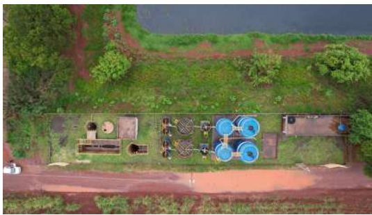
Foto 3 - Foto com auxílio de drone no dia 31/10/2022 na ETE em Iracemápolis
