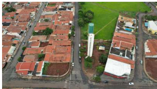
Foto 4 - Foto com auxílio de drone do dia 31/10/2022 no Reservatório Cidade Nova II em Iracemápolis
