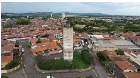
Foto 1 - Reservatório elevado Iracema em Iracemápolis
