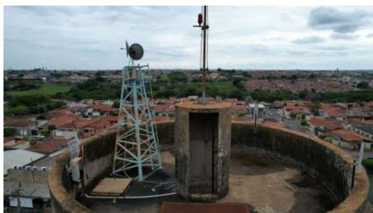
Foto 1 - Reservatório elevado Iracema em Iracemápolis
