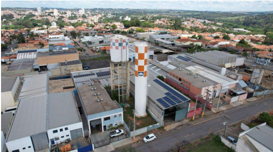
Foto 1 - Visão geral do Reservatório R10 Sistema Bela Vista
