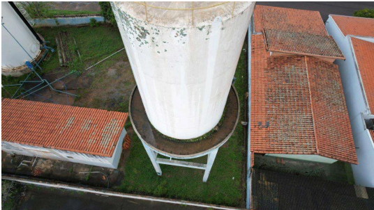
Foto 3 - Vista lateral do Reservatório R8
