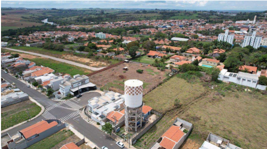
Foto 1 - Visão geral do Reservatório R22 - Sistema Terra Nova
