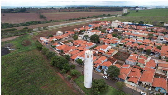
Foto 1 - Visão geral do Reservatório R20 - Sistema Santa Maria
