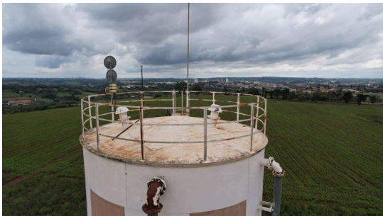
Foto 3 - Detalhes da parte superior do Reservatório R20 - Sistema Santa Maria (2)
