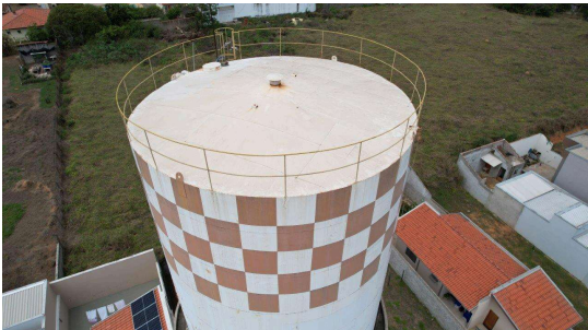
Foto 3 - Parte superior do Reservatório R22 - Sistema Terra Nova (2)
