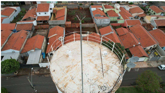
Foto 5 - Detalhes da parte superior do Reservatório R20 - Sistema Santa Maria (4)
