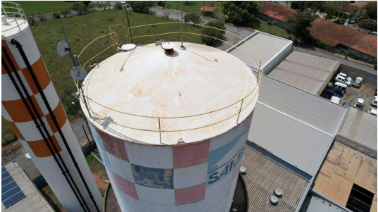
Foto 2 - Vista superior do o Reservatório R10 Sistema Bela Vista
