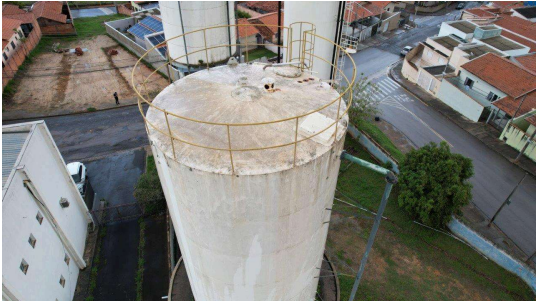
Foto 2 - Vista superior do Reservatório R8
