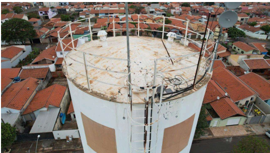
Foto 4 - Detalhes da parte superior do Reservatório R20 - Sistema Santa Maria (3)
