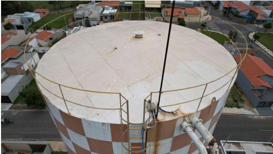
Foto 2 - Parte superior do Reservatório R22 - Sistema Terra Nova (1)
