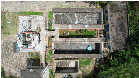
Foto 2 - Vista em planta baixa de unidades de tratamento da ETE Terra Nova
