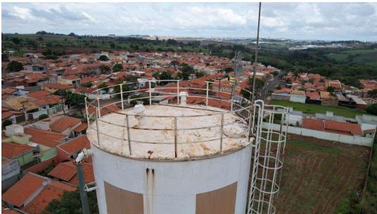
Foto 2 - Detalhes da parte superior do Reservatório R20 - Sistema Santa Maria (1)
