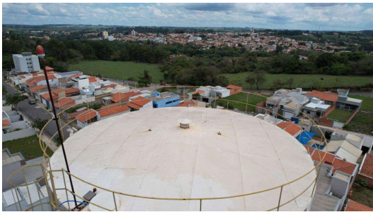
Foto 5 - Parte superior do Reservatório R22 - Sistema Terra Nova com detalhe de sinalização noturna
