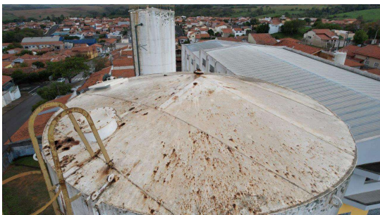
Foto 3 - Vista superior do Reservatório R7 - Sistema Cohab
