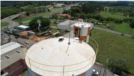
Foto 3 - Vista superior do o Reservatório R10 Sistema Bela Vista com detalhe de para-raios
