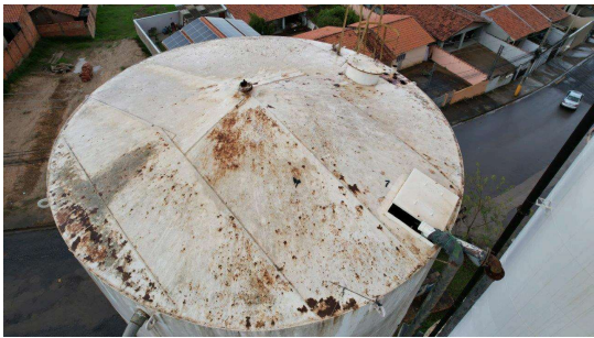
Foto 1 - Detalhe de parte superior do Reservatório R7 - Sistema Cohab - com tampa parcialmente aberta
