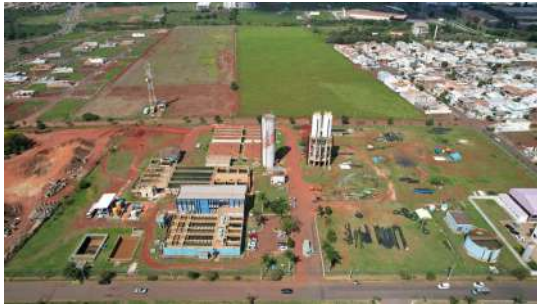
Foto 5 - Reservatório Elevados ETA 4 em Santa Bárbara d'Oeste
