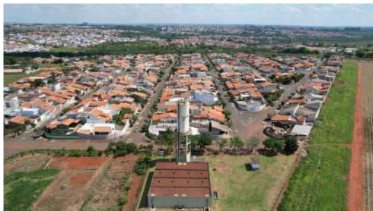
Foto 2 - Reservatório Semi enterrado Vila Rica em Santa Bárbara d'Oeste
