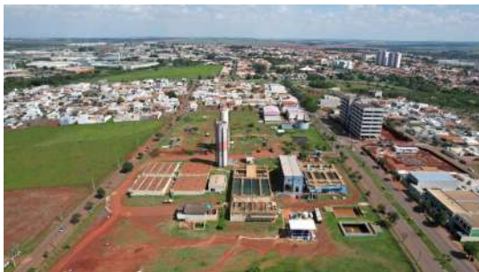
Foto 2 - Reservatório Elevados ETA 4 em Santa Bárbara d'Oeste
