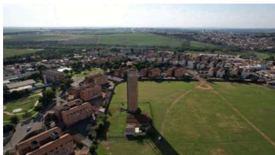
Foto 1 - Reservatório Romano Elevado em Santa Bárbara d'Oeste
