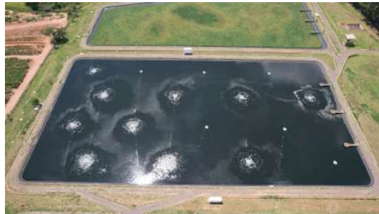
Foto 8 - ETE Balsa em Santa Bárbara d'Oeste
