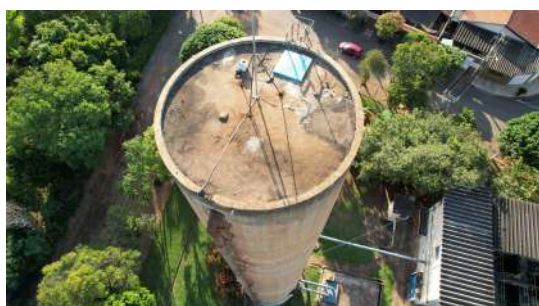
Foto 1 - Reservatório elevado ETA 3 em Santa Bárbara d'Oeste
