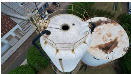
Foto 1 - Reservatório Elevado São Fernando em Santa Bárbara do Oeste
