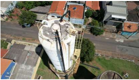
Foto 1 - Reservatório Planalto Elevado em Santa Bárbara d'Oeste
