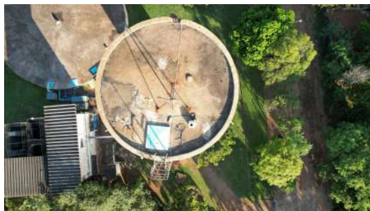
Foto 1 - Reservatório elevado ETA 3 em Santa Bárbara d'Oeste
