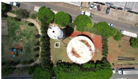
Foto 2 - Reservatório Elevado São Fernando em Santa Bárbara d'Oeste
