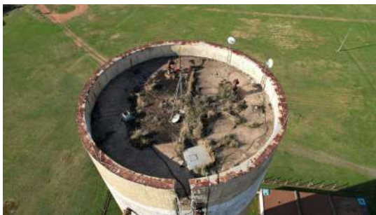
Foto 1 - Reservatório Romano Elevado em Santa Bárbara d'Oeste
