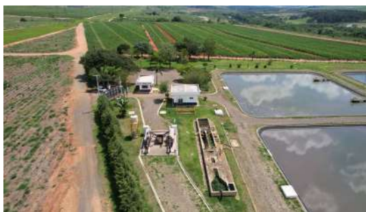
Foto 14 - ETE Balsa em Santa Bárbara d'Oeste
