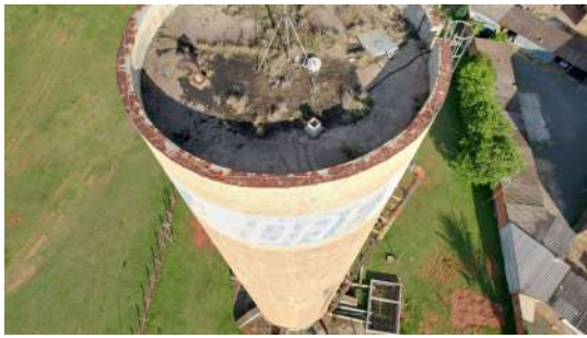
Foto 1 - Reservatório Romano Elevado em Santa Bárbara d'Oeste
