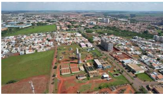
Foto 3 - Reservatório Elevados ETA 4 em Santa Bárbara d'Oeste
