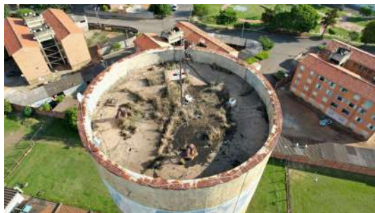
Foto 1 - Reservatório Romano Elevado em Santa Bárbara d'Oeste
