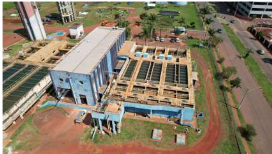
Foto 8 - Reservatório Elevados ETA 4 em Santa Bárbara d'Oeste
