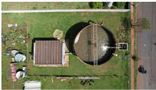
Foto 4 - Reservatório Elevados ETA 4 em Santa Bárbara d'Oeste
