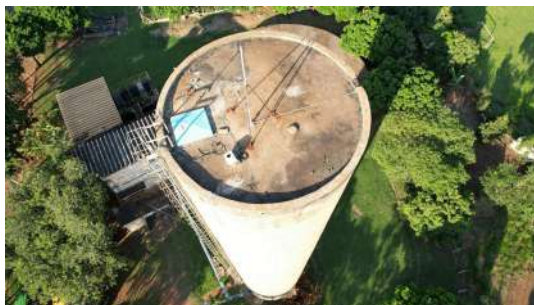
Foto 2 - Reservatório elevado ETA 3 em Santa Bárbara d'Oeste
