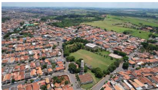
Foto 2 - Reservatório Jardim Europa Elevado em Santa Bárbara d'Oeste
