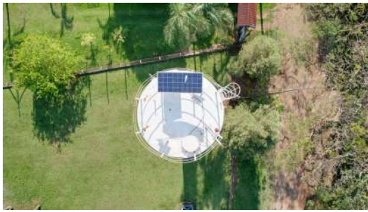
Foto 1 - Reservatório Elevado Andorinhas em Santa Bárbara d'Oeste
