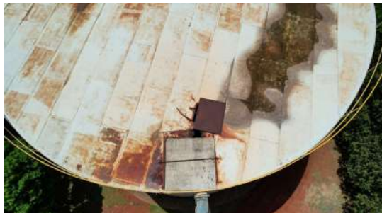
Foto 1 - Reservatório Apoiado São Fernando em Santa Bárbara d'Oeste
