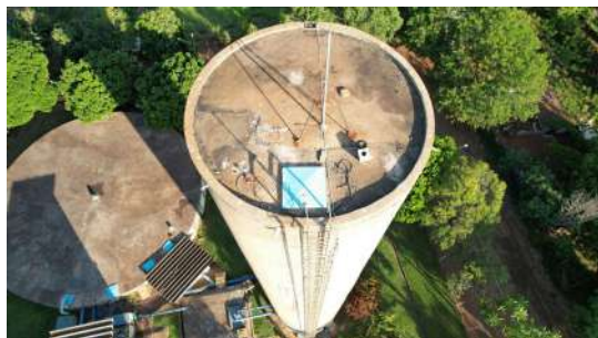
Foto 1 - Reservatório elevado ETA 3 em Santa Bárbara d'Oeste
