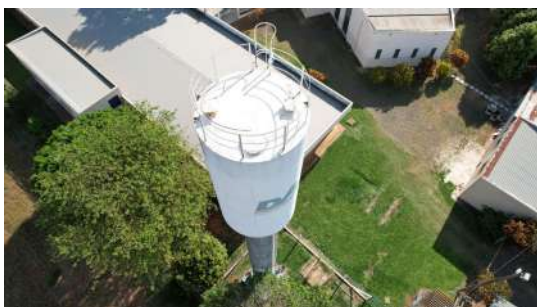
Foto 1 - Reservatório Elevado Sapezeiro em Santa Bárbara do Oeste
