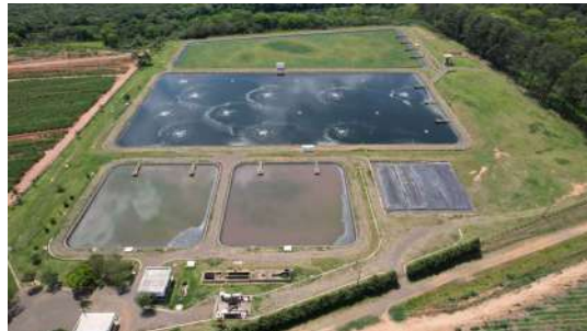
Foto 10 - ETE Balsa em Santa Bárbara d'Oeste
