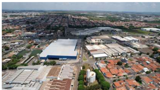
Foto 1 - Reservatório Elevado São Fernando em Santa Bárbara d'Oeste
