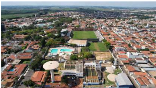
Foto 1 - Reservatório Elevado Cálice ETA 2 em Santa Bárbara d'Oeste
