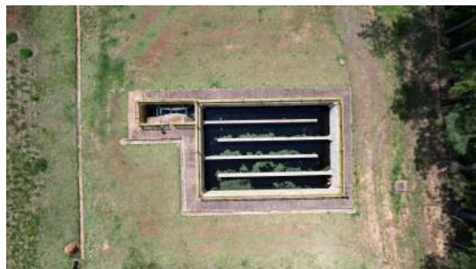
Foto 12 - ETE Balsa em Santa Bárbara d'Oeste
