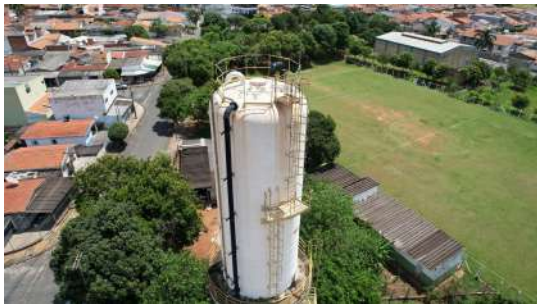
Foto 1 - Reservatório Jardim Europa Elevado em Santa Bárbara do Oeste
