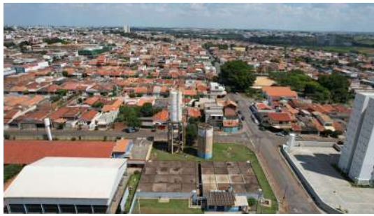
Foto 2 - Reservatórios semi enterrados Planalto em Santa Bárbara d'Oeste
