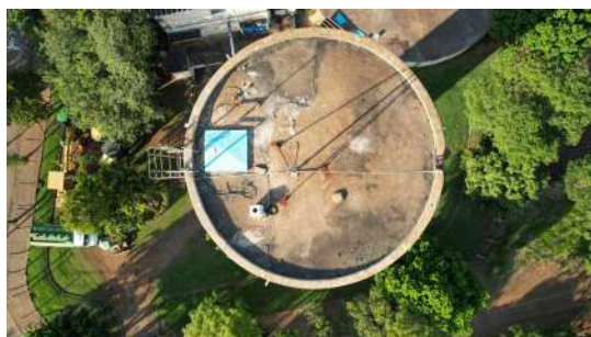
Foto 1 - Reservatório elevado ETA 3 em Santa Bárbara d'Oeste
