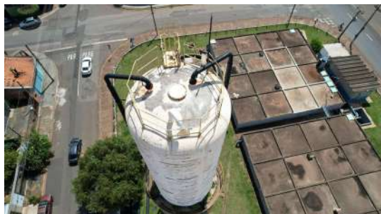
Foto 1 - Reservatório Planalto Elevado em Santa Bárbara do Oeste
