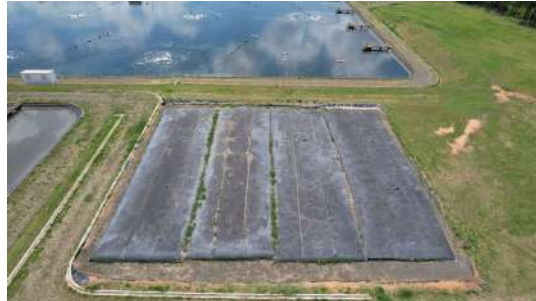
Foto 6 - ETE Balsa em Santa Bárbara d'Oeste
