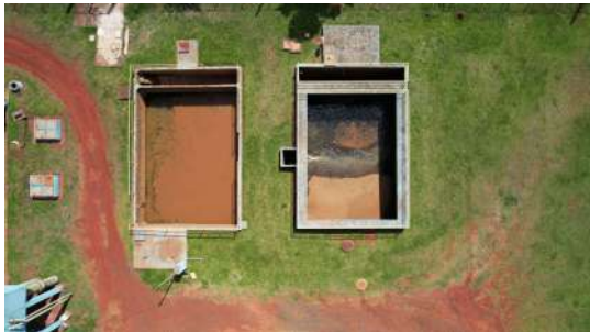
Foto 7 - Reservatório Elevado ETA 4 em Santa Bárbara d'Oeste
