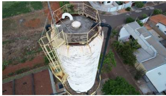
Foto 2 - Reservatório Elevado Vila Rica em Santa Bárbara do Oeste
