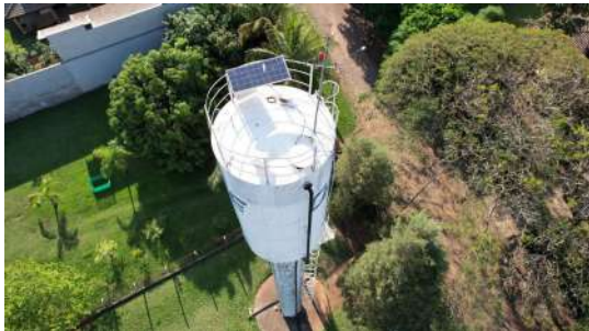
Foto 3 - Reservatório Elevado Andorinhas em Santa Bárbara d'Oeste
