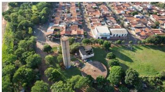
Foto 1 - Reservatório elevado ETA 3 em Santa Bárbara d'Oeste
