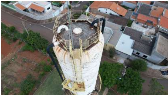
Foto 1 - Reservatório Elevado Vila Rica em Santa Bárbara do Oeste
