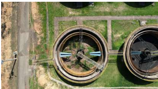
Foto 7 - ETE Toledos I em Santa Bárbara d'Oeste
