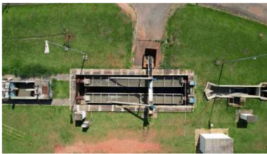
Foto 3 - ETE Toledos I em Santa Bárbara d'Oeste
