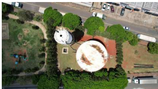
Foto 1 - Reservatório Apoiado São Fernando em Santa Bárbara d'Oeste
