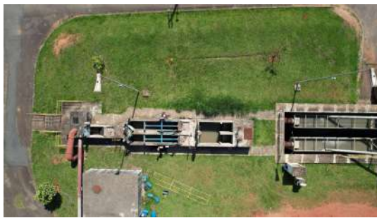
Foto 4 - ETE Toledos I em Santa Bárbara d'Oeste
