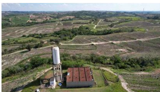
Foto 2 - Reservatório Cruzeiro do Sul Elevado em Santa Bárbara d'Oeste
