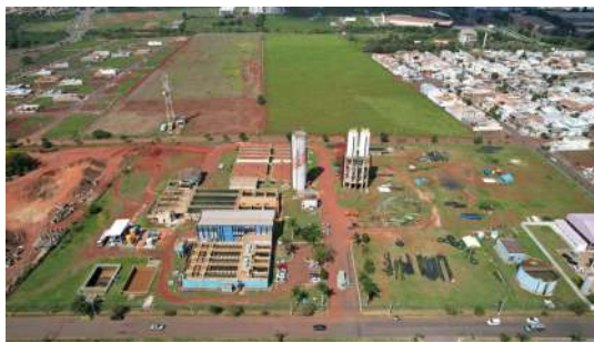
Foto 4 - Reservatório Elevado ETA 4 em Santa Bárbara d'Oeste
