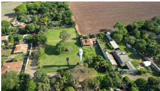
Foto 1 - Reservatório Elevado Andorinhas em Santa Bárbara do Oeste
