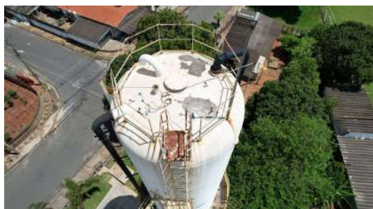
Foto 1 - Reservatório Jardim Europa Elevado em Santa Bárbara d'Oeste
