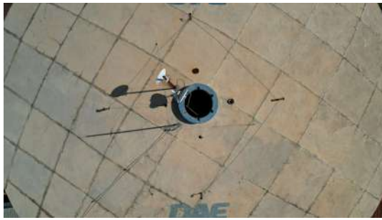
Foto 2 - Reservatório Elevado Cálice ETA 2 em Santa Bárbara d'Oeste
