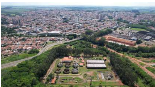
Foto 11 - ETE Toledos I em Santa Bárbara d'Oeste
