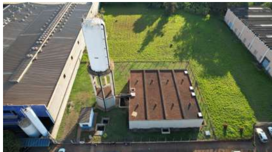
Foto 1 - Reservatório do Distrito Industrial Apoiado em Santa Bárbara d'Oeste
