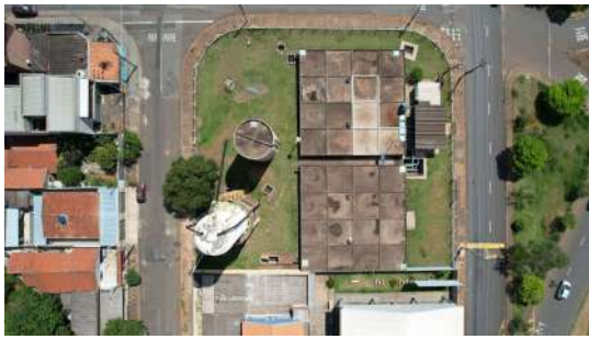
Foto 1 - Reservatórios semi enterrados Planalto em Santa Bárbara d'Oeste
