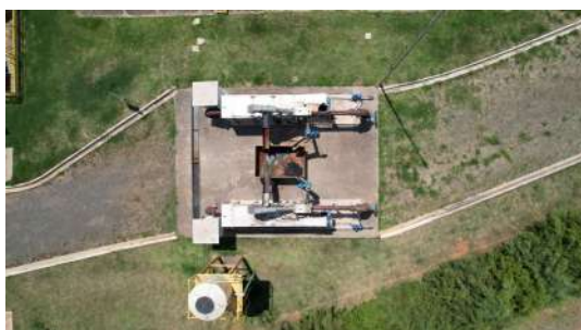
Foto 2 - ETE Balsa em Santa Bárbara d'Oeste
