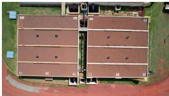
Foto 1 - Reservatórios semi enterrados ETA 4 em Santa Bárbara d'Oeste
