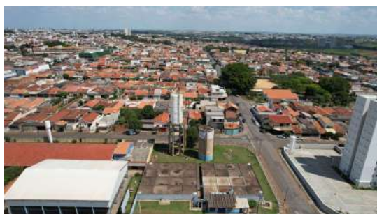
Foto 1 - Reservatório Planalto Elevado em Santa Bárbara do Oeste
