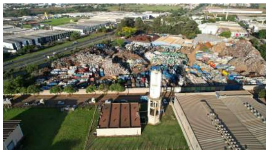
Foto 3 - Reservatório elevado Distrito Industrial em Santa Bárbara d'Oeste
