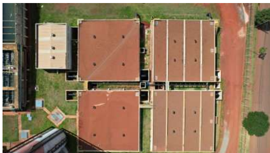
Foto 2 - Reservatórios semi enterrados ETA 4 em Santa Bárbara d'Oeste
