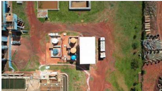
Foto 8 - Reservatório Elevado ETA 4 em Santa Bárbara d'Oeste
