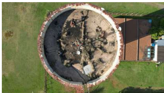
Foto 1 - Reservatório Romano Elevado em Santa Bárbara d'Oeste
