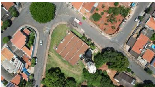
Foto 1 - Reservatório Jardim Europa Apoiado em Santa Bárbara d'Oeste
