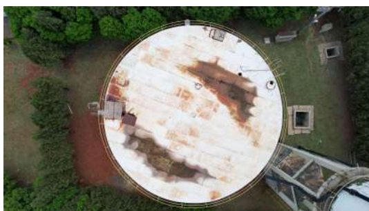
Foto 4 - Reservatório Apoiado São Fernando em Santa Bárbara d'Oeste
