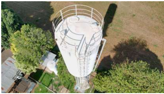
Foto 1 - Reservatório Elevado Sapezeiro em Santa Bárbara d'Oeste
