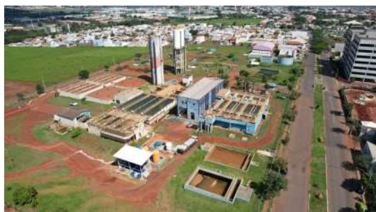
Foto 1 - Reservatório Elevado ETA 4 em Santa Bárbara d'Oeste
