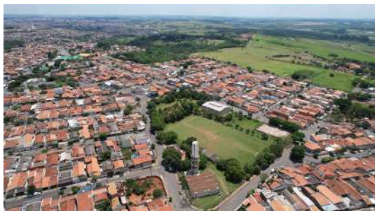
Foto 2 - Reservatório Jardim Europa Apoiado em Santa Bárbara d'Oeste
