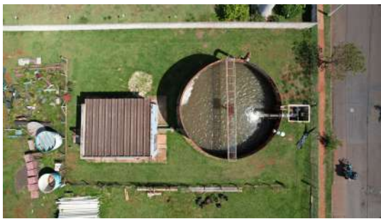
Foto 3 - Reservatório Elevado ETA 4 em Santa Bárbara d'Oeste
