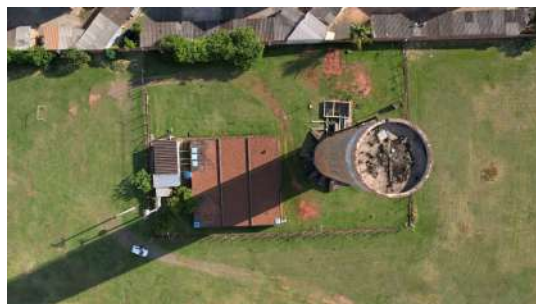
Foto 2 - Reservatório Romano Elevado em Santa Bárbara d'Oeste
