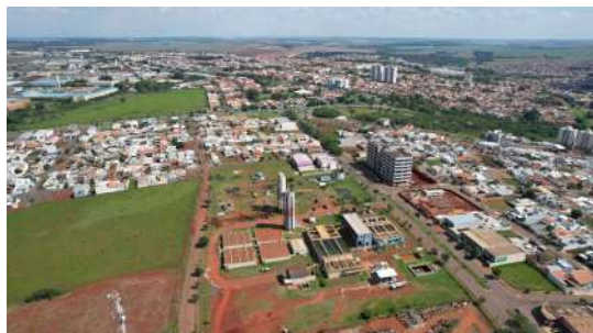
Foto 1 - Reservatórios semi enterrados ETA 4 em Santa Bárbara d'Oeste
