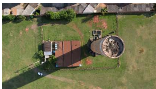
Foto 1 - Reservatório Apoiado Romano em Santa Bárbara d'Oeste
