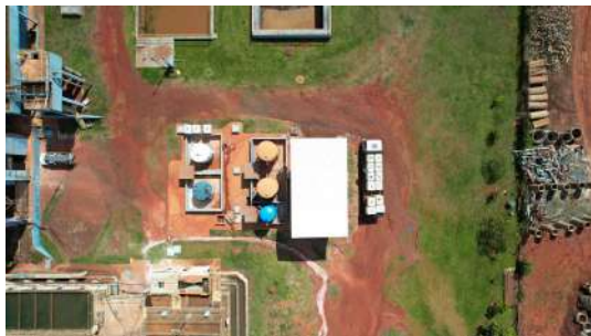
Foto 10 - Reservatório Elevados ETA 4 em Santa Bárbara d'Oeste
