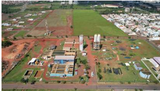
Foto 6 - Reservatório Elevados ETA 4 em Santa Bárbara d'Oeste
