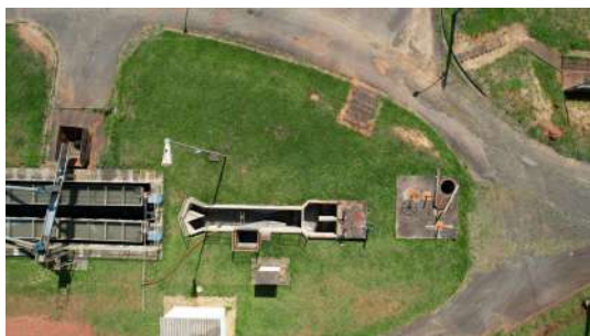
Foto 2 - ETE Toledos I em Santa Bárbara d'Oeste
