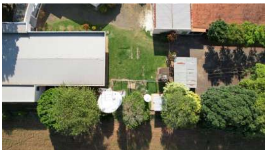
Foto 3 - Reservatório Elevado Sapezeiro em Santa Bárbara do Oeste
