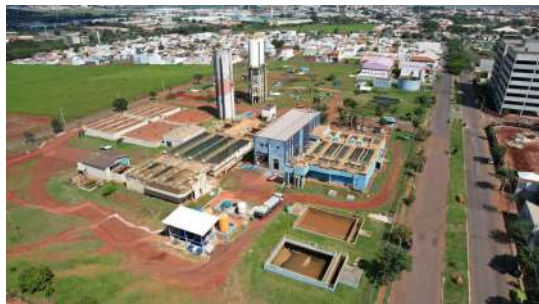
Foto 1 - Reservatório Elevados ETA 4 em Santa Bárbara d'Oeste
