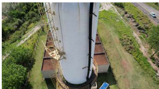
Foto 1 - Reservatório Cruzeiro do Sul Elevado em Santa Bárbara d'Oeste
