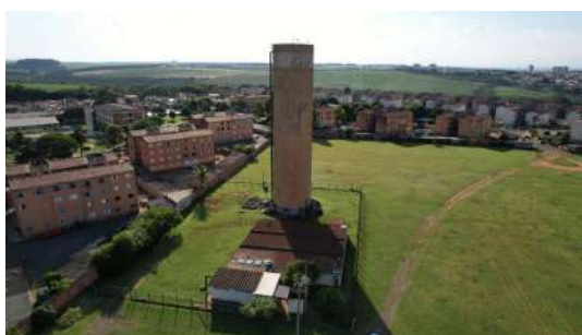
Foto 2 - Reservatório Apoiado Romano em Santa Bárbara d'Oeste
