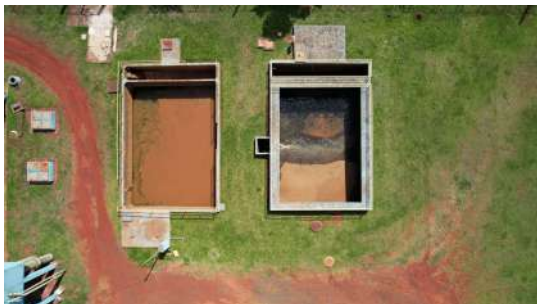
Foto 9 - Reservatório Elevados ETA 4 em Santa Bárbara d'Oeste
