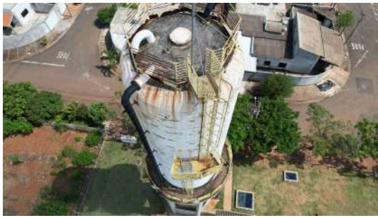
Foto 1 - Reservatório Elevado Vila Rica em Santa Bárbara d'Oeste
