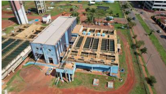
Foto 6 - Reservatório Elevado ETA 4 em Santa Bárbara d'Oeste
