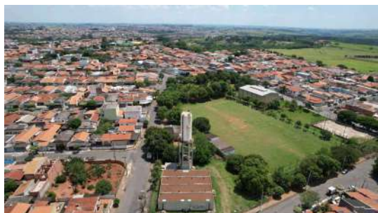
Foto 1 - Reservatório Jardim Europa Elevado em Santa Bárbara d'Oeste
