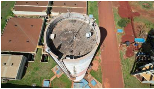
Foto 1 - Reservatório Elevado ETA 4 em Santa Bárbara d'Oeste
