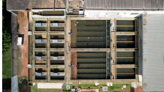
Foto 6 - Reservatório Elevado Cálice ETA 2 em Santa Bárbara d'Oeste
