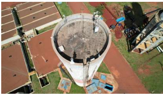
Foto 1 - Reservatório Elevado ETA 4 em Santa Bárbara d'Oeste
