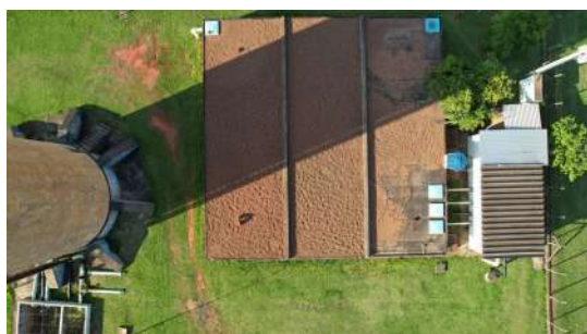
Foto 1 - Reservatório Apoiado Romano em Santa Bárbara d'Oeste
