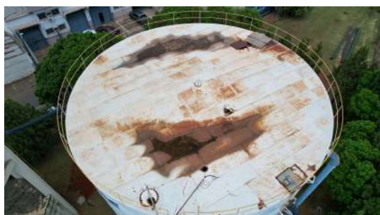
Foto 3 - Reservatório Apoiado São Fernando em Santa Bárbara d'Oeste
