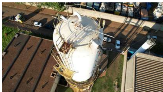
Foto 1 - Reservatório elevado Distrito Industrial em Santa Bárbara d'Oeste
