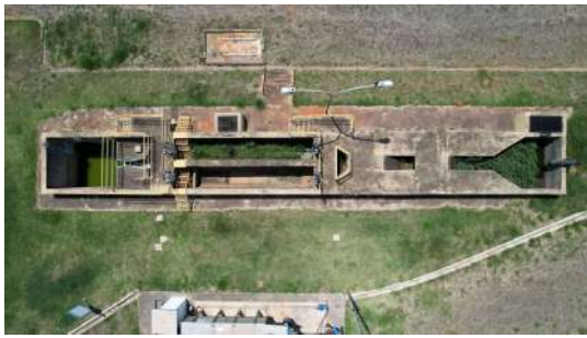
Foto 3 - ETE Balsa em Santa Bárbara d'Oeste
