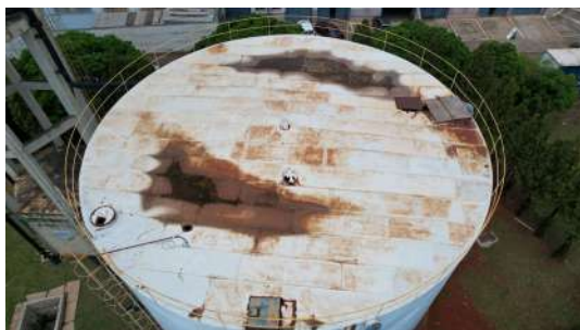
Foto 2 - Reservatório Apoiado São Fernando em Santa Bárbara d'Oeste
