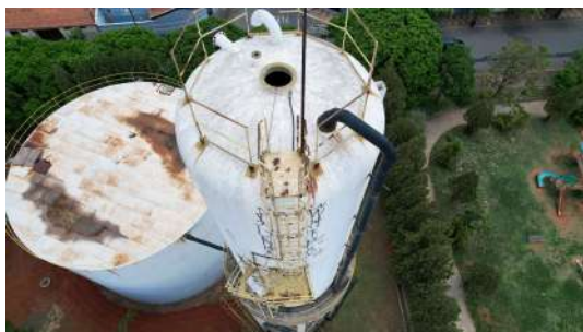
Foto 2 - Reservatório Elevado São Fernando em Santa Bárbara do Oeste
