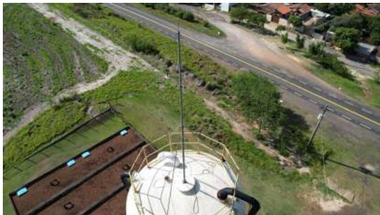
Foto 1 - Reservatório Cruzeiro do Sul Elevado em Santa Bárbara d'Oeste
