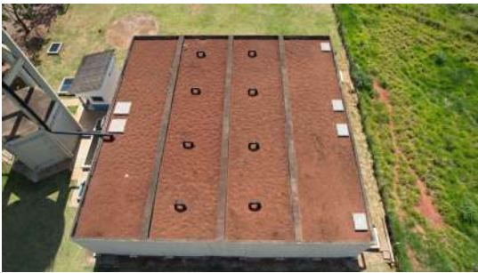
Foto 1 - Reservatório Semi enterrado Vila Rica em Santa Bárbara d'Oeste
