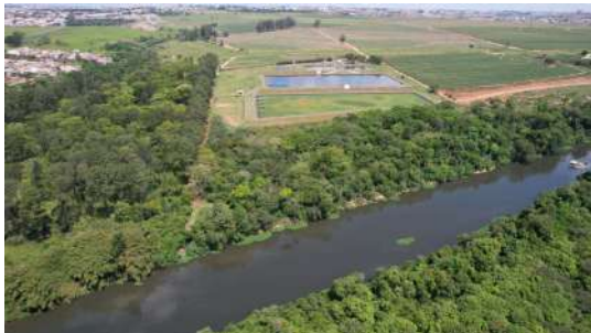
Foto 9 - ETE Balsa em Santa Bárbara d'Oeste
