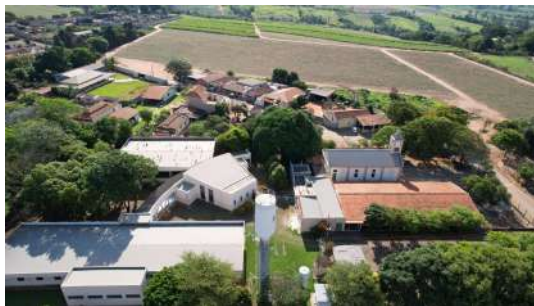
Foto 2 - Reservatório Elevado Sapezeiro em Santa Bárbara do Oeste
