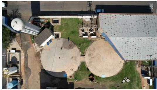
Foto 4 - Reservatório Elevado Cálice ETA 2 em Santa Bárbara d'Oeste
