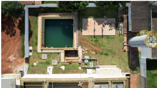
Foto 7 - Reservatório Elevado Cálice ETA 2 em Santa Bárbara d'Oeste
