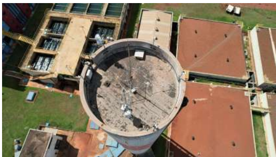
Foto 1 - Reservatório Elevado ETA 4 em Santa Bárbara d'Oeste
