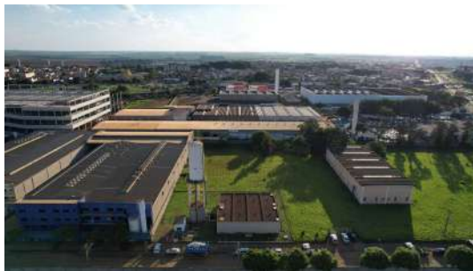
Foto 2 - Reservatório elevado Distrito Industrial em Santa Bárbara d'Oeste
