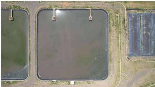
Foto 7 - ETE Balsa em Santa Bárbara d'Oeste
