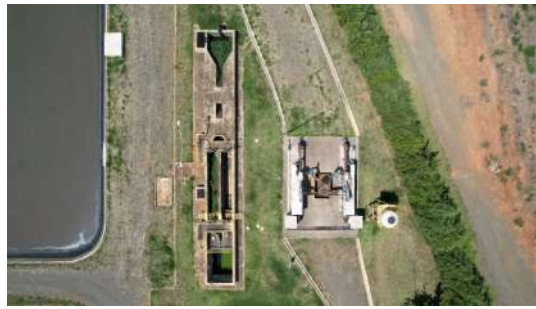
Foto 4 - ETE Balsa em Santa Bárbara d'Oeste
