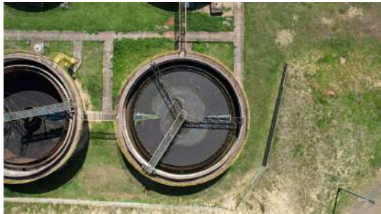
Foto 6 - ETE Toledos I em Santa Bárbara d'Oeste
