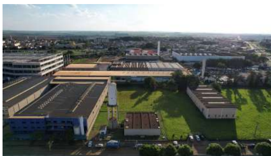
Foto 2 - Reservatório do Distrito Industrial Apoiado em Santa Bárbara d'Oeste
