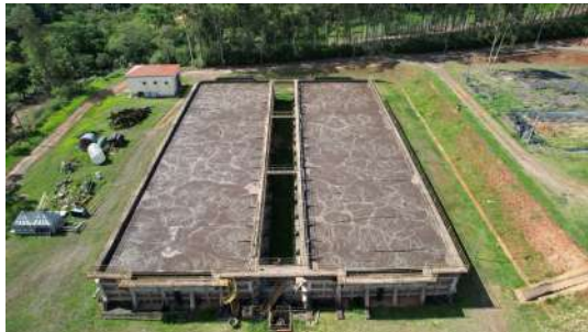
Foto 10 - ETE Toledos I em Santa Bárbara d'Oeste
