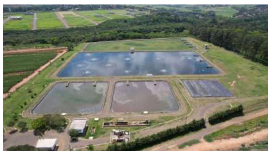
Foto 1 - ETE Balsa em Santa Bárbara d'Oeste
