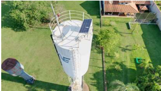
Foto 1 - Reservatório Elevado Andorinhas em Santa Bárbara d'Oeste
