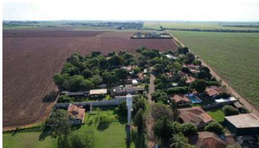
Foto 2 - Reservatório Elevado Andorinhas em Santa Bárbara do Oeste
