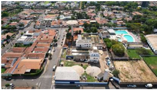
Foto 3 - Reservatório Elevado Cálice ETA 2 em Santa Bárbara d'Oeste
