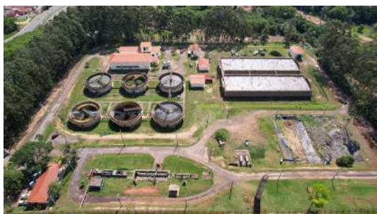
Foto 12 - ETE Toledos I em Santa Bárbara d'Oeste
