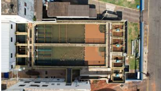
Foto 5 - Reservatório Elevado Cálice ETA 2 em Santa Bárbara d'Oeste
