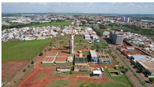
Foto 2 - Reservatório Elevado ETA 4 em Santa Bárbara d'Oeste
