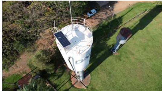
Foto 2 - Reservatório Elevado Andorinhas em Santa Bárbara d'Oeste
