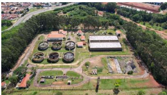
Foto 1 - ETE Toledos I em Santa Bárbara d'Oeste
