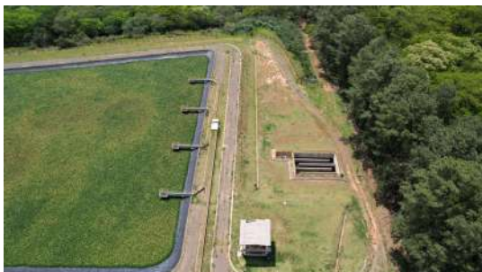
Foto 11 - ETE Balsa em Santa Bárbara d'Oeste
