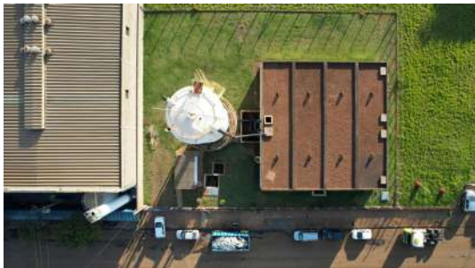
Foto 1 - Reservatório do Distrito Industrial Apoiado em Santa Bárbara d'Oeste
