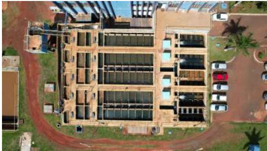
Foto 5 - Reservatório Elevado ETA 4 em Santa Bárbara d'Oeste
