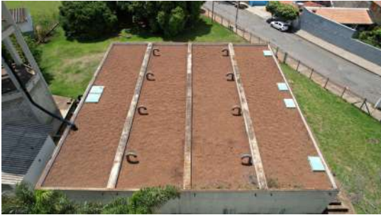
Foto 1 - Reservatório Jardim Europa Apoiado em Santa Bárbara d'Oeste
