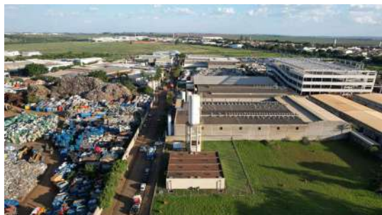
Foto 3 - Reservatório do Distrito Industrial Apoiado em Santa Bárbara d'Oeste
