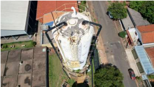
Foto 1 - Reservatório Planalto Elevado em Santa Bárbara d'Oeste
