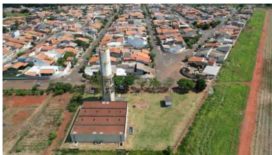
Foto 2 - Reservatório Elevado Vila Rica em Santa Bárbara d'Oeste
