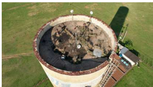
Foto 1 - Reservatório Romano Elevado em Santa Bárbara d'Oeste
