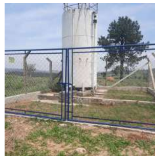
Foto 2 - Portão de acesso ao local
