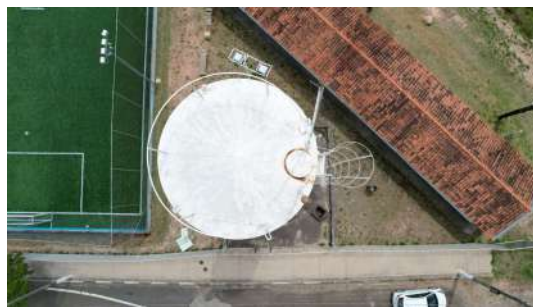
Foto 2 - Vista superior do reservatório Parque Modelo
