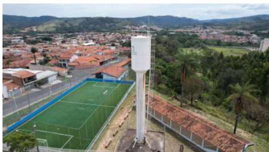
Foto 3 - Reservatório Parque Modelo
