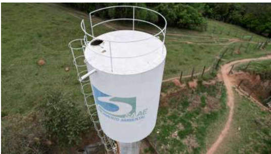
Foto 2 - Vista superior do reservatório Atílio Mazzini
