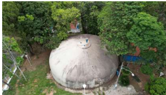
Foto 2 - Vista superior do reservatório ETA I
