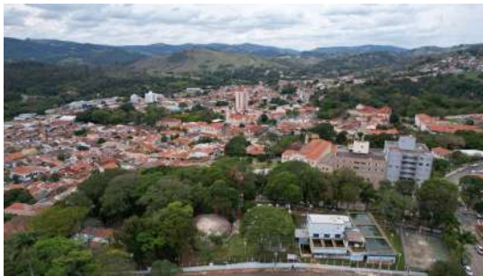
Foto 1 - Vista superior da ETA e reservatório
