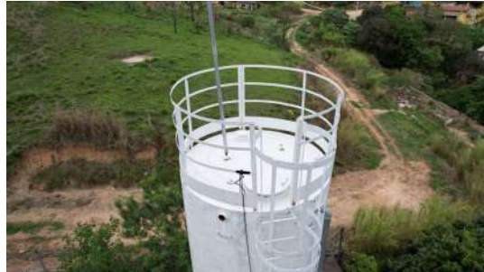
Foto 4 - Vista superior da tampa de inspeção
