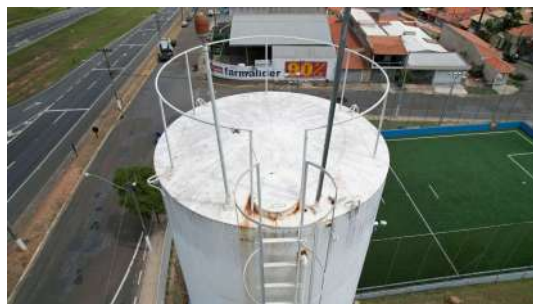
Foto 4 - Vista superior da tampa de inspeção e guarda-corpo
