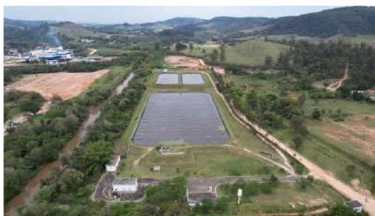
Foto 2 - Vista superior da ETE
