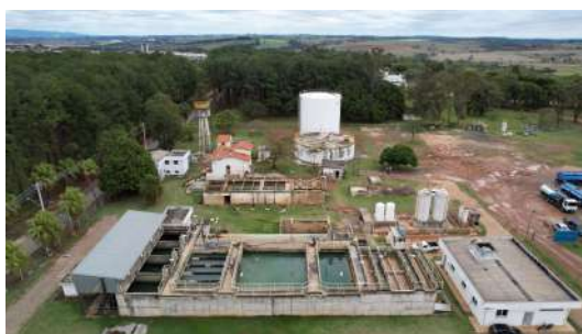
Foto 2 - Vista geral - ETAs Pirapitingui - Nova (abaixo) e Antiga (acima)
