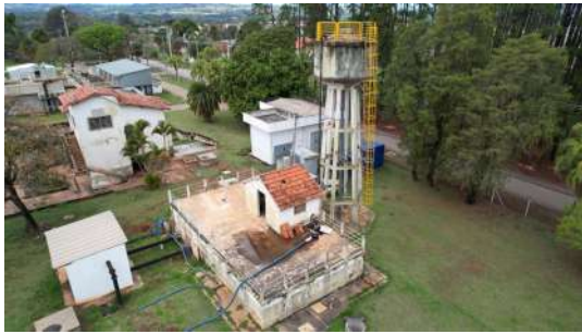
Foto 3 - Vista geral - Reservatório elevado para o Hospital ETA Pirapitingui
