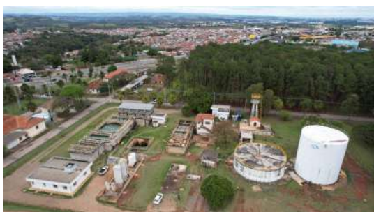
Foto 1 - Vista geral - ETAs Pirapitingui - Nova (à esquerda) e Antiga (centro)
