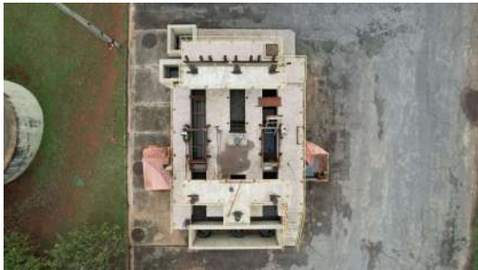
Foto 5 - Tratamento preliminar - ETE Canjica
