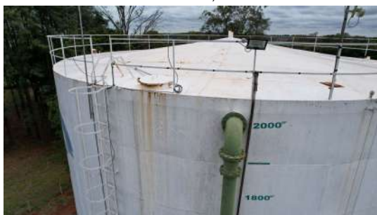
Foto 3 - Vista lateral do reservatório elevado da ETA do Pirapitingui
