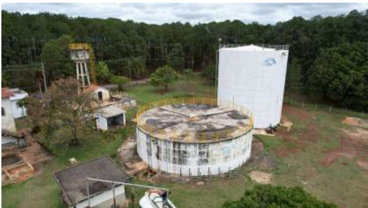
Foto 2 - Vista geral dos 3 Reservatórios da ETA Pirapitingui - Elevado para o Hospital (acima e à
