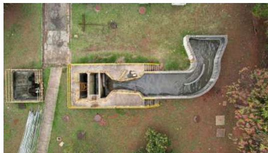
Foto 8 - Calha parshall - ETE Canjica
