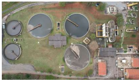
Foto 4 - Vista geral - ETE Canjica
