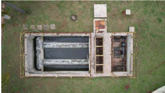
Foto 14 - Aplicação de agente antiespumante - ETE Canjica
