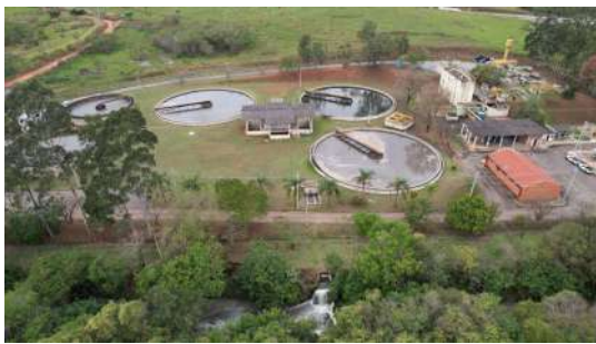
Foto 3 - Vista geral - ETE Canjica
