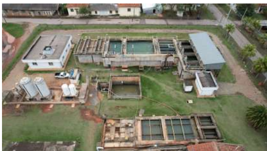
Foto 3 - Vista geral - ETAs Pirapitingui - Nova (acima) e Velha (abaixo)
