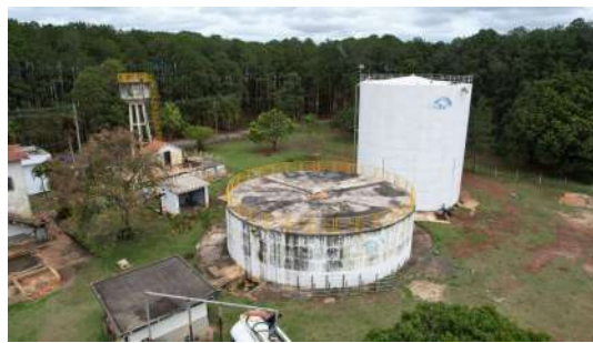
Foto 2 - Vista geral dos 3 Reservatórios da ETA Pirapitingui - Elevado para o Hospital (acima e à esquerda), Apoiado (centro) e Elevado (acima e à direita)
