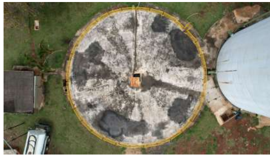
Foto 4 - Tampa de inspeção aberta - Reservatório apoiado ETA Pirapitingui
