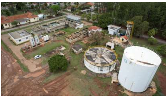
Foto 1 - Vista geral dos 3 Reservatórios da ETA Pirapitingui - Elevado para o Hospital (acima e à direita), Apoiado (centro) e Elevado (abaixo e à direita)
