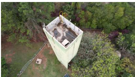
Foto 3 - Vista superior - Reservatório elevado City Castelo
