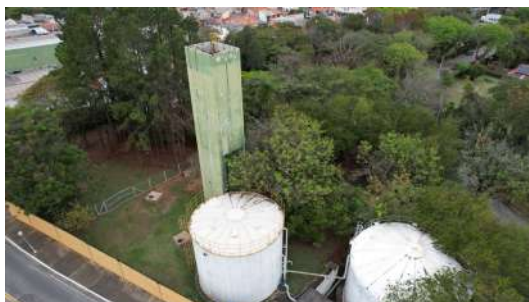
Foto 2 - Vista geral - Reservatório elevado City Castelo (verde ao fundo)
