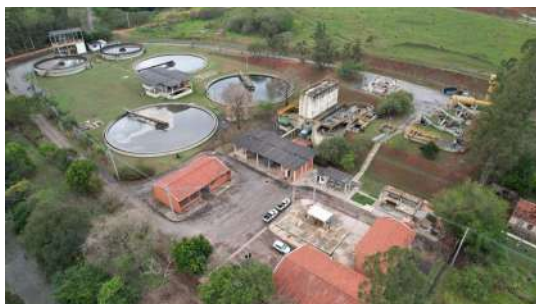
Foto 1 - Vista geral - ETE Canjica
