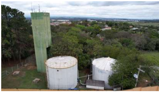
Foto 1 - Vista geral - Reservatório elevado (à esquerda) e apoiados City Castelo
