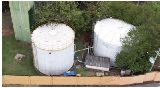
Foto 2 - Reservatórios apoiados City Castelo - Esquerdo (com guarda corpos-amarelo) e Direito (com logo da CIS na lateral)
