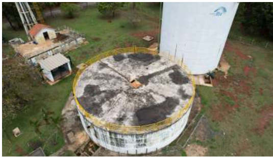
Foto 3 - Vista geral - Reservatório apoiado ETA Pirapitingui
