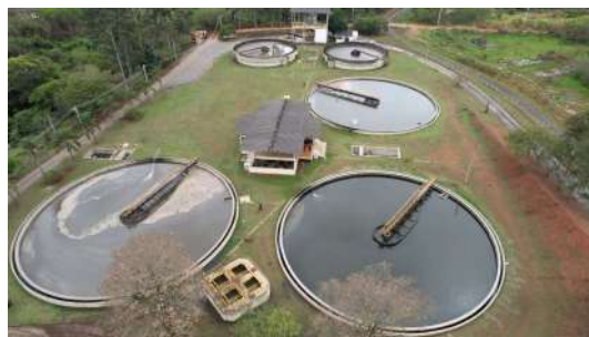
Foto 2 - Vista geral - ETE Canjica
