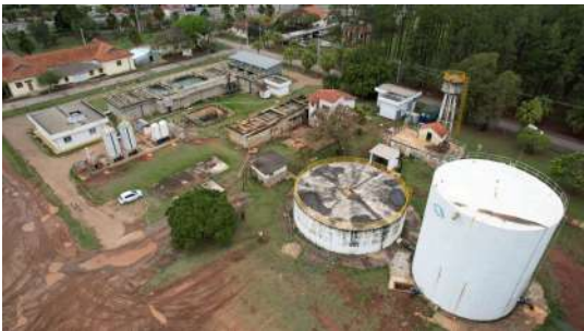
Foto 1 - Vista geral dos 3 Reservatórios da ETA Pirapitingui - Elevado para o Hospital (acima e à
