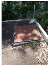
Foto 1 - Tampa de inspeção do reservatório semi enterrado.
