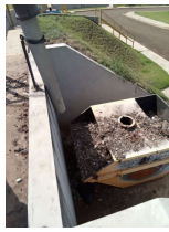
Foto 4 - Caçamba com detritos removidos pelo peneiramento no tratamento preliminar.
