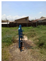
Foto 1 - Cercamento da área.
