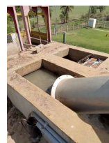
Foto 5 - Peneira rotativa e gradeamento grosseiro.
