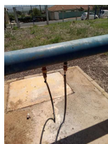
Foto 1 - Aplicação de produtos químicos na tubulação de recalque, que abastece o reservatório
