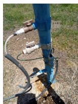
Foto 1 - Aplicação de produtos químicos na água bruta da captação.
