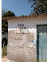
Foto 1 - Abrigo de produtos químicos
