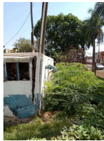
Foto 3 - Extravadores do reservatório enterrado
