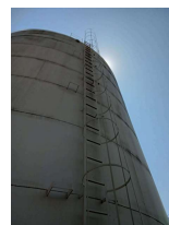
Foto 2 - Escada com guarda-corpo
