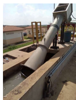
Foto 3 - Peneira rotativa no tratamento preliminar, para separação dos sólidos em suspensão
