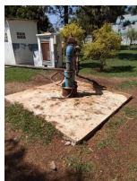
Foto 1 - Laje de concreto.
