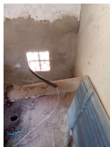
Foto 8 - Tubulação de recalque do poço atravessa a base do reservatório desativado.
