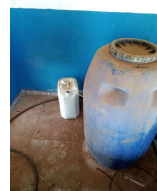
Foto 2 - Armazenamento de hipoclorito de sódio
