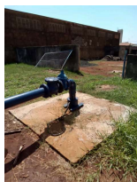
Foto 1 - Laje de concreto.
