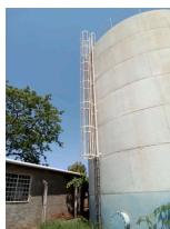
Foto 1 - Escada com guarda-corpo
