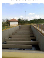
Foto 23 - Chicanas na câmara de contato.
