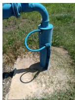
Foto 1 - Laje de concreto.
