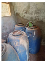
Foto 3 - Armazenamento de produtos para fluoretação e cloração.
