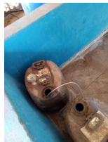
Foto 3 - Armazenamento de ácido fluossilícico para fluoretação.
