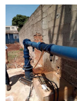
Foto 2 - Aplicação de produtos para cloração e fluoretação.
