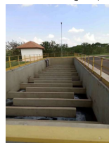
Foto 21 - Câmara de contato com chicanas horizontais para mistura lenta do efluente final.
