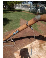
Foto 6 - Mangueiras para aplicação de produtos químicos e sensores para medição de vazão
