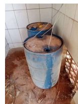
Foto 2 - Armazenamento de produtos químicos para cloração e fluoretacão.
