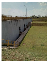
Foto 16 - Canaletas para escoar o lodo.
