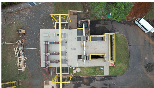
Foto 5 - Elevatória de Esgoto Bruto
