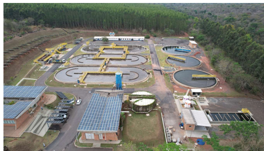
Foto 4 - Vista geral da ETE (2)
