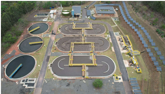
Foto 1 - Vista geral da ETE
