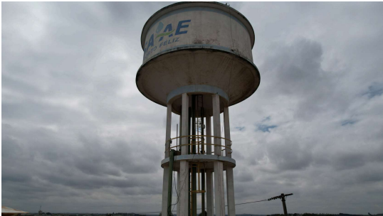
Foto 3 - Lateral do reservatório elevado e descida do para-raios
