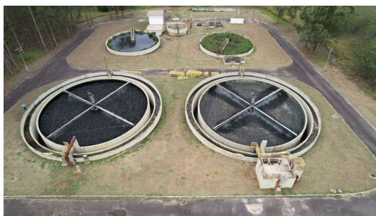
Foto 2 - Filtros biológicos seguidos por decantadores da ETE "Xico do SAAE"
