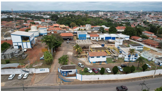
Foto 1 - Visão geral da ETA Vila Progresso
