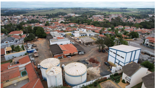
Foto 2 - Visão geral da ETA Vila Progresso (2)
