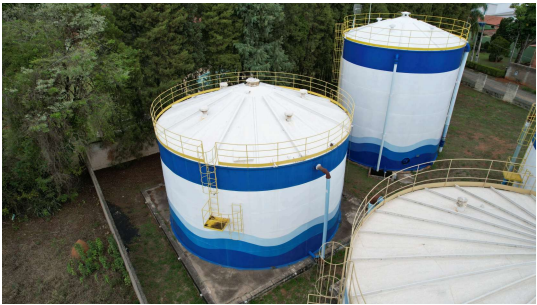
Foto 2 - Detalhes de guarda-corpo e escadas CR Palmital
