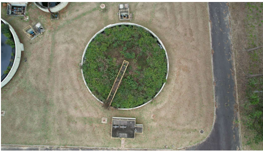
Foto 2 - Decantador coberto por vegetação
