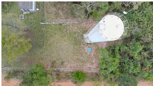
Foto 3 - Vista do Reservatório Uba 2
