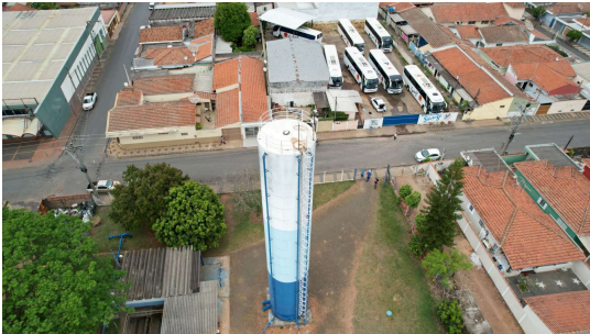
Foto 2 - Vista geral - Reservatório elevado Rua Cinco
