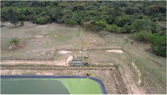
Foto 9 - Saída da lagoa de maturação e escada de aeração (a cima, proxima à área de vegetação ativa) - ETE Itirapina
