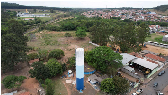
Foto 1 - Vista geral - Reservatório elevado Rua Cinco
