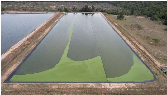
Foto 3 - Vista geral - ETE Itirapina
