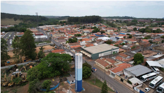
Foto 3 - Vista geral - Reservatório elevado Rua Cinco
