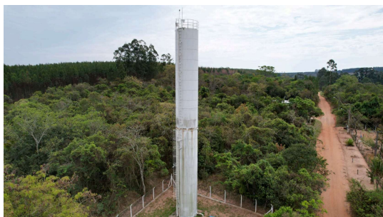
Foto 1 - Vista do Reservatório Uba 2
