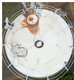
Foto 2 - Maior detalhe da parte superior do reservatório
