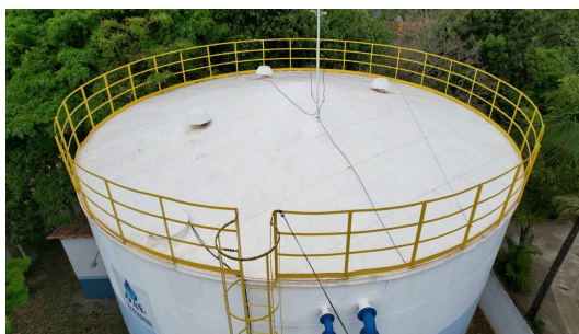
Foto 2 - Vista geral do Reservatório apoiado BROA
