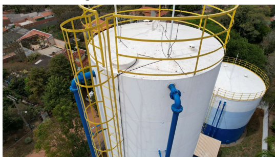
Foto 3 - Vista geral - Reservatório elevado BROA
