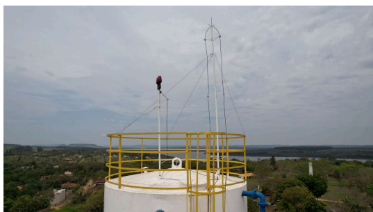
Foto 1 - Para-raios - Reservatório elevado BROA
