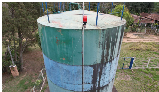
Foto 4 - Vista geral - Reservatório Uba 1
