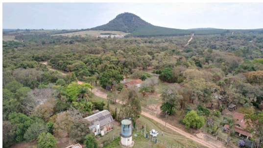
Foto 1 - Vista geral - Reservatório Uba 1
