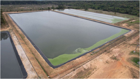
Foto 7 - Lagoa facultativa (centro) e de maturação (direita) - ETE Itirapina
