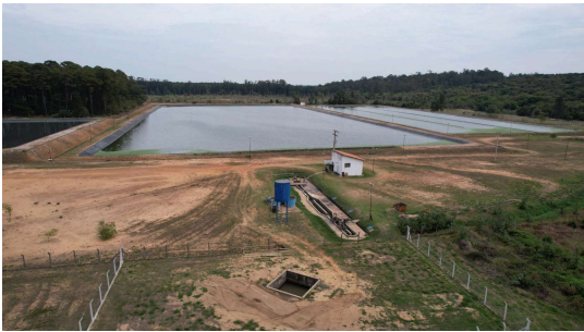
Foto 4 - Vista geral - ETE Itirapina
