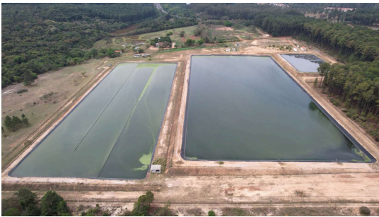
Foto 2 - Vista geral - ETE Itirapina
