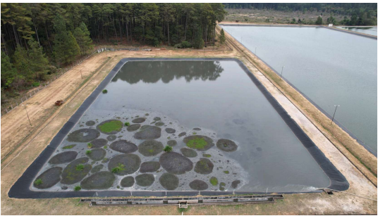
Foto 6 - Lagoa anaeróbia - ETE Itirapina
