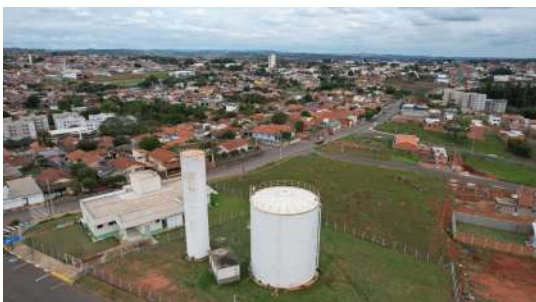
Foto 1 - Vista geral dos reservatórios no Jardim Brasília.
