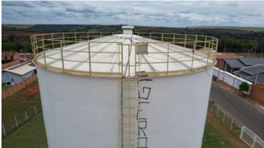
Foto 6 - Vista lateral do reservatório 2.
