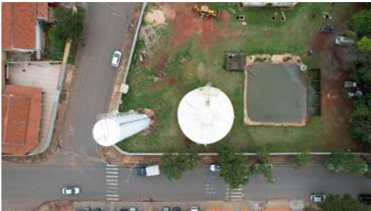
Foto 2 - Vista superior dos reservatórios metálicos.
