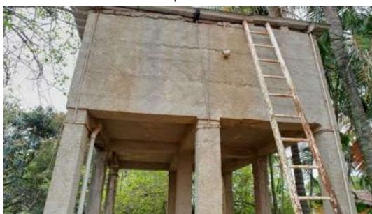
Foto 4 - Vista inferior do reservatório.
