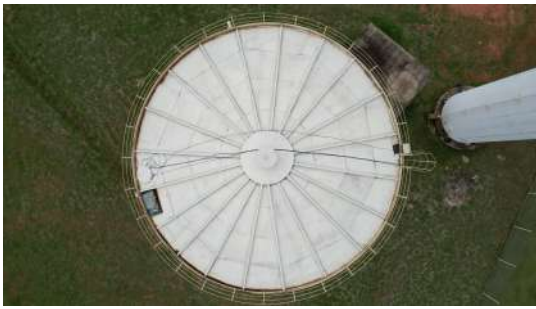
Foto 4 - Vista superior do reservatório 2.
