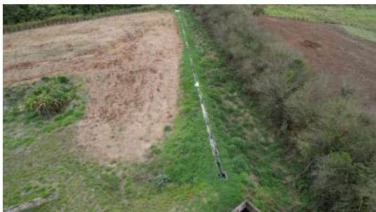
Foto 6 - Caminho do efluente tratado.
