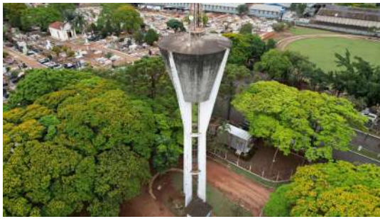
Foto 1 - Vista geral do reservatório elevado de concreto dentro da ETA Saudade.
