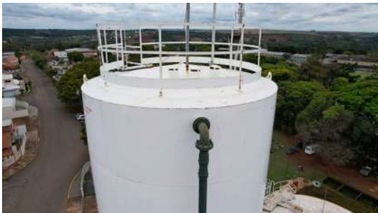
Foto 1 - Detalhe do extravasor.
