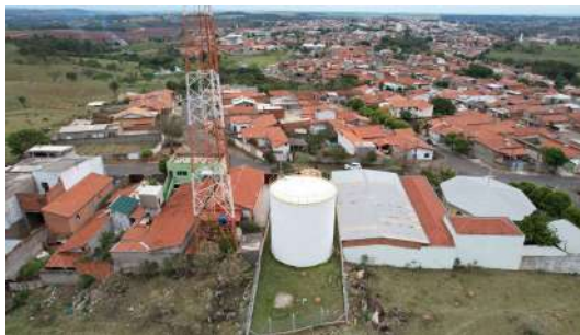
Foto 2 - Vista geral do reservatório São Judas (operante) ao lado de uma torre de telecomunicações.
