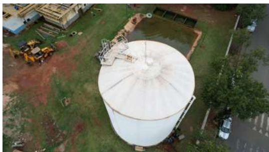
Foto 1 - Vista geral do reservatório.
