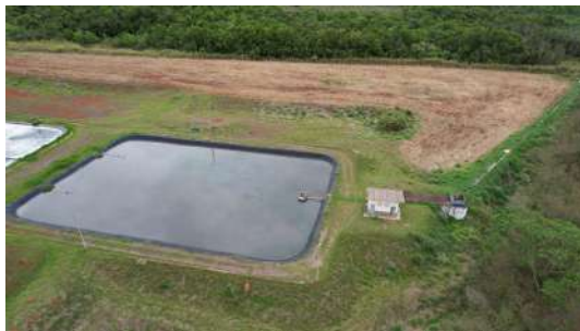
Foto 5 - Estrutura próxima ao ponto de lançamento do efluente tratado.
