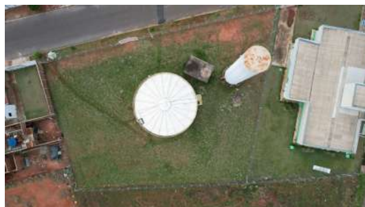
Foto 2 - Vista superior dos reservatórios.
