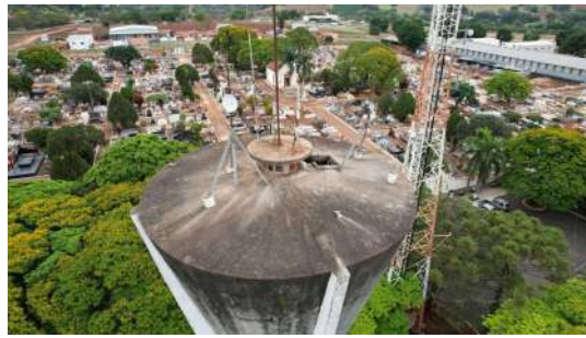
Foto 2 - Detalhe das estruturas no topo do reservatório.
