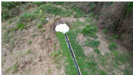
Foto 7 - Formação de espuma próximo ao local de lançamento do efluente, indicando possíveis deficiências na operação da ETE.
