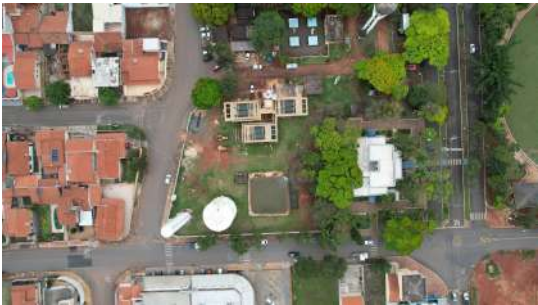
Foto 1 - Vista geral dos reservatórios metálicos dentro da ETA Saudade.
