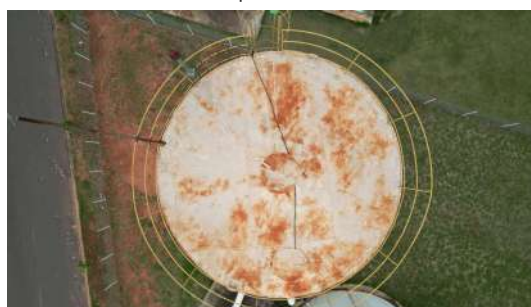
Foto 3 - Vista superior do reservatório 1.
