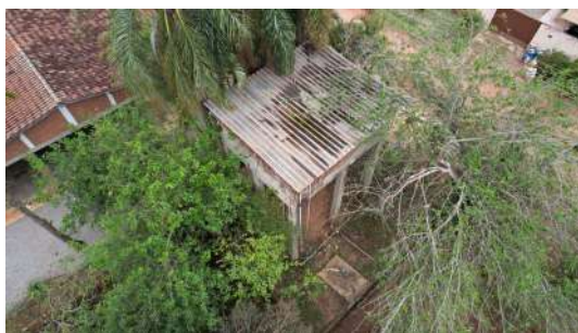
Foto 2 - Vista superior do reservatório.
