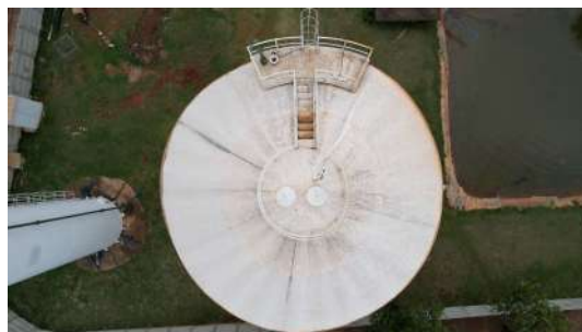
Foto 2 - Vista superior do reservatório.
