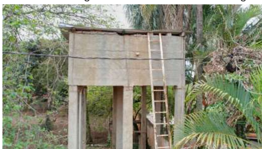
Foto 3 - Vista lateral do reservatório.
