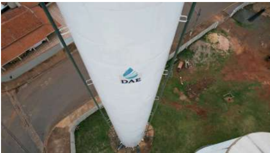
Foto 3 - Vista lateral do reservatório elevado metálico.
