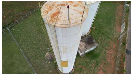
Foto 5 - Vista lateral do reservatório 1.
