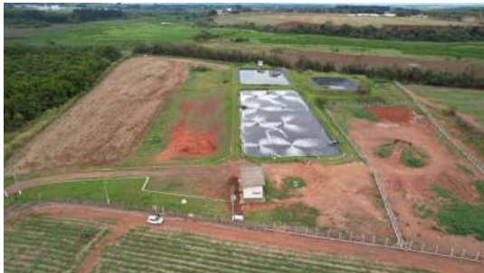
Foto 1 - Vista geral da ETE de Santo Antônio de Posse.
