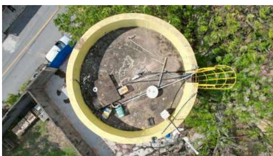
Foto 1 - Tampa de inspeção em aparente bom estado.
