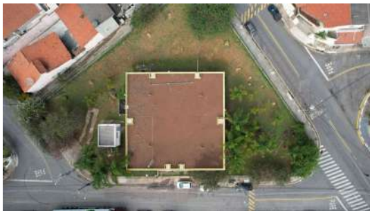
Foto 1 - Vista superior do reservatório 2 milhões.
