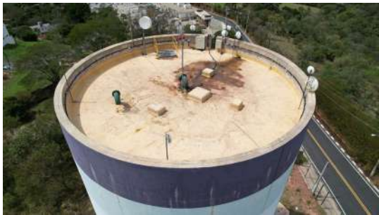
Foto 1 - Detalhe do topo do reservatório, evidenciando tampa de inspeção em boas condições e tubulações de ventilação.
