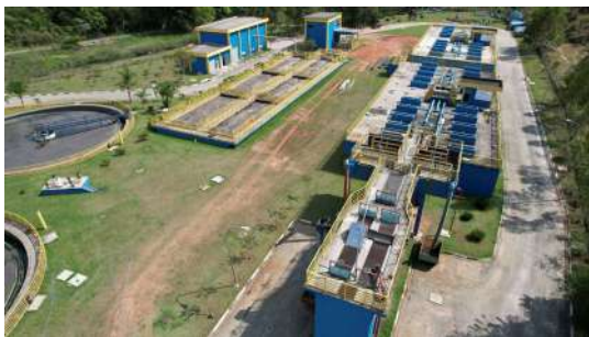
Foto 5 - Vista geral 5 da ETE Louveira.
