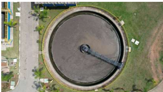
Foto 9 - Detalhe dos decantadores secundários.
