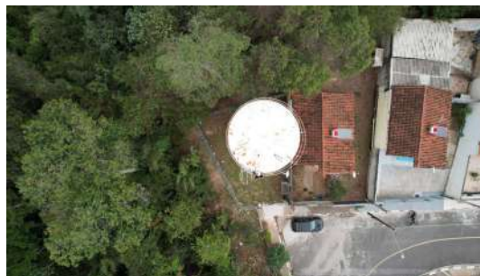
Foto 2 - Vista superior do reservatório.
