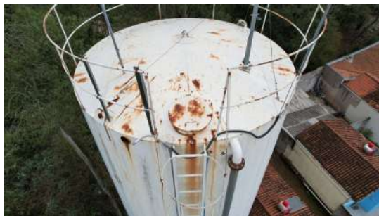
Foto 1 - Detalhe da tampa de inspeção do reservatório.
