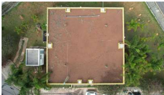
Foto 2 - Vista superior aproximada do reservatório.
