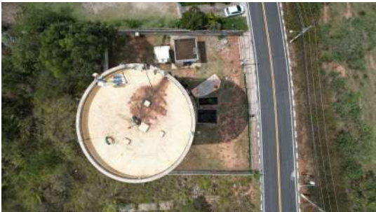
Foto 2 - Vista superior do reservatório.
