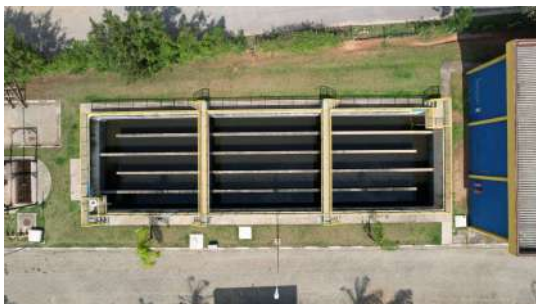
Foto 10 - Saída do efluente tratado.
