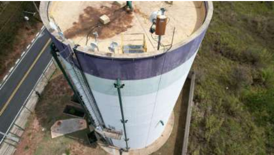
Foto 3 - Vista lateral do reservatório.
