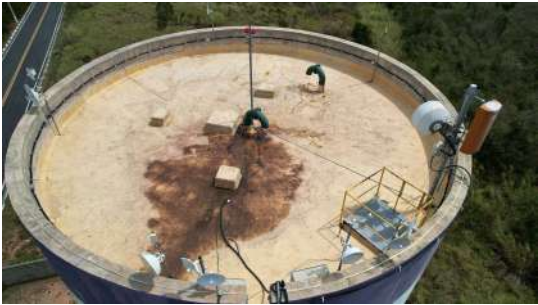
Foto 1 - Detalhe da haste do para-raios.
