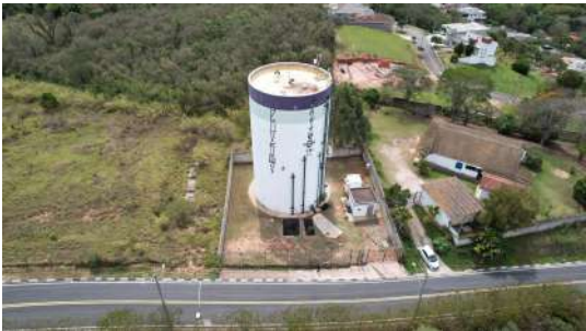
Foto 1 - Vista geral do reservatório.
