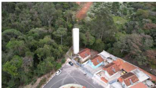
Foto 1 - Vista geral do reservatório popular III.
