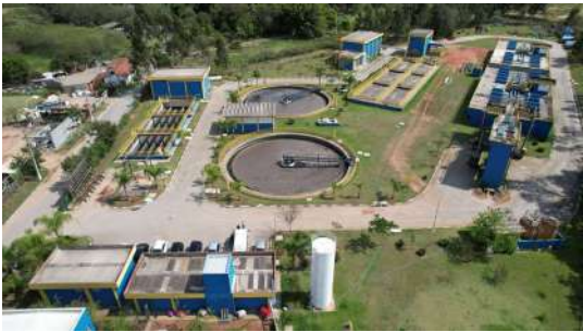
Foto 1 - Vista geral 1 da ETE Louveira.
