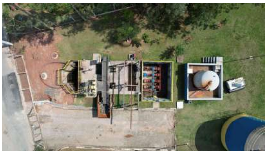
Foto 6 - Elevatória de esgoto bruto da ETE.
