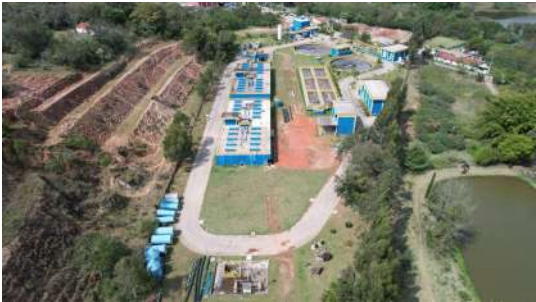
Foto 4 - Vista geral 4 da ETE Louveira.
