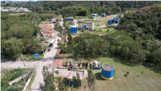
Foto 3 - Vista geral 3 da ETE Louveira.
