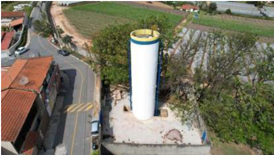
Foto 1 - Vista geral do reservatório.
