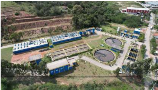
Foto 2 - Vista geral 2 da ETE Louveira.
