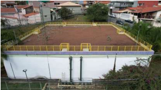
Foto 1 - Detalhe dos tubos extravasores nas laterais.
