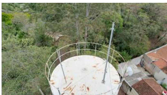
Foto 1 - Detalhe da haste do para-raio no topo do reservatório.
