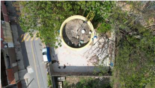
Foto 2 - Vista superior do reservatório.
