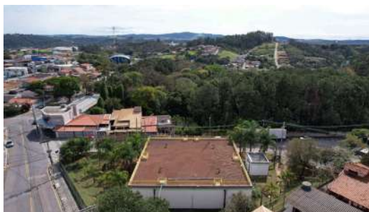
Foto 4 - Vista geral do reservatório.
