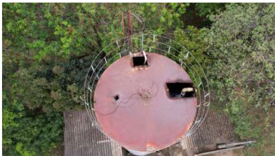
Foto 1 - Reservatório elevado Triunfo em Pedreira
