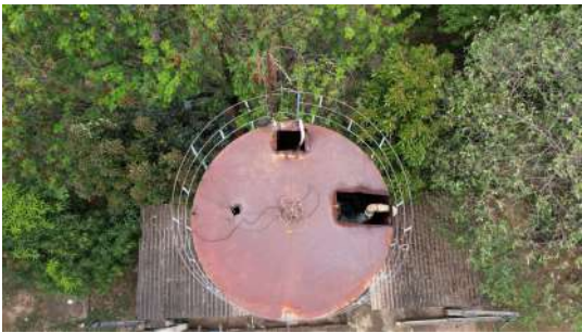
Foto 2 - Reservatório elevado Triunfo em Pedreira
