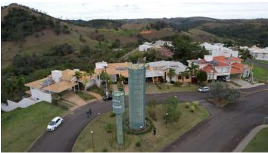
Foto 2 - Reservatório elevado Colinas de São Pedro 2 em Pedreira
