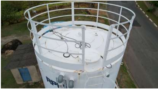
Foto 1 - Reservatório elevado Santa Edwiges em Pedreira
