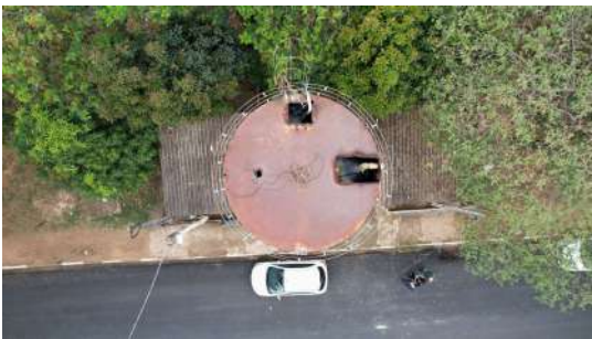
Foto 1 - Reservatório elevado Triunfo em Pedreira
