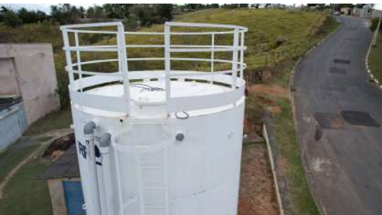
Foto 1 - Reservatório elevado Santa Edwiges em Pedreira
