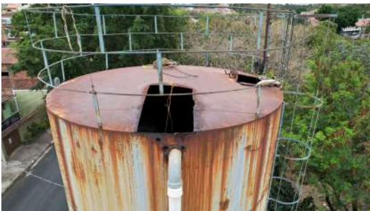
Foto 2 - Reservatório elevado Triunfo em Pedreira
