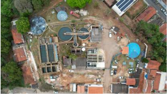
Foto 2 - ETA de Pedreira
