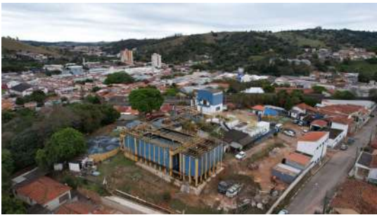
Foto 6 - ETA de Pedreira
