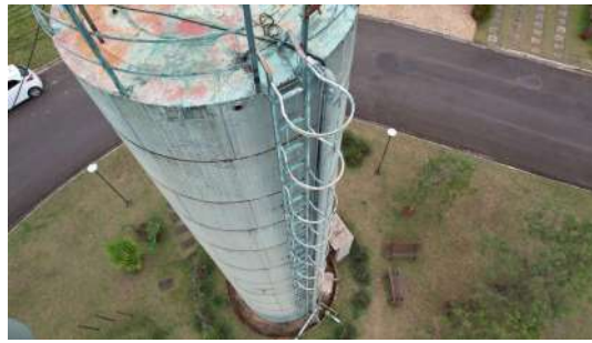
Foto 2 - Reservatório elevado Colinas de São Pedro 1 em Pedreira
