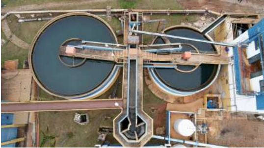
Foto 1 - ETA de Pedreira
