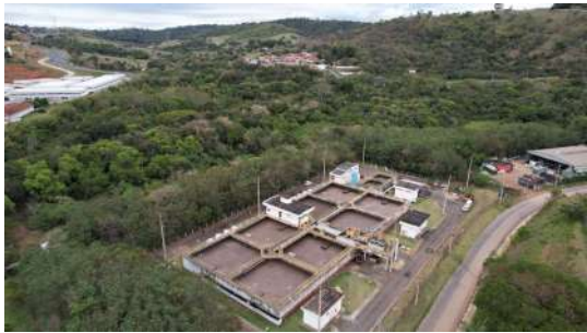
Foto 5 - ETE de Pedreira
