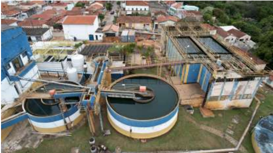
Foto 9 - ETA de Pedreira
