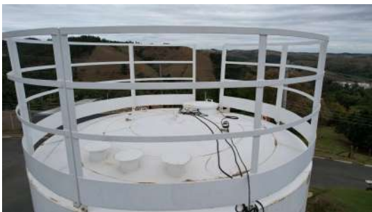
Foto 1 - Reservatório elevado Santa Edwiges em Pedreira
