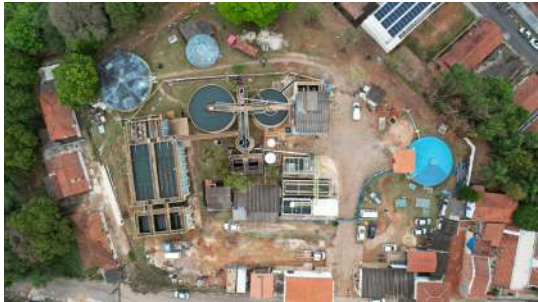
Foto 3 - ETA de Pedreira
