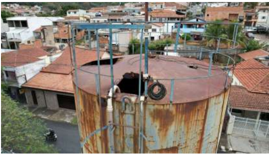
Foto 3 - Reservatório elevado Triunfo em Pedreira
