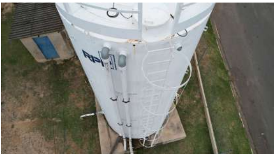
Foto 2 - Reservatório elevado Santa Edwiges em Pedreira
