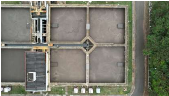
Foto 3 - ETE de Pedreira
