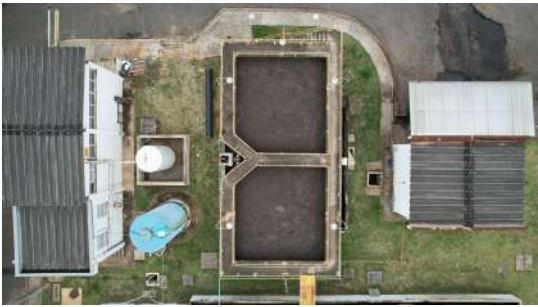
Foto 1 - ETE de Pedreira
