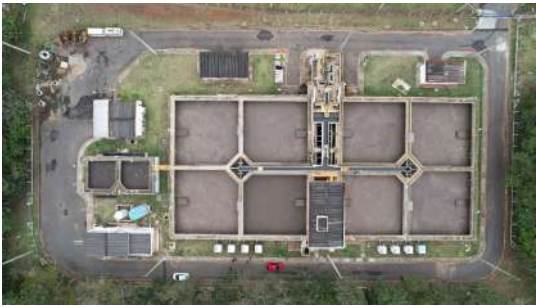
Foto 2 - ETE de Pedreira
