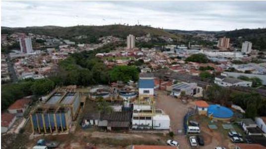
Foto 8 - ETA de Pedreira
