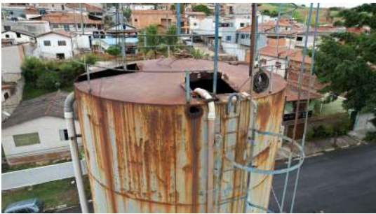
Foto 1 - Reservatório elevado Triunfo em Pedreira
