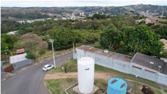
Foto 1 - Reservatório elevado Santa Edwiges em Pedreira
