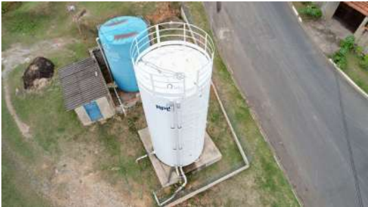
Foto 2 - Reservatório elevado Santa Edwiges em Pedreira
