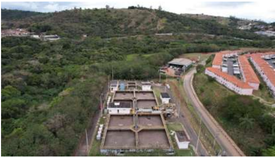
Foto 4 - ETE de Pedreira
