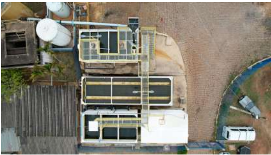
Foto 5 - ETA de Pedreira
