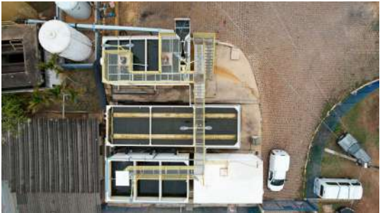
Foto 4 - ETA de Pedreira
