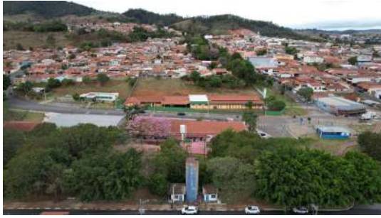
Foto 1 - Reservatório elevado Triunfo em Pedreira
