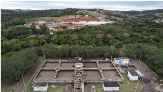
Foto 6 - ETE de Pedreira
