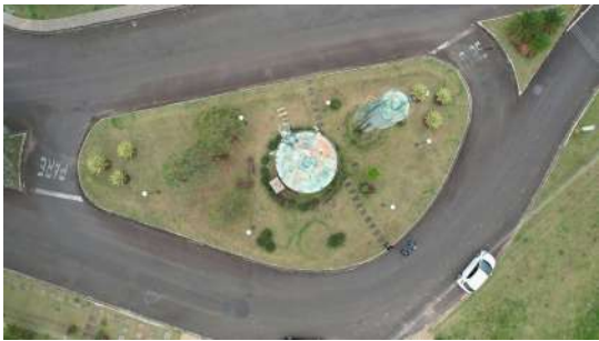
Foto 1 - Reservatório elevado Colinas de São Pedro 2 em Pedreira
