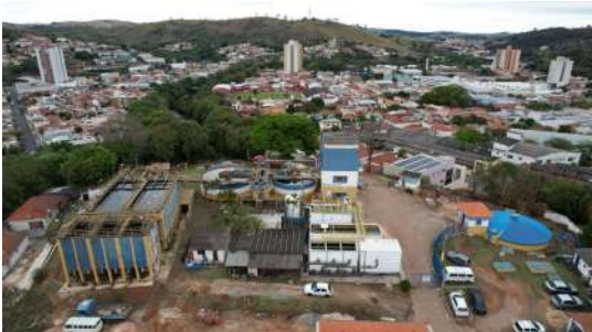
Foto 7 - ETA de Pedreira
