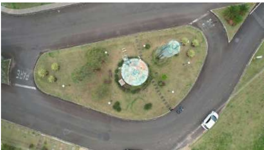
Foto 1 - Reservatório elevado Colinas de São Pedro 1 em Pedreira
