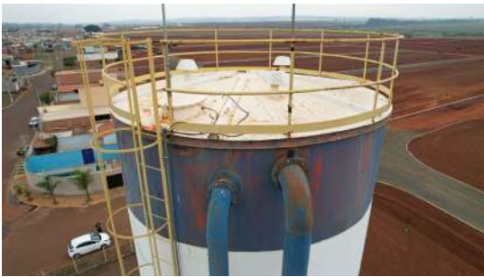
Foto 2 - Para-raios do Reservatório Elevado Santa Carolina em Leme
