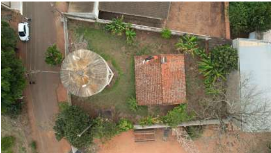
Foto 3 - Reservatório Elevado Taquari Bairro em Leme
