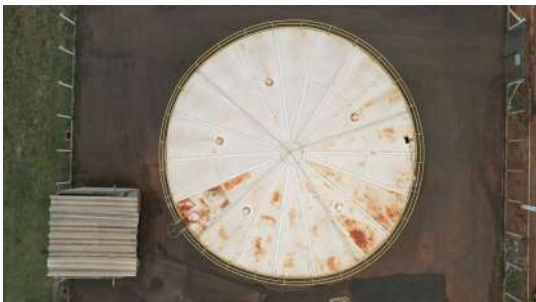
Foto 1 - Reservatório Apoiado Santa Carolina em Leme
