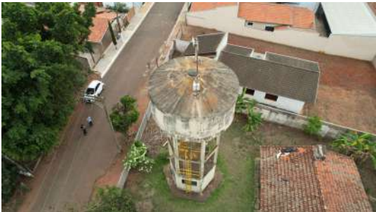
Foto 2 - Reservatório Elevado Taquari Bairro em Leme
