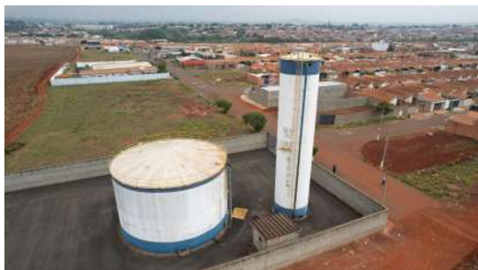
Foto 1 - Reservatório elevado Jardim Empyrio em Leme
