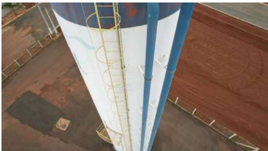
Foto 1 - Escada do Reservatório Elevado Santa Carolina em Leme
