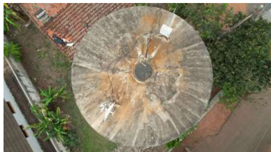
Foto 1 - Reservatório Elevado Taquari Bairro em Leme
