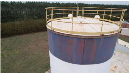
Foto 2 - Guarda-corpos do Reservatório Elevado Santa Carolina em Leme
