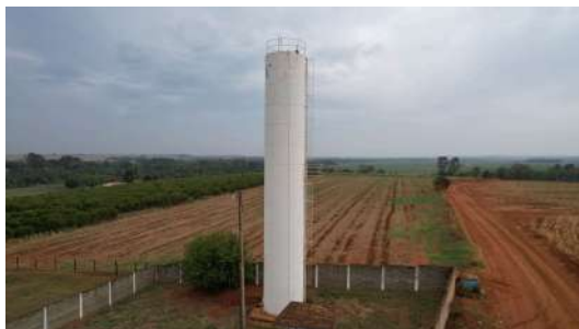
Foto 2 - Reservatório Elevado Taquari Ponte em Leme
