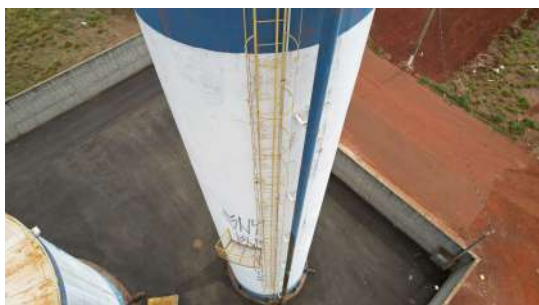
Foto 1 - Escada do Reservatório elevado Jardim Empyrio em Leme
