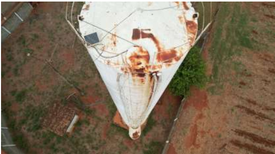
Foto 1 - Reservatório Elevado Taquari Ponte em Leme
