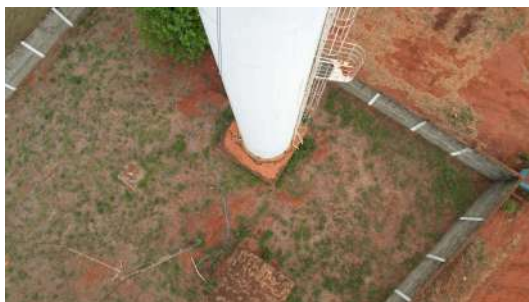
Foto 2 - Reservatório Elevado Taquari Ponte em Leme
