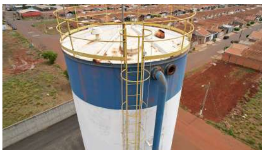
Foto 2 - Guarda-corpos do Reservatório elevado Jardim Empyrio em Leme
