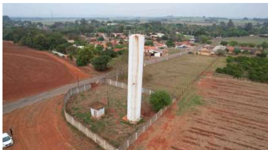
Foto 1 - Reservatório Elevado Taquari Ponte em Leme
