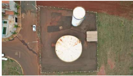
Foto 2 - Reservatório Apoiado Santa Carolina em Leme
