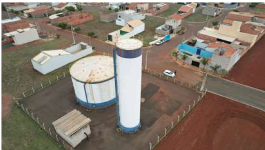
Foto 1 - Reservatório Elevado Santa Carolina em Leme
