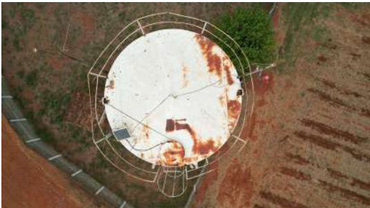
Foto 2 - Reservatório Elevado Taquari Ponte em Leme
