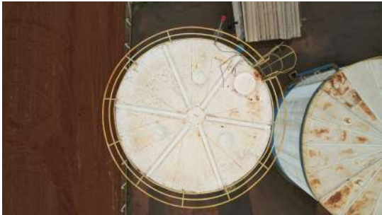
Foto 1 - Reservatório Elevado Santa Carolina em Leme
