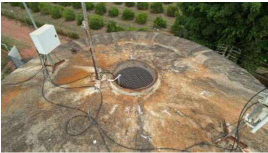
Foto 1 - Reservatório Elevado Taquari Bairro em Leme
