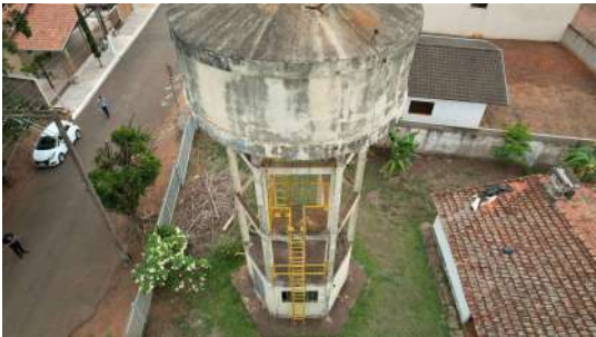
Foto 1 - Reservatório Elevado Taquari Bairro em Leme
