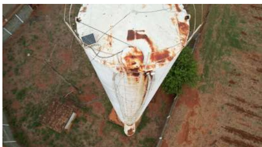
Foto 1 - Reservatório Elevado Taquari Ponte em Leme
