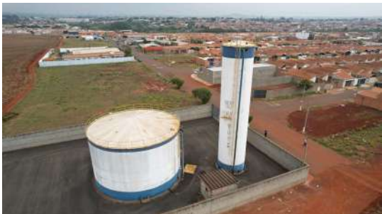
Foto 1 - Reservatório Apoiado Empyrio em Leme
