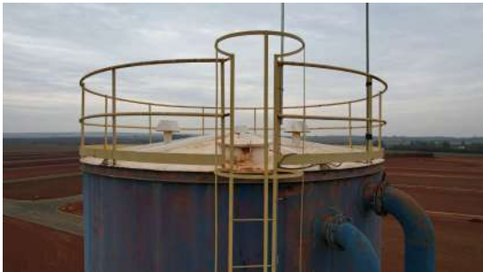
Foto 1 - Reservatório Elevado Santa Carolina em Leme
