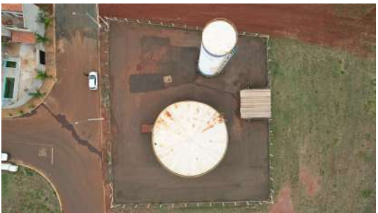
Foto 2 - Reservatório Elevado Santa Carolina em Leme
