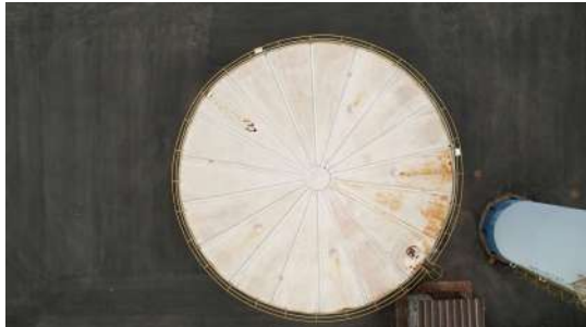
Foto 1 - Reservatório Apoiado Empyrio em Leme
