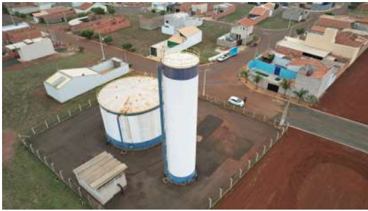
Foto 1 - Reservatório Apoiado Santa Carolina em Leme
