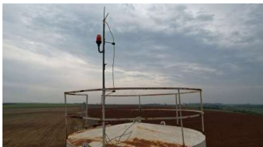
Foto 1 - Reservatório Elevado Taquari Ponte em Leme
