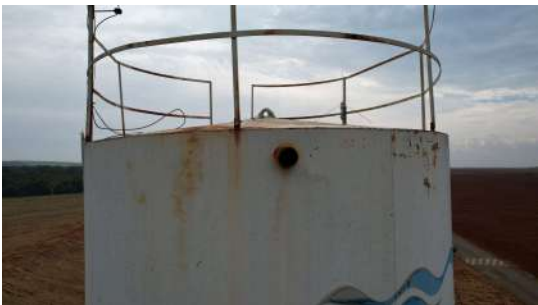
Foto 1 - Reservatório Elevado Taquari Ponte em Leme
