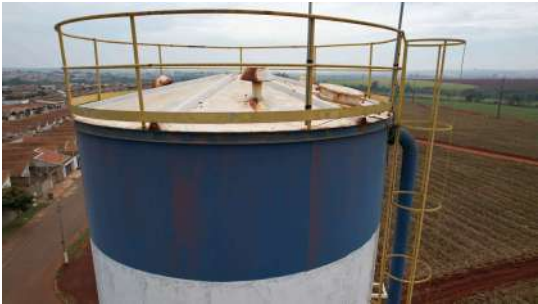
Foto 1 - Vista do Reservatório elevado Jardim Empyrio em Leme
