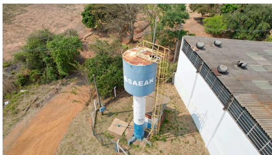
Foto 2 - Visão geral do Reservatório Martinelli (2)
