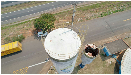
Foto 3 - vista da parte superior do Reservatório Elevado Sacilotto
