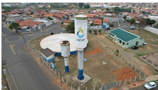
Foto 1 - Visão geral dos Reservatórios Sacilotto
