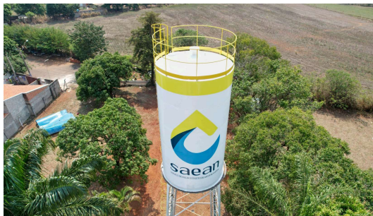
Foto 2 - Reservatório Lolly aspecto geral
