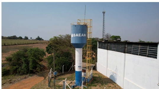
Foto 1 - Visão geral do Reservatório Martinelli (1)
