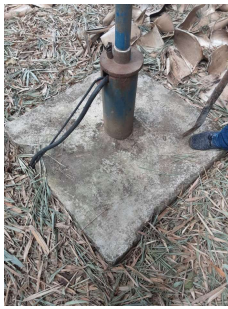
Foto 1 - Laje da Captação subterrânea Ponte Preta em Monte Alegre do Sul
