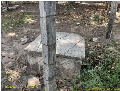
Foto 1 - Vista do Poço do Bairro dos limas
