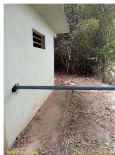
Foto 2 - Vista da Captação subterrânea Ponte Preta em Monte Alegre do Sul
