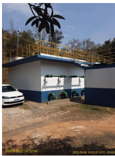
Foto 3 - Vista da ETA Monte Alegre
