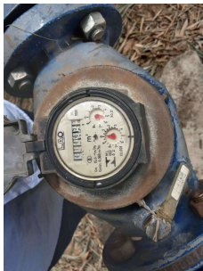
Foto 1 - Macromedidor da Captação subterrânea Ponte Preta em Monte Alegre do Sul
