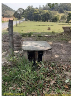
Foto 1 - Vista do Poço do Bairro dos Limas
