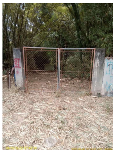
Foto 1 - Entrada da Captação subterrânea Ponte Preta em Monte Alegre do Sul
