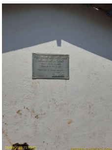
Foto 1 - Identificação do Poço do Bairro das Mostardas
