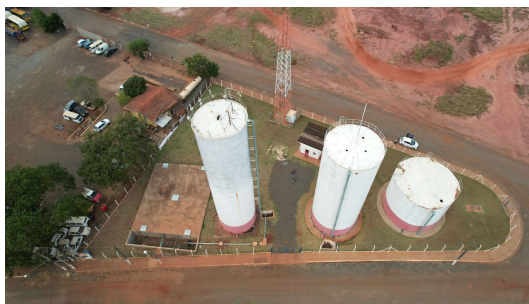
Foto 2 - Vista aérea posterior dos reservatórios.
