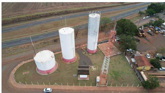
Foto 1 - Vista aérea frontal dos reservatórios.
