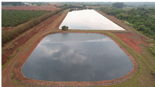
Foto 1 - Vista aérea 1 da ETE - Estrada do Bode Branco.
