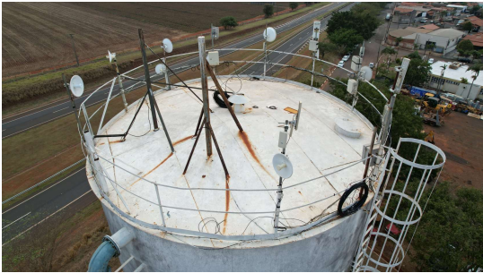
Foto 1 - Vista dos guarda-corpos em torno do topo do reservatório.
