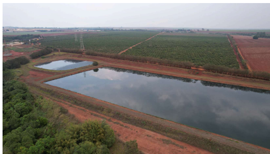
Foto 2 - Vista aérea 2 da ETE - Estrada do Bode Branco.
