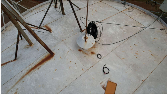
Foto 1 - Detalhe da tubulação de ventilação com proteção em cone.
