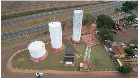
Foto 1 - Vista aérea frontal dos reservatórios.
