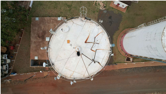
Foto 1 - Detalhe do topo do reservatório com tampa de inspeção em bom estado.
