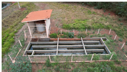
Foto 5 - Detalhe da etapa final de tratamento do efluente.
