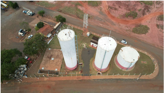
Foto 2 - Vista aérea posterior dos reservatórios.
