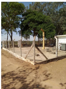
Foto 1 - Cercamento da área
