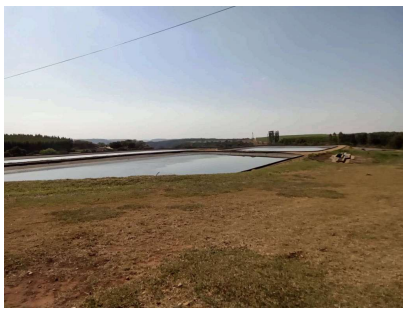
Foto 1 - Lagoas anaeróbicas no início do tratamento.
