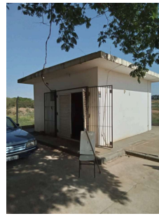
Foto 4 - Abrigo do gerador.
