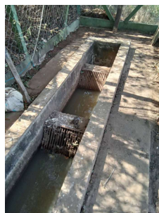
Foto 3 - Canaleta e gradeamento grosso
