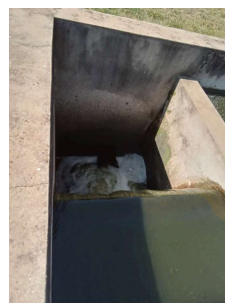
Foto 8 - Lançamento de efluentes após as chicanas.
