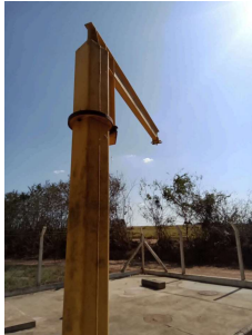
Foto 5 - Estrutura para manutenção do poço de sucção.
