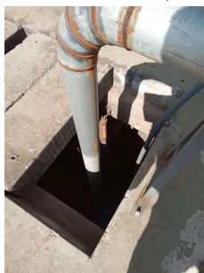
Foto 3 - Poço de sucção.
