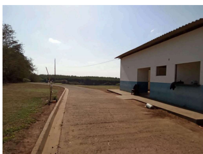
Foto 1 - Via de acesso à área da ETE, inteiramente cercada e com portão.
