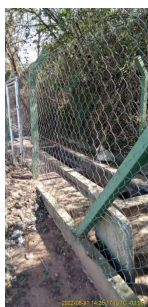
Foto 1 - Cercamento do gradeamento da elevatória.
