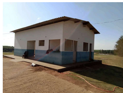
Foto 12 - Edificação com instalações para operador. Anteriormente havia laboratório, que foi desativado.
