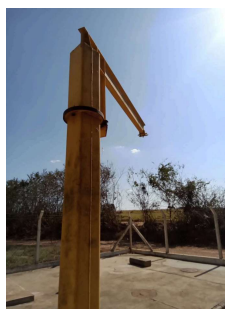
Foto 5 - Estrutura para manutenção do poço de sucção.
