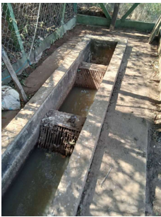
Foto 3 - Canaleta e gradeamento grosseiro
