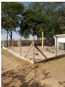
Foto 1 - Cercamento da área
