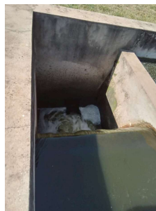
Foto 6 - Saída do efluente da chicana.
