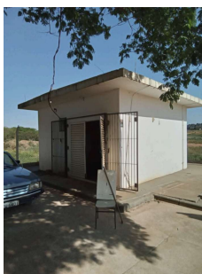
Foto 4 - Abrigo do gerador.
