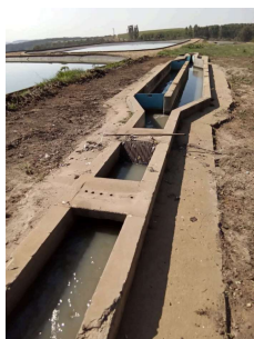
Foto 13 - Gradeamento grosseiro na entrada do efluente na ETE
