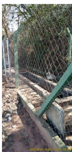
Foto 1 - Cercamento do gradeamento da elevatória.
