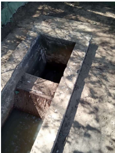
Foto 5 - Gradeamento grosseiro à montante da ETE.
