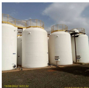
Foto 5 - UASB e biofiltro da ETE Pacaembu
