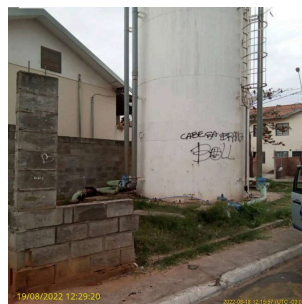
Foto 2 - Vista externa do Reservatório Res. Arn. Mazon
