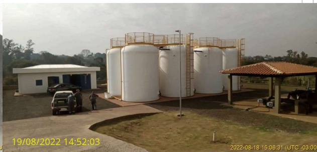
Foto 10 - Vista interna da ETE Pacaembu
