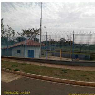
Foto 1 - Vista externa da EEE Jardim Apolo
