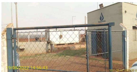
Foto 1 - Portão de acesso da EEE Orquídea
