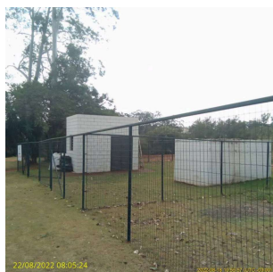
Foto 3 - Vista externa da EEE Residencial Lagoa
