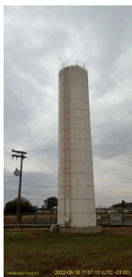
Foto 1 - Vista do Reservatório Distrito Industrial
