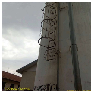
Foto 4 - Escada do Reservatório Res. Arn. Mazon
