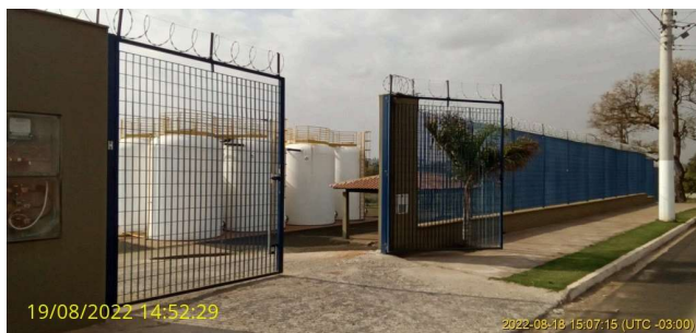
Foto 1 - Vista externa da ETE Pacaembu
