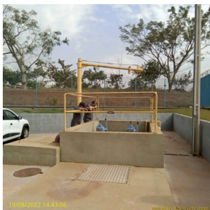
Foto 3 - Vista interna EEE Jardim Apolo
