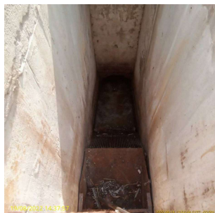
Foto 1 - Gradeamento da EEE Zona Norte
