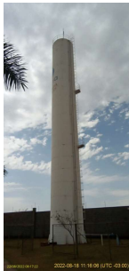
Foto 1 - Vista do Reservatório Residencial Lagoa
