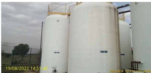
Foto 6 - Guarda-corpo dos reatores da ETE Pacaembu
