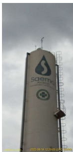
Foto 5 - Para-raio e guarda-corpo do Reservatório Res. Arn. Mazon
