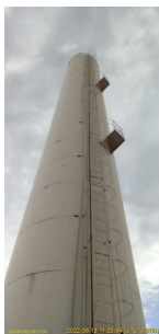
Foto 3 - Escadas e guarda-corpo do Reservatório Residencial Lagoa
