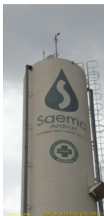
Foto 1 - Vista dos guarda-corpos do Reservatório Residencial Arnaldo Mazon
