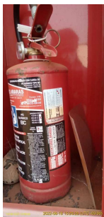
Foto 1 - Extintor de incêndio da ETE Orquídea
