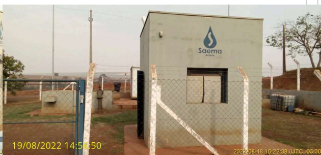
Foto 2 - Vista externa da EEE Orquídea
