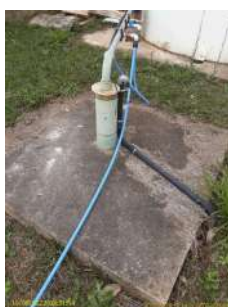
Foto 1 - Laje de proteção do Poço 29
