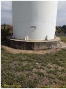
Foto 1 - Estado de conservação e limpeza da área do Reservatório Terras do Francês
