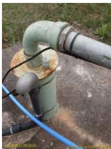
Foto 1 - Tubo de medição de nível ao centro (tubo de menor diâmetro no disco)
