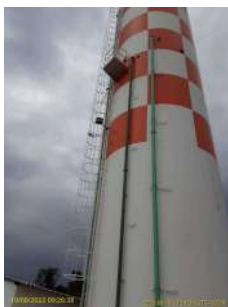
Foto 1 - Escada com guarda-corpos no Reservatório Jatobá
