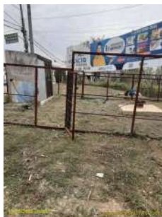
Foto 1 - Aspecto geral do Poço 21
