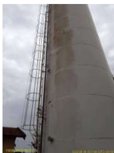
Foto 1 - Escada com guarda-corpos do Reservatório Moinho Novo
