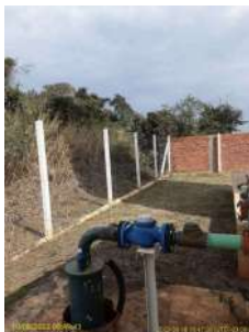
Foto 1 - Cercamento da área do Poço 30 - Jatobá
