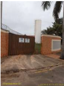
Foto 1 - Entrada do local da captação subterrânea Moinho Novo (Poço 29)
