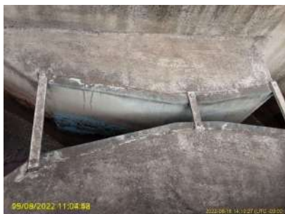
Foto 5 - Calha Parshall na chegada do esgoto bruto.
