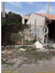
Foto 1 - Aspecto geral da situação da Estação Elevatória de Esgoto Camilo de Arruda
