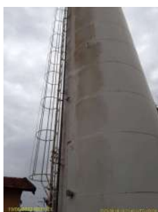
Foto 1 - Detalhe do medidor de nível do reservatório.
