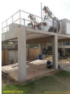
Foto 1 - Vista geral da ETE Terra Nova.
