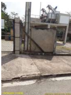
Foto 1 - Detalhe do cercamento da ETE.
