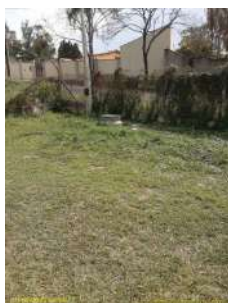
Foto 1 - Visão geral da localização da Estação Elevatória de Esgoto Altos do Tietê (EEE 11)
