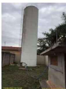
Foto 1 - Visão geral do Reservatório R27 Moinho Novo
