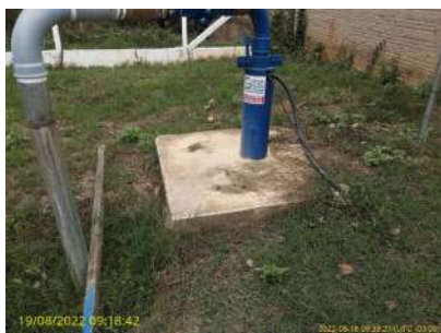
Foto 1 - Laje de proteção do Poço 32
