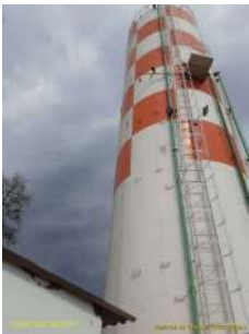
Foto 1 - Medidor de nível do Reservatório Jatobá (à esquerda no reservatório)
