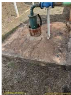
Foto 1 - Laje de Proteção do Poço 30 - Jatobá
