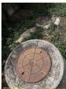
Foto 1 - Acesso para manutenção da Estação Elevatória de Esgoto Altos do Tietê (EEE 11)
