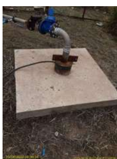
Foto 1 - Laje de proteção do Poço 21
