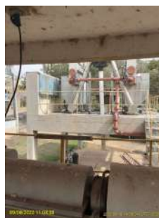
Foto 2 - Vista do primeiro piso da ETE.
