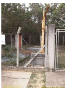
Foto 1 - Vista geral da EEE.
