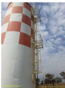
Foto 1 - Escada com guarda-corpos no Reservatório Terras do Francês
