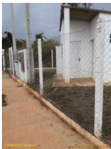
Foto 1 - Cercamento da área do Reservatório Jatobá
