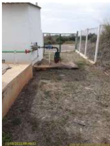
Foto 1 - Aspecto geral do Poço 30 - Jatobá
