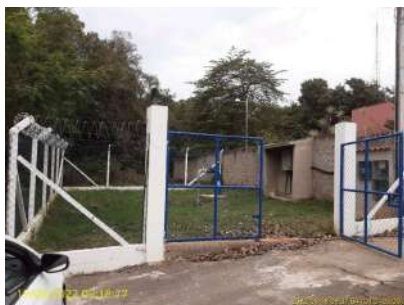
Foto 1 - Detalhes de cercamento do Poço 32
