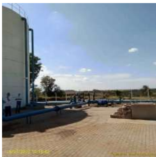
Foto 3 - Vista interna do centro de produção e reservatório Chácara Flora
