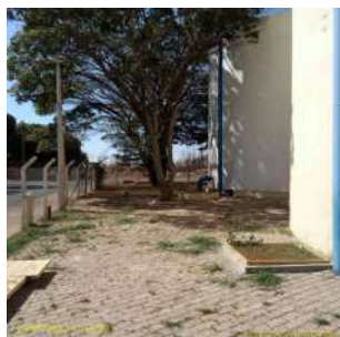
Foto 1 - Vista interna do reservatório R27
