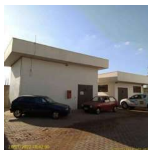
Foto 2 - Cabine do painel elétrico do centro de produção e reservação Victorino de Santi II
