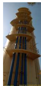
Foto 2 - Vista do reservatório R18
