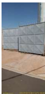
Foto 1 - Portão de acesso ao reservatório Monte Carlo
