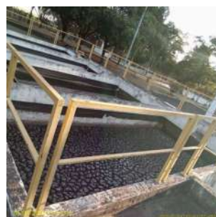
Foto 2 - Leito de secagem de lodo
