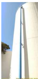
Foto 1 - Tubo extravasor do reservatório R27
