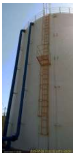
Foto 1 - Escadas do reservatório São Rafael
