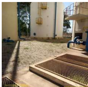
Foto 1 - Vista interna da área do reservatório r18
