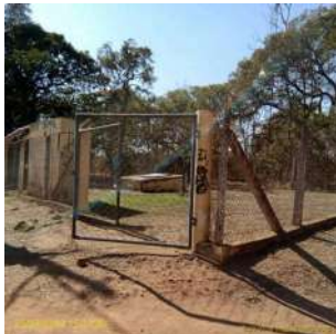
Foto 1 - Portão de acesso
