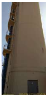
Foto 1 - Vista frontal do reservatório R18
