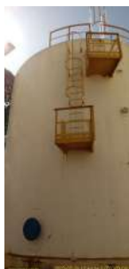
Foto 1 - Vista frontal do reservatório R30
