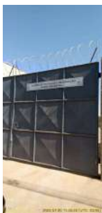
Foto 1 - Portão de acesso ao reservatório
