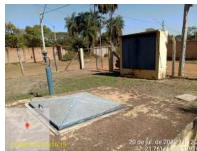
Foto 4 - Vista interna da EEAT Zavanela
