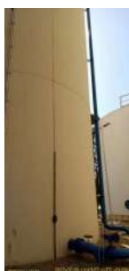
Foto 3 - Vista frontal do reservatório R27
