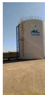
Foto 2 - Vista frontal do reservatório São Rafael
