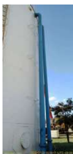
Foto 1 - Tubo extravasor do reservatório Victorio de Santi II
