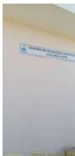
Foto 1 - Placa de identificação do centro de produção e reservatório Chácara Flora
