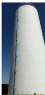
Foto 3 - Reservatório Monte Carlo
