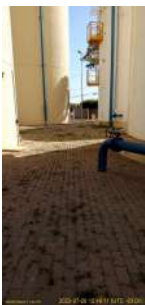
Foto 1 - Vista interna do centro de produção e resevação Selmi Dei
