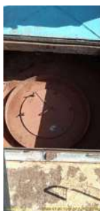
Foto 3 - Tampa de inspeção
