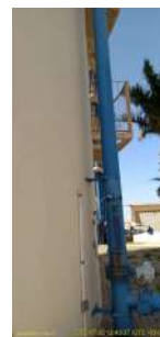
Foto 2 - Vista frontal do reservatório R27
