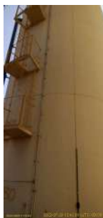
Foto 1 - Vista frontal do reservatório R27
