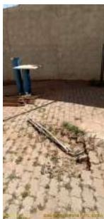
Foto 1 - Vista interna do local do Poço Selmi Dei II
