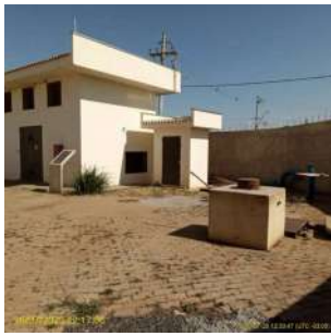
Foto 1 - Vista interna da área do Poço selmi dei II
