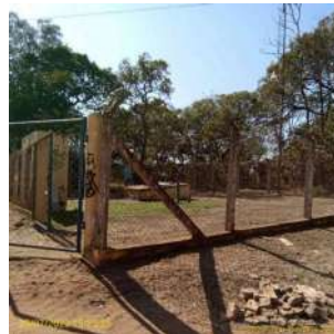
Foto 2 - Vista externa da EEAT Zavanela
