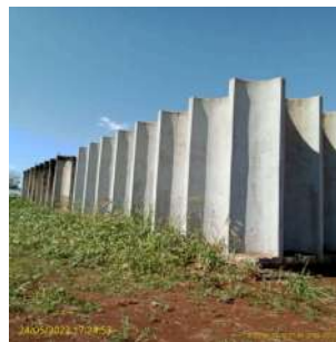
Foto 2 - Reservatório apoiado Avelino Palma II (Capacidade 2000m3)
