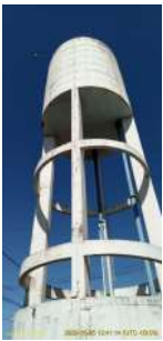
Foto 1 - Reservatório elevado Distrito Industrial (capacidade 200 m3)
