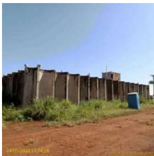
Foto 1 - Reservatório Avelino Palma II (desativado)
