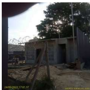
Foto 1 - Construção da casa de dosagem de cloro e flúor, separadas
