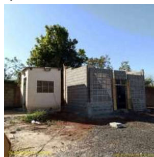
Foto 6 - Obras em andamento
