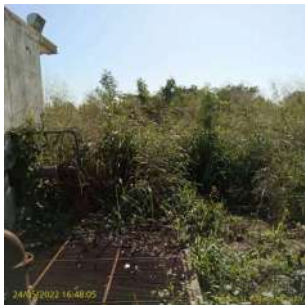
Foto 2 - Vista externa do poço de sucção
