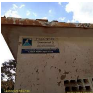
Foto 4 - Placa de identificação ( Poço Bananal II tamponado)
