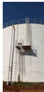
Foto 2 - Escada de acesso e guarda-corpo do reservatório
