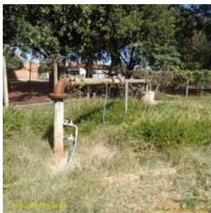
Foto 1 - Vista externa do poço
