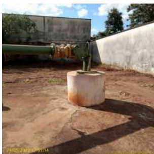
Foto 3 - Laje de cobertura do poço
