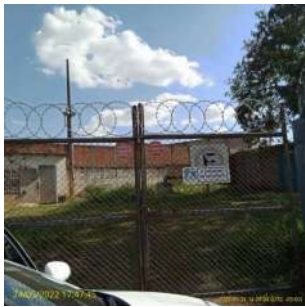
Foto 1 - Portão de acesso
