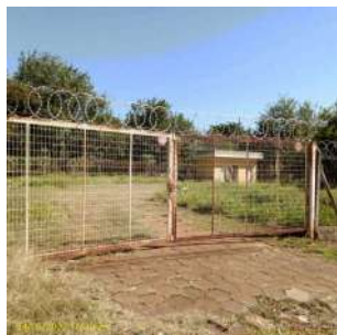
Foto 1 - Portão de acesso ao poço
