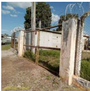
Foto 1 - Portão de acesso à captação
