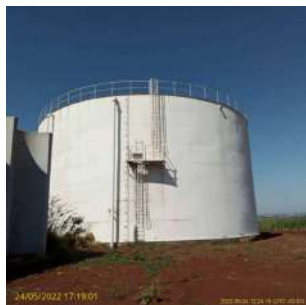
Foto 1 - Reservatório apoiado Avelino Palma II (Capacidade 50003)
