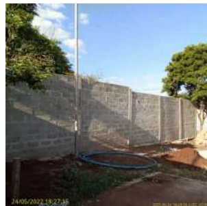
Foto 2 - Construção do muro
