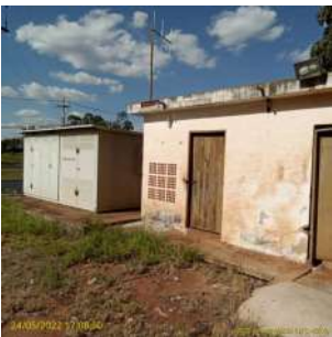
Foto 2 - Casa de armazenamento e dosagem de cloro e flúor
