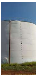
Foto 3 - Medição de nível do reservatório
