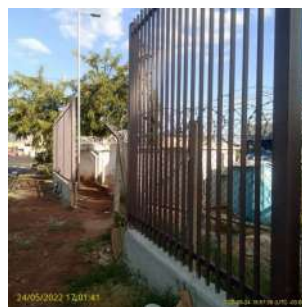
Foto 2 - Construção do alambrado
