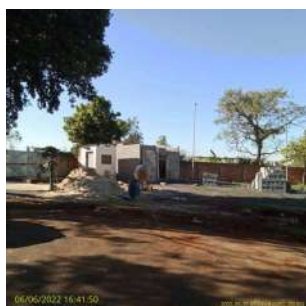
Foto 1 - Vista externa do local
