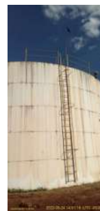
Foto 2 - Vista frontal do guarda-corpo e escada de acesso ao reservatório
