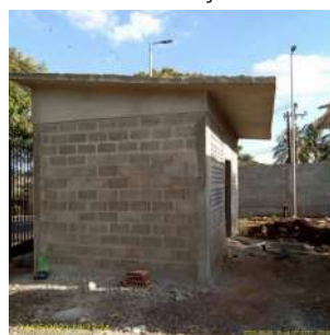
Foto 3 - Construção da casa de dosagem de cloro e flúor, separadas
