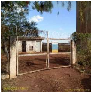
Foto 3 - Portão de acesso ao reservatório
