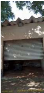
Foto 1 - Casa de bombas da estação elevatória Flamboyans
