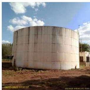
Foto 1 - Reservatório apoiado Flamboyans (capacidade 1000m3)
