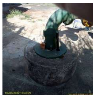
Foto 2 - Tubo de medição de nível
