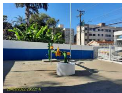
Foto 10 - Cavalete do poço Arnaldo Victaliano
