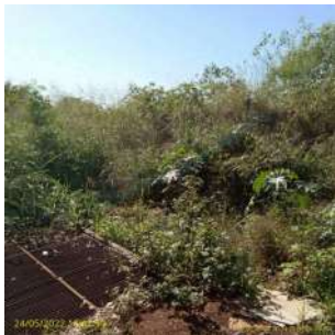
Foto 1 - Vista externa do poço de sucção
