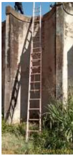
Foto 2 - Escada portátil para acesso ao reservatório
