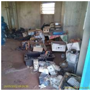
Foto 1 - Depósito de materiais no interior da elevatória de água tratada
