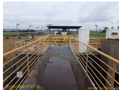
Foto 12 - Vista geral da ETA.
