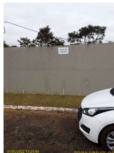
Foto 8 - Caixa de contato.
