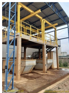
Foto 4 - Vista da estrutura de secagem e armazenamento do lodo.
