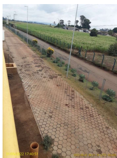
Foto 1 - Detalhe do cercamento da ETA.
