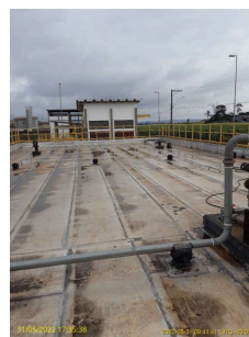
Foto 4 - Vista do reservatório junto à ETA, no qual se faz a dosagem de flúor e cloro.
