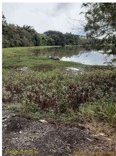
Foto 1 - Vista geral da represa do Barro Preto.
