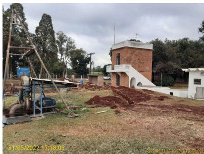
Foto 1 - Vista geral do local, que passa por obras para a implantação de macromedidor (informações do Prestador de Serviços).
