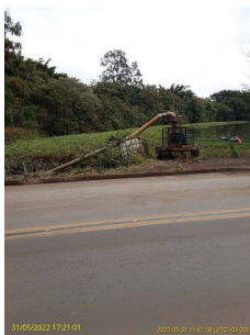
Foto 1 - Local sem cercamento e próximo à beira da rodovia.
