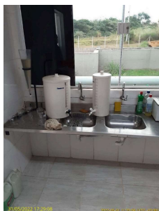
Foto 1 - Detalhe 1 das condições do laboratório da ETE.
