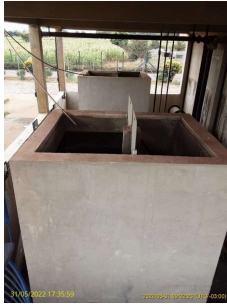
Foto 7 - Tanque de nivelamento.
