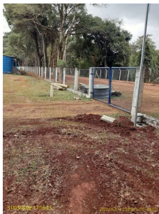
Foto 1 - Detalhe do cercamento ao longo da extensão da represa.
