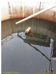
Foto 1 - Água usada na retrolavagem.
