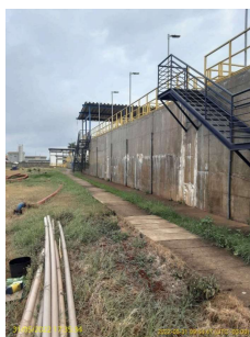
Foto 3 - Vista lateral da ETA.
