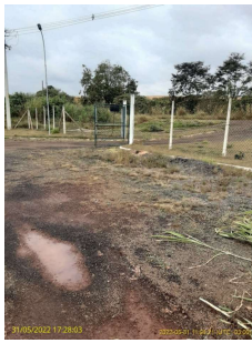
Foto 1 - Detalhe do cercamento da ETE.
