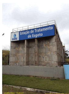
Foto 14 - Vista da estrutura de tratamento.
