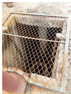
Foto 12 - Gradeamento na chegada do esgoto bruto.
