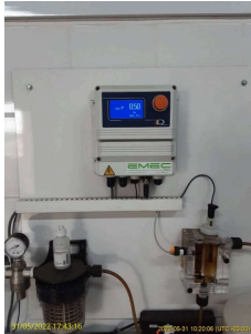
Foto 3 - Detalhe do monitor de visualização do flúor.
