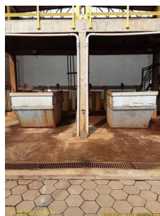
Foto 6 - Caçambas para depósito do lodo após secagem.
