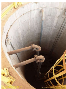
Foto 3 - Bombeamento do lodo para a estrutura de secagem e armazenamento.
