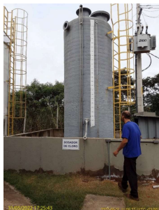
Foto 7 - Tanque de cloro e dosador.
