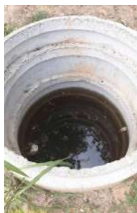
Foto 3 - Novo poço de sucção (em construção)
