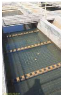
Foto 11 - Decantador lamelar
