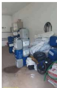
Foto 1 - Detalhe do empilhamento de embalagens vazias no interior da elevatória
