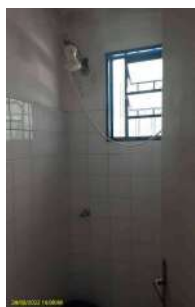
Foto 1 - Chuveiro disponível no banheiro da ETA
