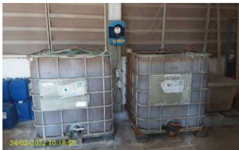
Foto 1 - Bombonas de flúor para aplicação na água
