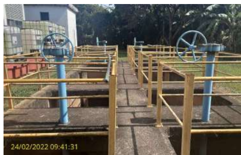
Foto 2 - Aspecto geral dos canais de entrada da água
