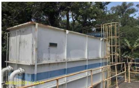
Foto 8 - Escada de acesso e guarda corpo na ETA e no tanque de contato
