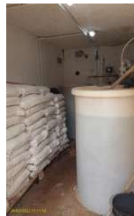
Foto 3 - Estoque de barrilha e sulfato de alumínio
