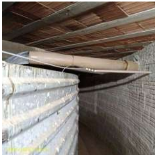
Foto 2 - Detalhe da aplicação de cloro no reservatório Horta semienterrado.
