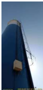
Foto 1 - Escada e guarda-corpo.
