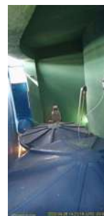
Foto 2 - Abrigo para armazenamento dos produtos químicos.
