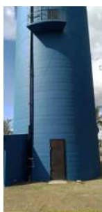
Foto 1 - Reservatório elevado e acesso para manutenção. Observa-se também abrigo para armazenamento de produtos químicos.
