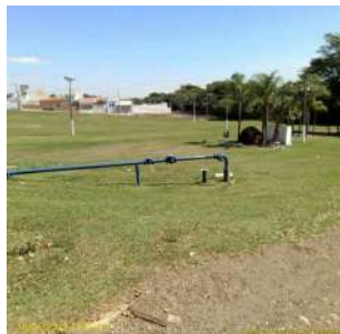
Foto 1 - Visão geral do poço horta.
