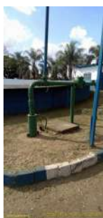
Foto 1 - Visão geral do poço.
