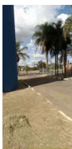
Foto 1 - Cercamento e portão de acesso ao complexo que contém o reservatório elevado,
