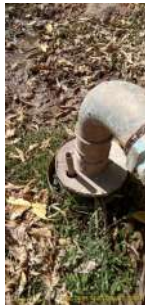
Foto 1 - Tubo para medição do nível do poço.
