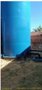
Foto 1 - Local sem obstruções a manutenção do reservatório.
