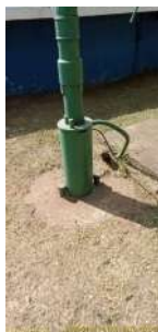
Foto 1 - Laje de proteção do poço.
