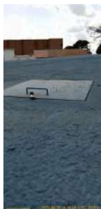
Foto 1 - Tampa de inspeção do reservatório.
