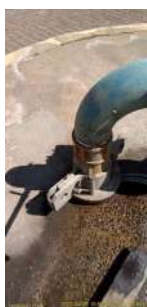
Foto 1 - Tubo para medição do nível do poço.
