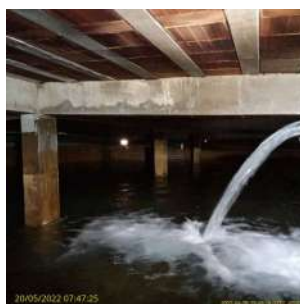
Foto 2 - Vista interna do reservatório
