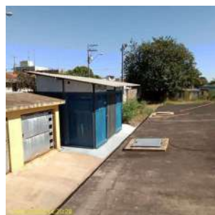
Foto 3 - Abrigo de produtos químicos ao lado do reservatório semienterrado, abastecido pelo poço
