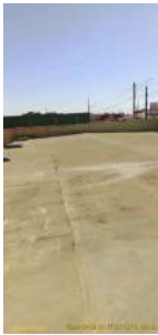
Foto 2 - Visão geral do reservatório
