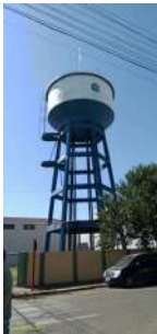
Foto 2 - Observa-se o medidor do nível ao lado do trecho da escada mais elevado
