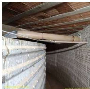
Foto 3 - Aplicação de produto químico diretamente no reservatório.
