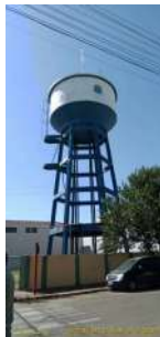
Foto 1 - Vista do reservatório.
