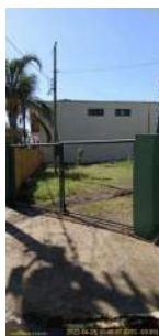
Foto 1 - Cercamento e portão de acesso no local.
