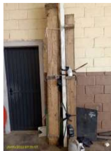
Foto 2 - Bombas reservas no almoxarifado.
