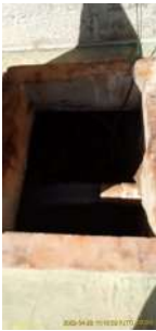
Foto 1 - Entrada de água no reservatório
