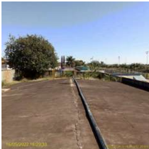
Foto 2 - Vista da laje de cobertura do reservatório
