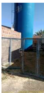
Foto 1 - Cercamento da área do reservatório.
