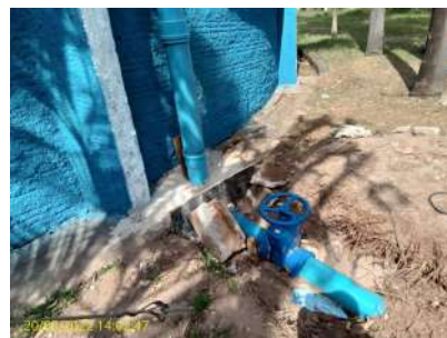
Foto 4 - Tubulação e registro de entrada de água no reservatório.
