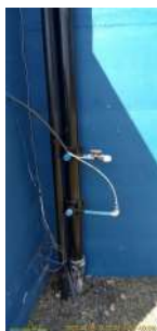
Foto 1 - Aplicação de flúor e cloro no reservatório, na entrada.
