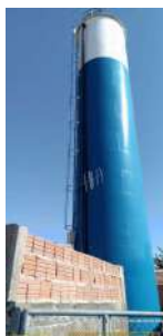
Foto 1 - O nível é medido por sensor eletrônico e transmitido por sinal de rádio. Na foto, pode-se ver a antena de transmissão.
