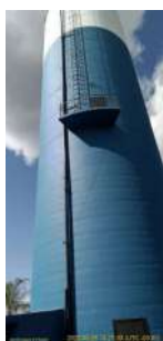
Foto 1 - Medidor tipo pêndulo; sem funcionamento, segundo o prestador.
