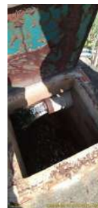
Foto 3 - Entrada de água no reservatório
