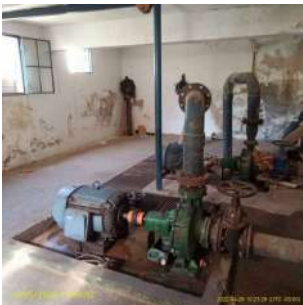
Foto 1 - Visão geral da construção.
