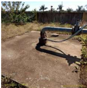
Foto 1 - Laje de de proteção do poço.
