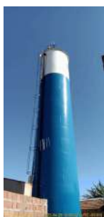
Foto 1 - Vista do reservatório.
