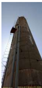
Foto 3 - Reservatório antigo de concreto, ainda em operação.
