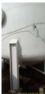
Foto 3 - Detalhe da aplicação de produto químico e tomada para coleta de água floculada para análise.
