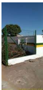
Foto 1 - Vista externa do Reservatório semi enterrado.
