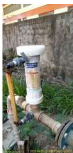
Foto 1 - Cloração realizada no poço.
