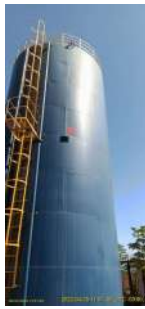
Foto 1 - Medidor de nível instalado no reservatório novo
