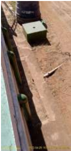
Foto 1 - Tubos extravasores do reservatório
