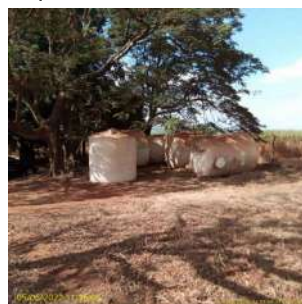
Foto 4 - Tanques adquiridos pelo prestador para futuro armazenamento de hipoclorito de sódio
