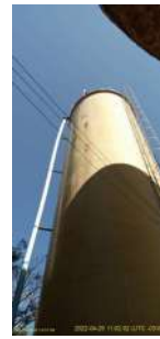
Foto 2 - Medidor de nível instalado no reservatório antigo.
