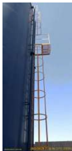
Foto 1 - Escada e guarda-corpo do reservatório novo
