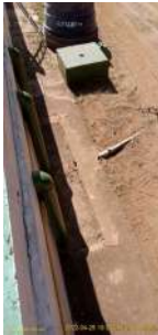
Foto 2 - Tubos extravasores do reservatório
