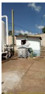
Foto 1 - O local é protegido por muros
