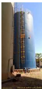
Foto 1 - Aos fundos, reservatório novo instalado no local.
