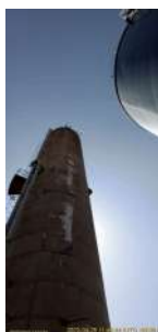
Foto 1 - Foi instalado pára-raio no reservatório antigo.
