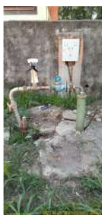
Foto 1 - Vista geral do poço
