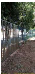
Foto 1 - Cercamento da área.
