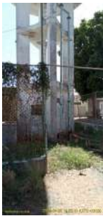
Foto 2 - Vista do local de acesso.
