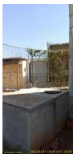
Foto 1 - Cercamento da área
