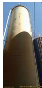
Foto 2 - Reservatório existente, já fiscalizado anteriormente.
