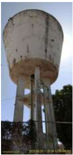
Foto 1 - Vista geral do reservatório elevado
