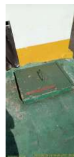
Foto 2 - Tampa de acesso para inspeção.
