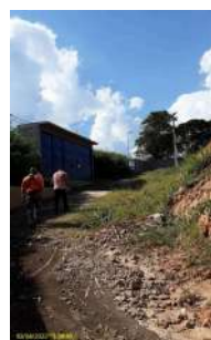
Foto 2 - Via parcialmente improvisada, com pedregulhos e terra, para acesso do caminhão
