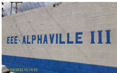
Foto 1 - Identificação da elevatória de esgoto
