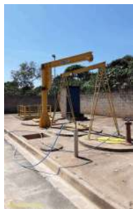
Foto 3 - Aspecto geral da elevatória (interno)
