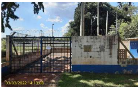
Foto 1 - Aspecto geral da elevatória (externo)
