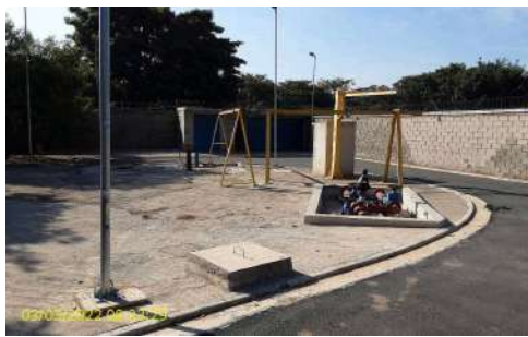
Foto 1 - Aspecto geral da elevatória de esgoto
