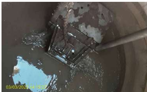
Foto 7 - Segundo cesto de retenção dos sólidos grosseiros
