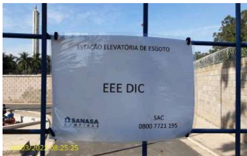
Foto 1 - Placa de identificação da elevatória
