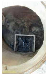
Foto 2 - Gradeamento de retenção de sólidos grosseiros
