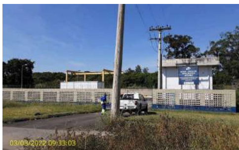
Foto 1 - Aspecto externo da elevatória de esgoto
