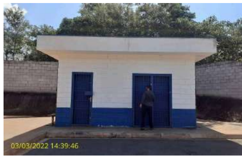
Foto 2 - Casa de painéis elétricos e gerador
