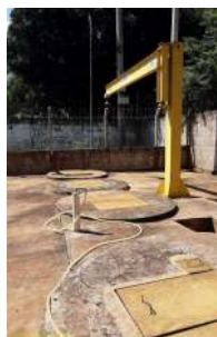
Foto 3 - Aspecto geral da elevatória (interno)
