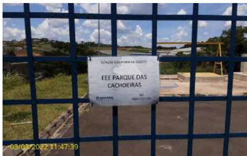
Foto 1 - Placa de identificação da elevatória
