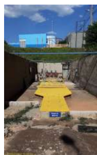
Foto 4 - Aspecto geral da elevatória
