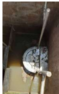
Foto 10 - Primeiro cesto de retenção de sólidos grosseiros
