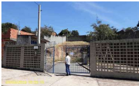
Foto 8 - Aspecto geral da elevatória (externo)
