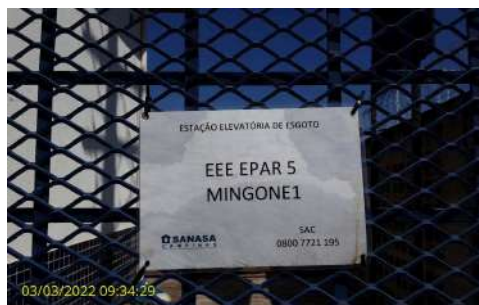
Foto 2 - Placa de identificação da elevatória
