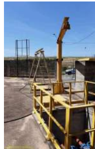
Foto 5 - Aspecto geral da elevatória (interno)
