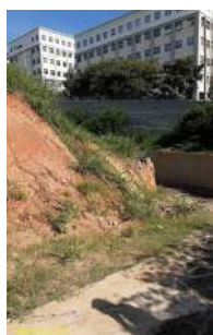
Foto 1 - Espaçamento estreito para as manobras do caminhão
