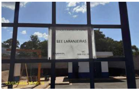
Foto 1 - Placa de identificação da elevatória de esgoto
