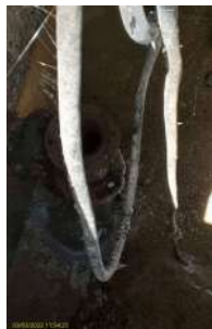
Foto 9 - Poço de sucção do efluente
