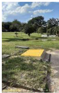
Foto 1 - Tampa de acesso ao barrilete
