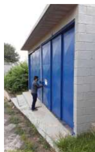
Foto 2 - Cabine dos painéis elétricos
