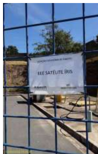
Foto 1 - Placa de identificação da elevatória de esgoto
