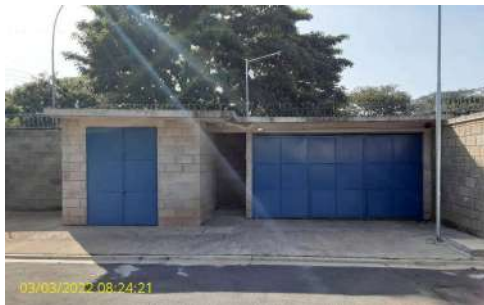
Foto 3 - Cabine do painel de controle e acionamento dos conjuntos motobomba
