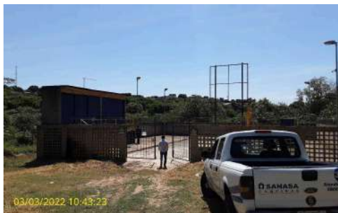
Foto 1 - Aspecto geral da elevatória (externo)
