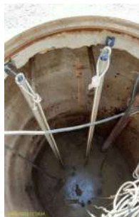
Foto 5 - Poço de sucção da elevatória de esgoto
