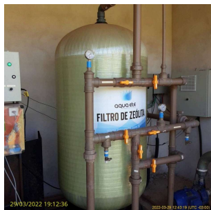
Foto 1 - Detalhe do filtro de zeólita
