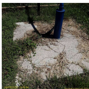
Foto 1 - Detalhe da laje de proteção
