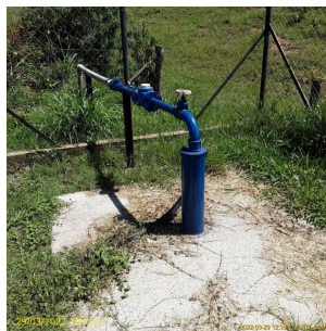
Foto 2 - Vista geral do poço
