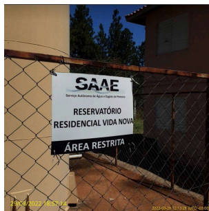
Foto 1 - Detalhe da identificação do reservatório
