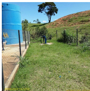
Foto 4 - Vista geral do poço
