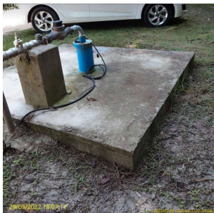
Foto 1 - Detalhe da laje de proteção
