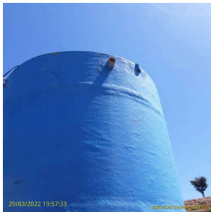
Foto 1 - Detalhe da ausência de rede na tubulação de ventilação.
