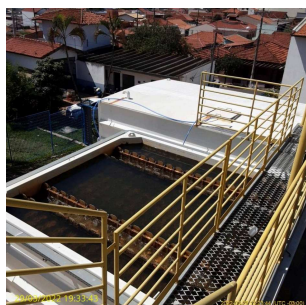
Foto 5 - Vista dos vertedores na ETA
