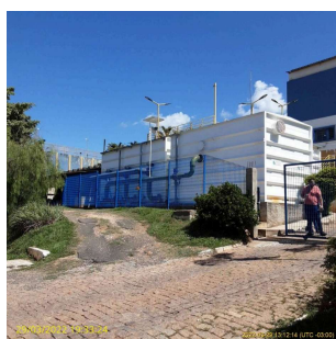
Foto 1 - Vista geral da ETA Compacta
