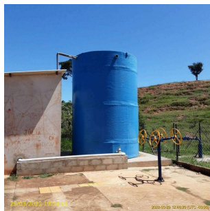
Foto 1 - Vista geral do reservatório
