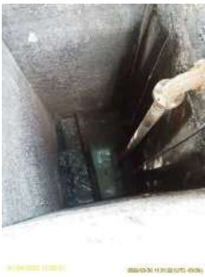
Foto 2 - Poço de sucção da elevatória
