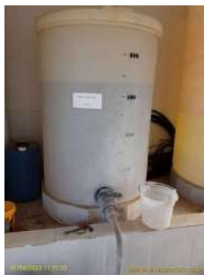
Foto 1 - Tanque de produto utilizado para fluoretação na unidade de desinfecção.
