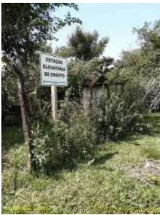
Foto 1 - Identificação da elevatória.
