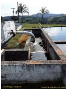
Foto 4 - Saída da filtração e encaminhamento à desinfecção.
