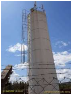
Foto 1 - Escada com guarda-corpo no reservatório.
