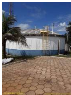
Foto 1 - Reservatório circular situado junto à ETA.
