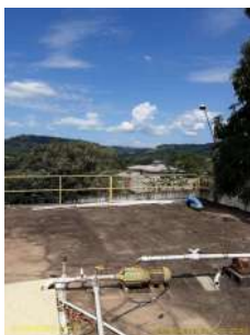
Foto 1 - Guarda-corpo na cobertura do reservatório.
