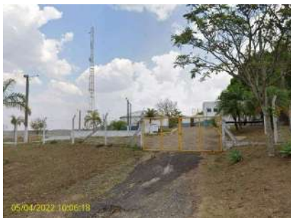
Foto 1 - Antena com pára-raio existente no terreno da ETA, e dos reservatórios.
