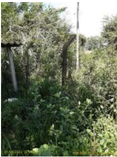
Foto 1 - Cercamento da elevatória.
