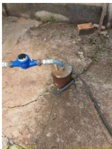
Foto 1 - Laje de proteção de concreto.
