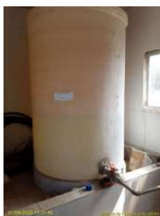
Foto 1 - Tanque para armazenamento de produto utilizado para a cloração
