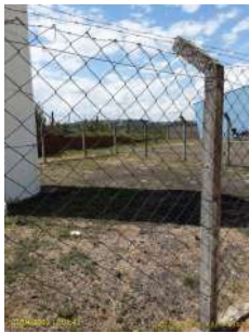
Foto 1 - Cercamento da área
