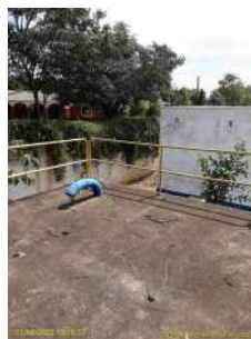
Foto 2 - Guarda-corpo na cobertura do reservatório.
