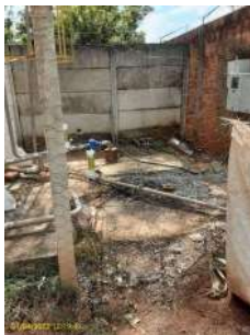
Foto 1 - Cercamento da área.
