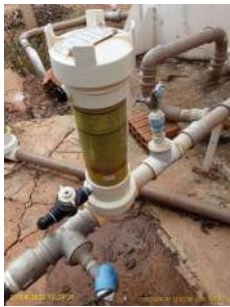
Foto 1 - Cloração da água captada através de pastilhas.
