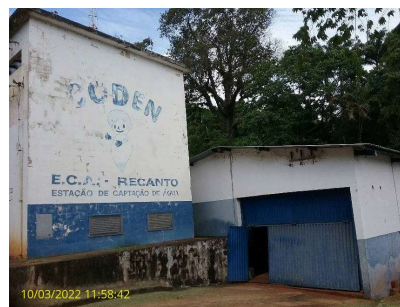
Foto 2 - Casa de bombas da captação Recanto
