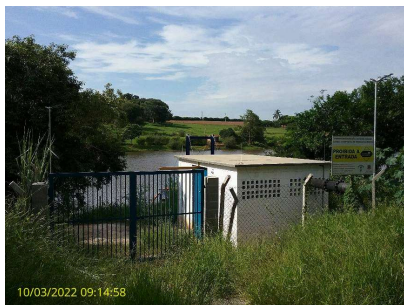
Foto 1 - Vista externa da captação Córrego Palmital
