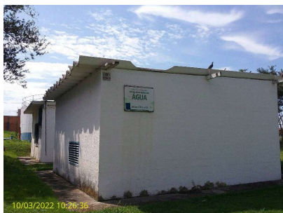
Foto 3 - Vista externa da EEAT Terra Nova, EEAT São Francisco e Reservatório Santa Luzia
