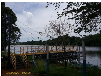
Foto 1 - Barramento Córrego Recanto
