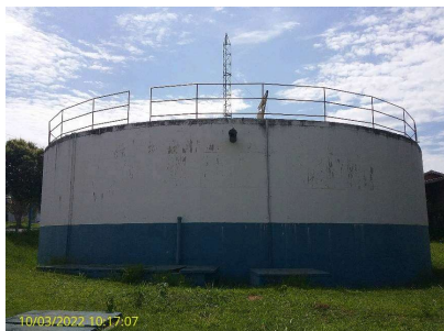
Foto 1 - Reservatório Jardim Santa Luzia
