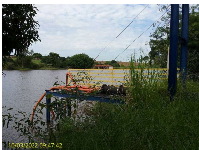
Foto 6 - Tomada de água
