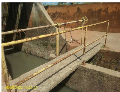
Foto 1 - Guarda-corpo danificados
