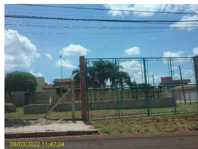
Foto 28 - Unidade de tratamento de lodo
