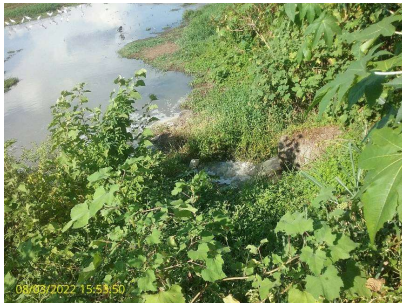
Foto 3 - Detalhe da entrada de esgoto bruto
