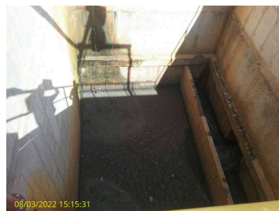
Foto 20 - Poço de esgoto bruto
