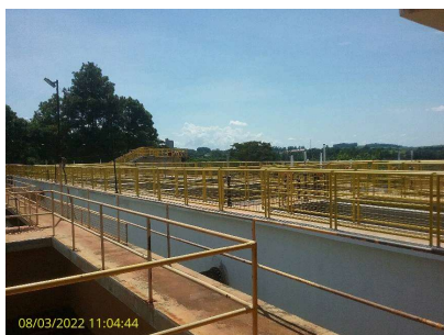
Foto 9 - Vista geral das unidades
