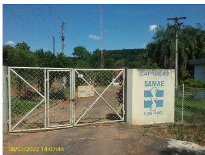
Foto 9 - Entrada da Captação
