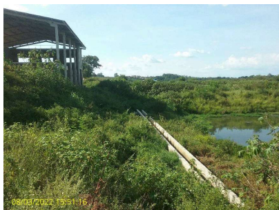
Foto 1 - Vista geral da ETE
