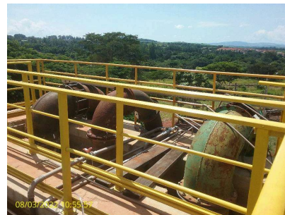
Foto 4 - Adutoras de esgoto bruto
