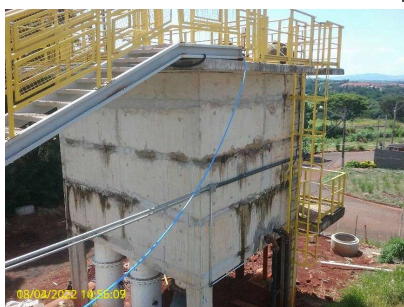
Foto 3 - Nova estrutura de entrada
