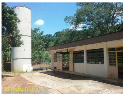
Foto 1 - Vista geral da unidade
