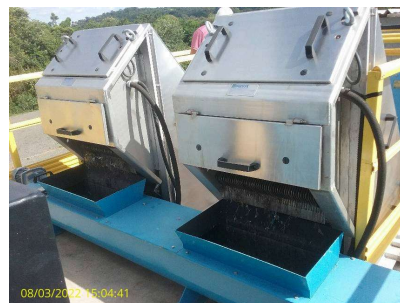
Foto 14 - Gradeamento fino (ampliação)
