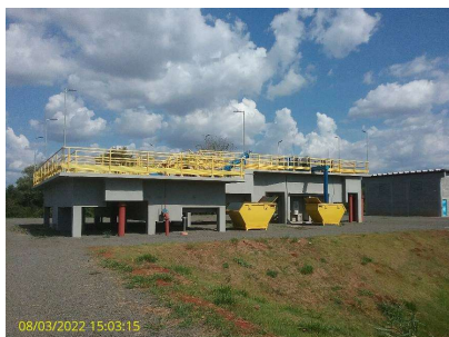
Foto 13 - Vista geral da ampliação
