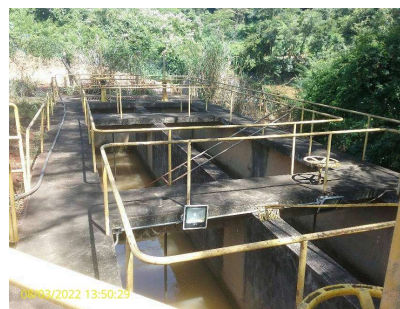
Foto 2 - Canal de entrada de água bruta
