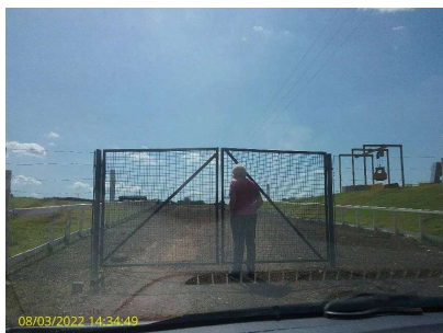
Foto 3 - Entrada Ampliação da ETE
