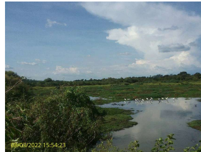
Foto 4 - Detalhe da lagoa facultativa
