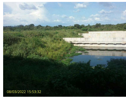
Foto 2 - Lagoas em construção
