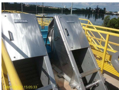
Foto 15 - Gradeamento fino (ampliação)
