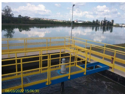
Foto 17 - Desarenador (ampliação)
