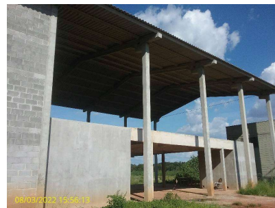
Foto 6 - Galpão de tratamento de lodo
