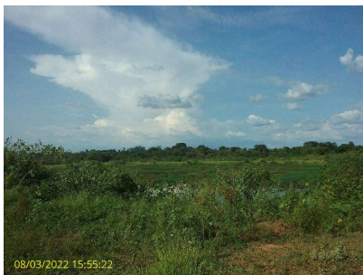
Foto 5 - Vista geral da ETE
