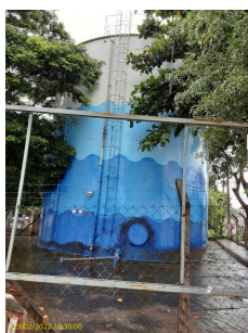
Foto 1 - Cercamento da área.
