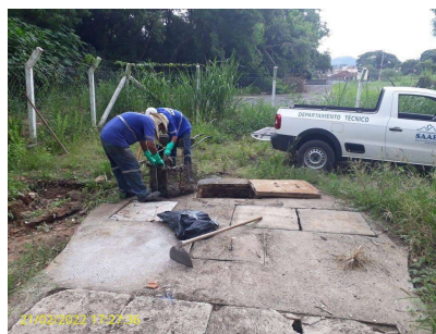
Foto 2 - Limpeza no gradeamento.
