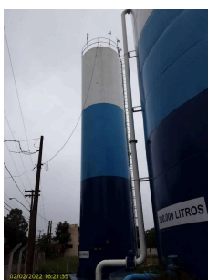
Foto 1 - Escada com guarda-corpo.
