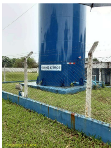
Foto 1 - Cercamento da área.
