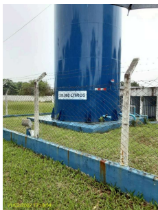
Foto 1 - Cercamento da área.
