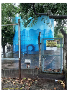
Foto 1 - Identificação do reservatório.
