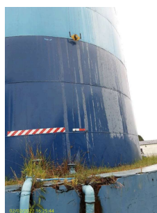
Foto 2 - Medidor de nível no reservatório I.
