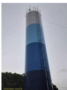
Foto 1 - Para-raio no reservatório.
