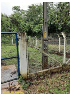
Foto 1 - Cercamento da área da elevatória.
