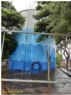
Foto 1 - Escada com guarda-corpo.
