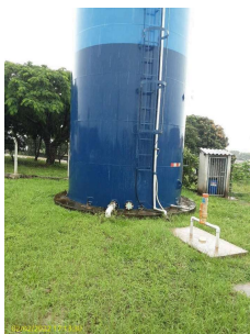
Foto 1 - Visao geral do reservatório, situado junto ao poço de mesmo nome.
