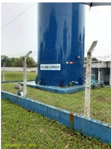
Foto 2 - Reservatório Alpes das águas II, capacidade de 200m3.
