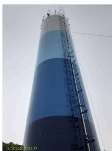
Foto 1 - Escada com guarda-corpo.
