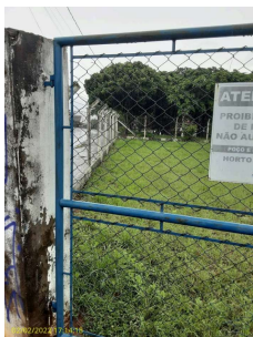
Foto 1 - Cercamento da área.
