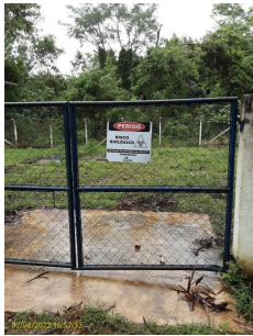
Foto 1 - Identificação da elevatória de esgoto.
