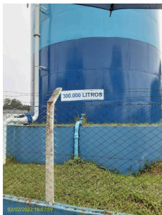
Foto 1 - Reservatório Alpes das águas I, capacidade de 300 m3
