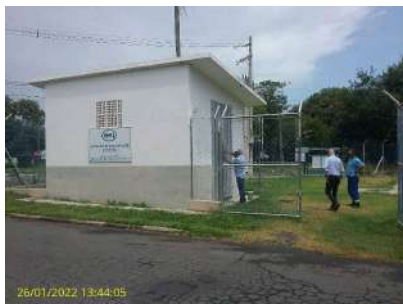
Foto 1 - Vista geral da área da EEEB
