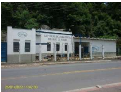
Foto 1 - Fachada da Estação de Captação
