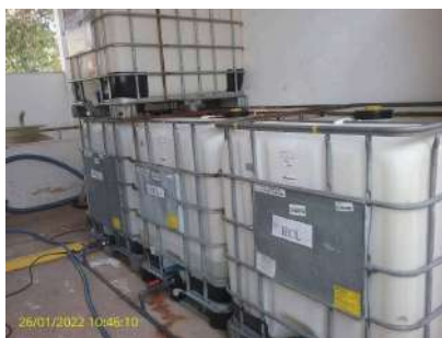
Foto 7 - Tanques de HCl
