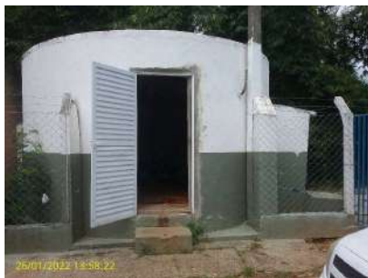
Foto 1 - Fachada da casa de bombas
