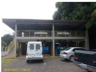
Foto 30 - Vista geral do prédio
