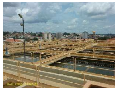
Foto 22 - Vista geral das unidades da ETA
