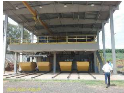
Foto 11 - Prédio de tratamento de lodo
