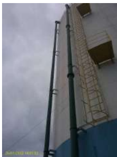
Foto 3 - Detalhe do extravasor
