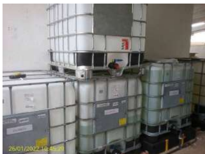
Foto 5 - Tanques de Cloreto
