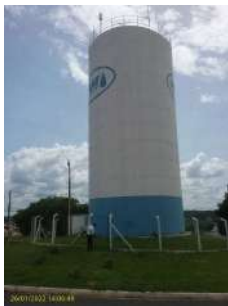
Foto 1 - Reservatório Vista geral do reservatório
