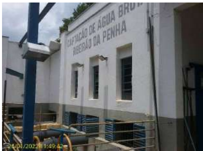
Foto 7 - Vista externa da casa de bombas
