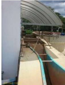
Foto 19 - Canal de entrada e mistura rápida
