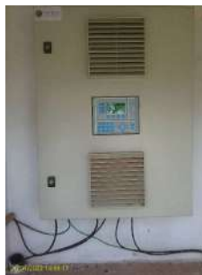
Foto 4 - Painele da telemetria
