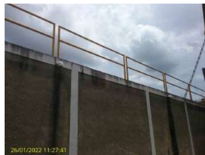
Foto 2 - Detalhe do guarda-corpo
