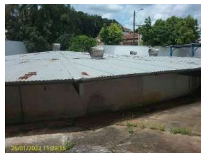
Foto 2 - vista lateral do reservatório
