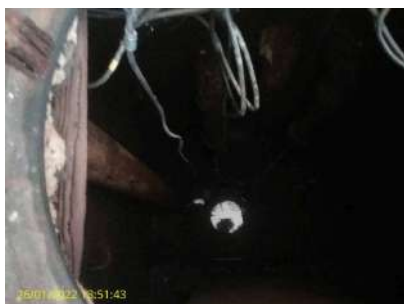
Foto 5 - Poço de sucção
