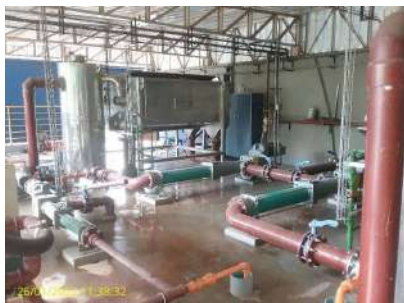
Foto 34 - vista geral das instalações do tratamento de lodo
