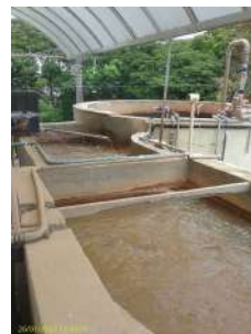
Foto 25 - Canal de entrada de água bruta
