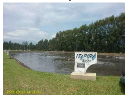
Foto 8 - Vista geral das lagoas aeradas 3
