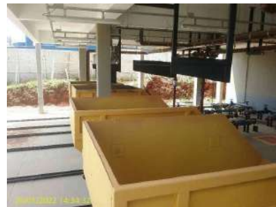
Foto 15 - Caçambas de resíduos (lodo seco)
