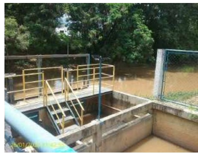
Foto 2 - Tomada de água
