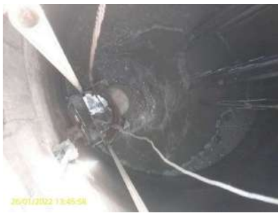
Foto 5 - Poço de sucção
