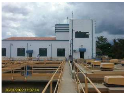
Foto 28 - Vista interna da ETA
