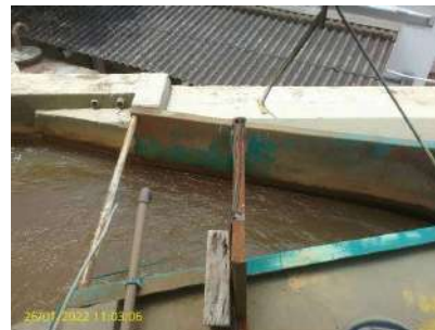
Foto 24 - Canal de entrada de água bruta
