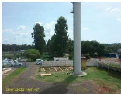
Foto 19 - Vista geral da entrada da ETE
