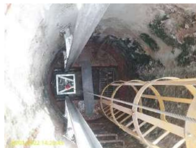
Foto 6 - Detalhe do PV gradeamento da EEEB
