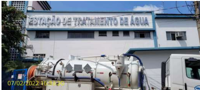
Foto 7 - Fachada da Casa de bombas
