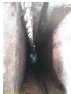
Foto 4 - Poço de gradeamento
