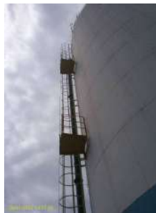
Foto 2 - Detalhe da Escada
