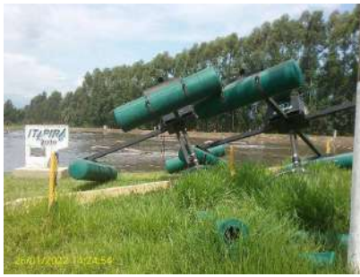
Foto 9 - Detalhe dos aeradores novos para substituição
