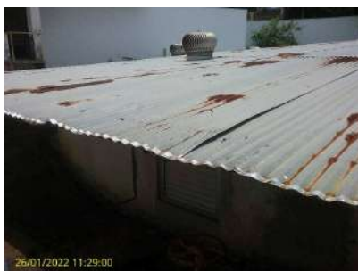
Foto 1 - Vista geral do reservatório semi-enterrado
