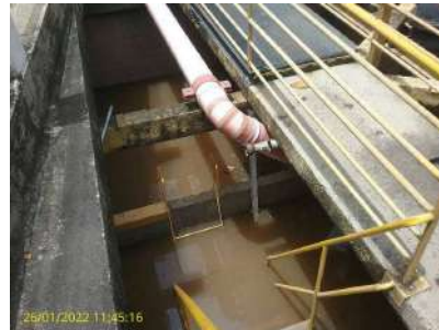
Foto 4 - Canal de entrada de água bruta
