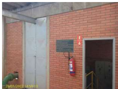
Foto 4 - Vista externa da casa de bombas
