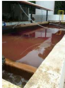
Foto 7 - Aplicação de permanganato
