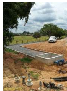
Foto 2 - Base para futura instalação do geobags
