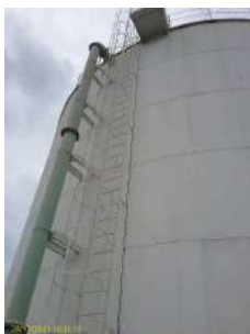
Foto 3 - Escada de acesso
