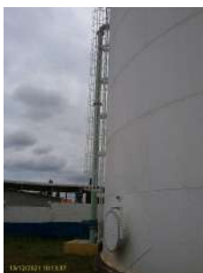
Foto 1 - Escada de acesso
