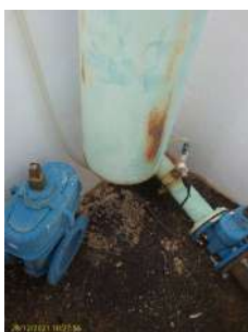
Foto 1 - Extravasor sem tela anti inseto
