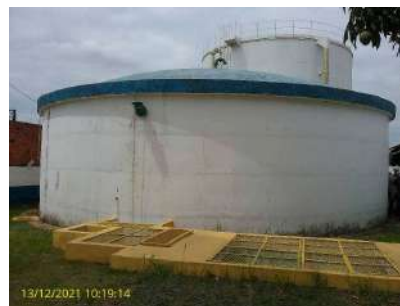
Foto 2 - Vista geral reservatório
