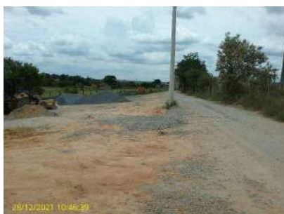
Foto 1 - Área sem restrição de acesso
