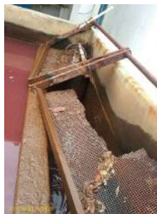
Foto 2 - Gradeamento danificado
