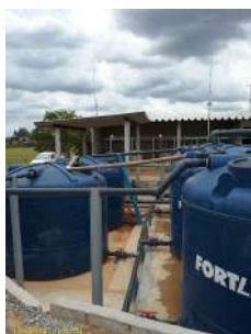
Foto 11 - Vista geral da unidade
