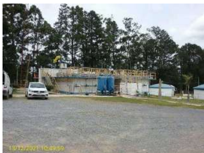
Foto 5 - Vista geral ETA
