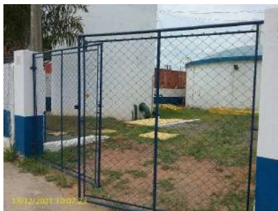
Foto 1 - Acesso ao reservatório
