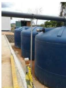
Foto 9 - Reservatórios de água tratada
