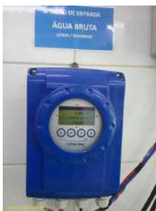
Foto 1 - Visor do macromedidor de entrada
