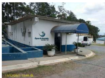
Foto 1 - Vista geral unidade
