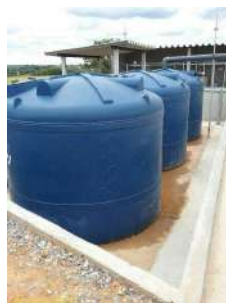
Foto 10 - Reservatórios de água tratada
