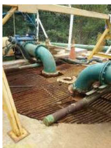
Foto 1 - Grades deterioradas
