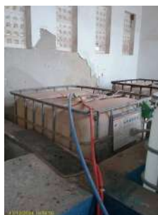
Foto 8 - Armazenagem ácido fluossilícico
