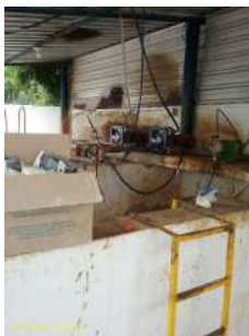
Foto 1 - Vista lateral da dosagem de produtos químicos
