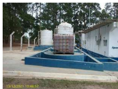
Foto 2 - Vista geral unidade
