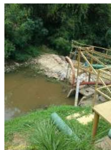
Foto 3 - Vista geral da tomada de água
