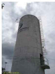
Foto 2 - Vista geral reservatório
