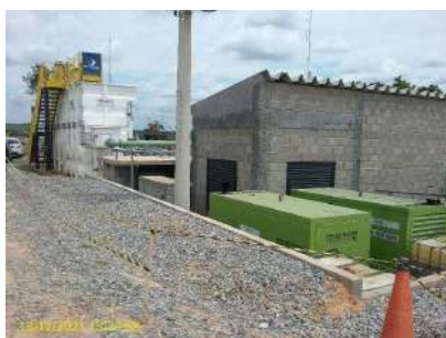
Foto 1 - Vista geral da unidade
