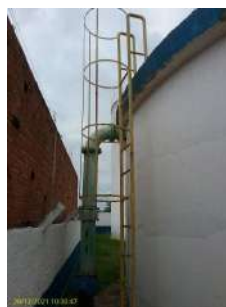
Foto 2 - Escada de acesso 2
