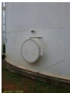
Foto 1 - Tampa de acesso
