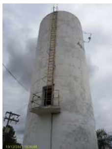
Foto 1 - Vista geral reservatório elevado
