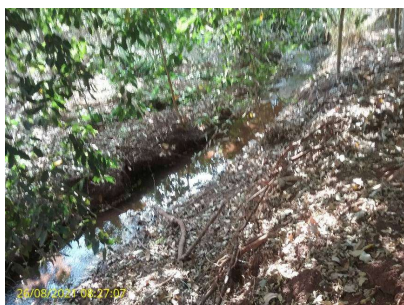
Foto 11 - Vista do córrego Piripau após extravassor da elevatória Piripau II
