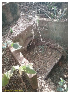
Foto 10 - Aspecto geral do extravassor da elevatória Palmeiras II
