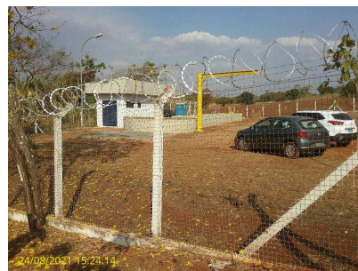
Foto 6 - Vista da área cercada
