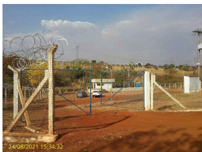
Foto 7 - Vista da chegada da elevatória Palmeiras II
