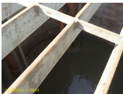
Foto 1 - Poço de sucção
