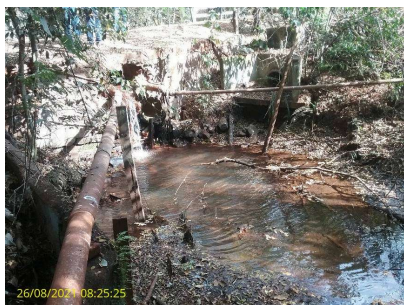
Foto 9 - Vista lateral do córrego Piripau e extravassor da elevatória Palmeiras II
