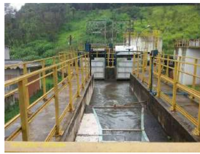
Foto 2 - Tratamento Preliminar (gradeamento)
