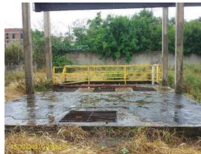
Foto 2 - Vista do interior da EEE Água Quente
