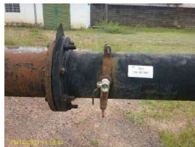
Foto 2 - Tomada de coleta de água
