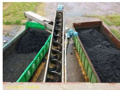
Foto 13 - Desidratação do lodo
