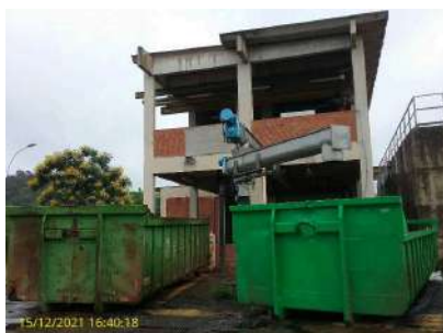
Foto 14 - Casa de desidratação de lodo
