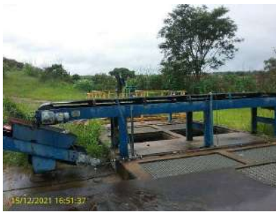
Foto 3 - Retirada de resíduos do gradeamento
