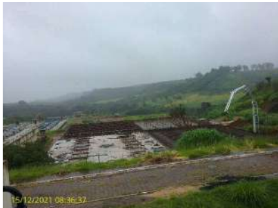
Foto 3 - Obra de ampliação da ETE
