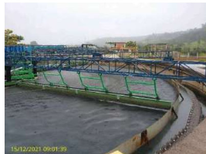
Foto 7 - Flotador 1 em operação
