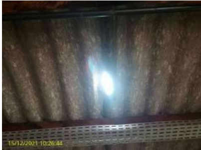
Foto 3 - Telhado quebrado
