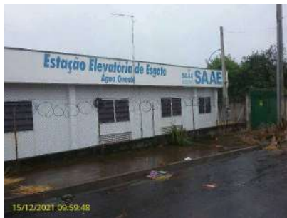
Foto 1 - EEE Água Quente
