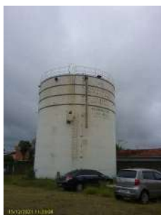
Foto 1 - Reservatório Cidade Aracy Apoiado 1
