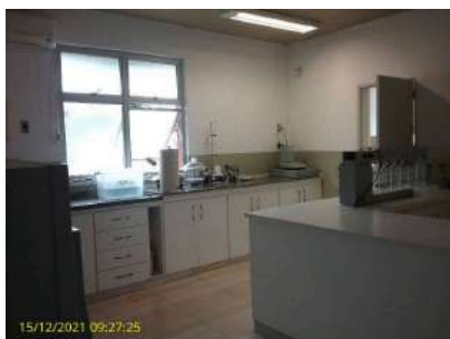
Foto 10 - Laboratório de análises da ETE
