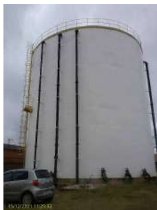
Foto 1 - Reservatório Cidade Aracy Apoiado 2
