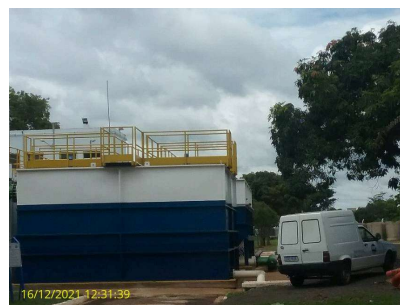
Foto 8 - Vista lateral da ETA IV
