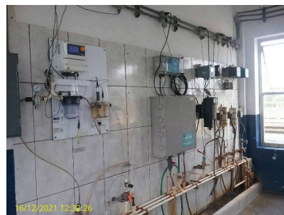
Foto 9 - Medidores on line da saída do tratamento das 3 ETAs
