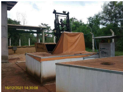
Foto 1 - Poço de sucção, com gradeamento
