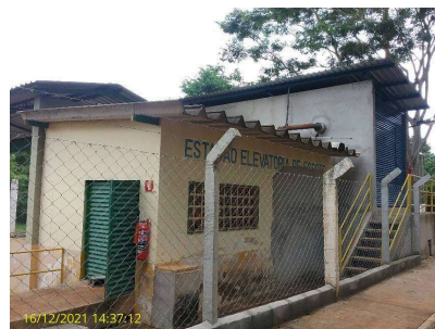
Foto 6 - Vista externa da elevatória de esgoto Laranja Azeda
