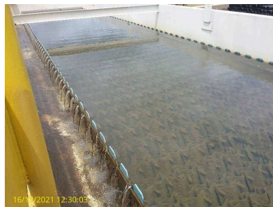
Foto 4 - Decantador de alta taxa através placas planas paralelas
