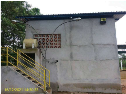
Foto 2 - Construção nova para armazenar o gerador e painéis adequadamente
