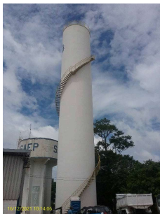
Foto 1 - Reservatório ETA II elevado
