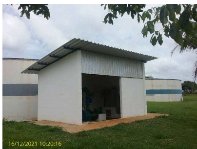
Foto 1 - EEA recalque ETA II
