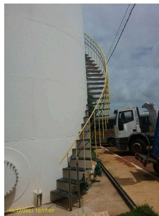
Foto 2 - Escada de acesso
