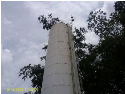
Foto 2 - Escada de acesso e guarda-corpo
