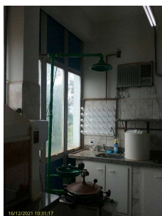
Foto 1 - Chuveiro de emergência
