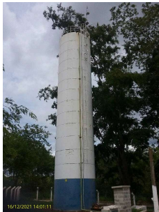
Foto 1 - Reservatório elevado Cachoeira I
